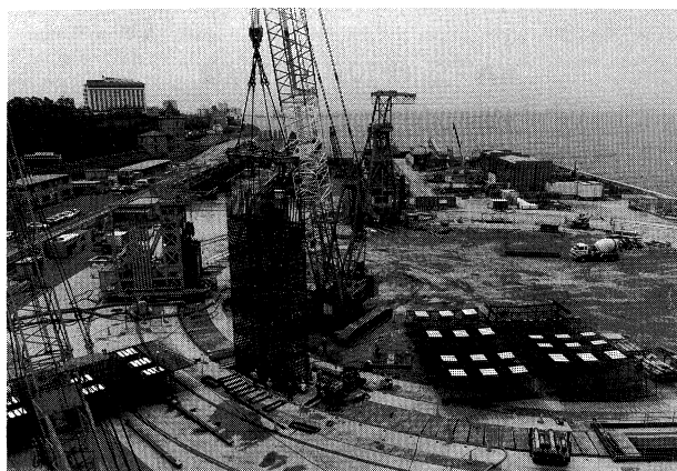
写真-4 掘削状況全景
