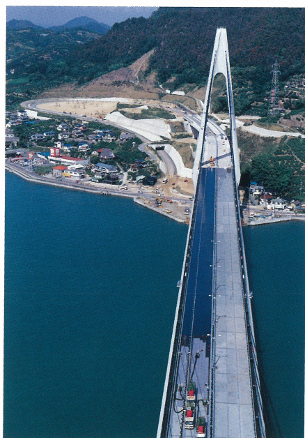
生口橋橋面舗装（研掃工及び接着層工） 施工状況
