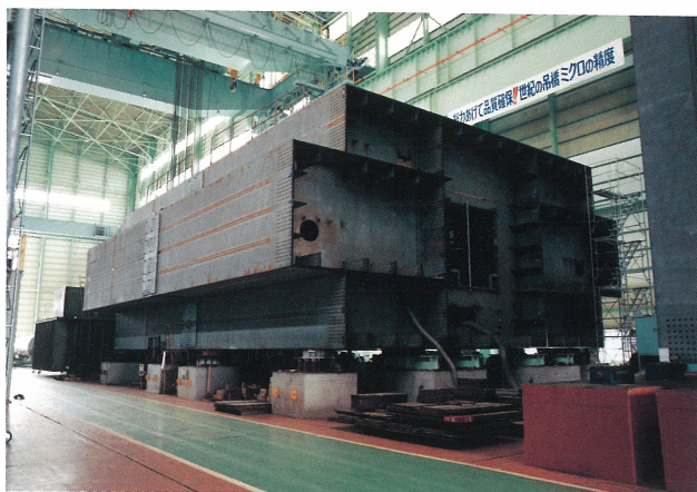
明石海峡大橋3P主塔工事（塔柱横仮組立）
