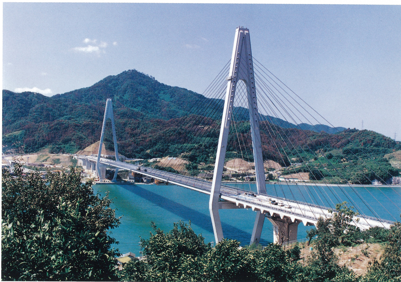
生口橋全景 橋面舗装（ゲースアスファルトコンクリート工）施工状況
