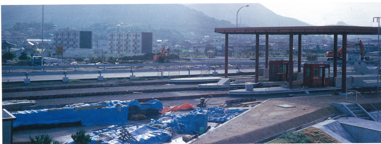
坂出IC本線料金所施設工事
