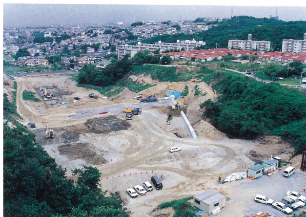
舞子トンネル準備工事（その2）
