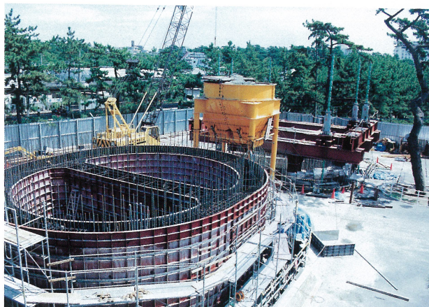
舞子高架橋下部工試験工事
