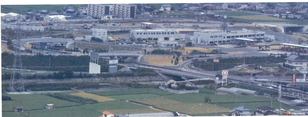
坂出IC二期工事全景
