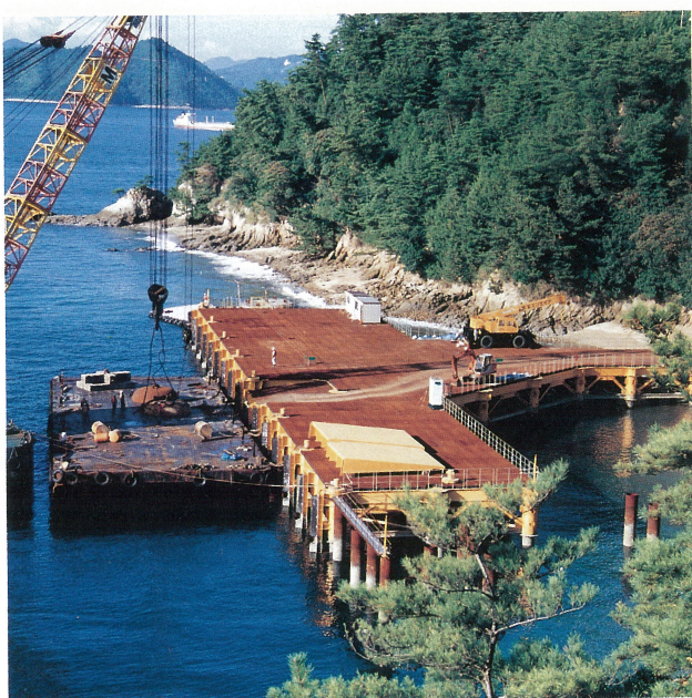
馬島北棧橋施工状況
