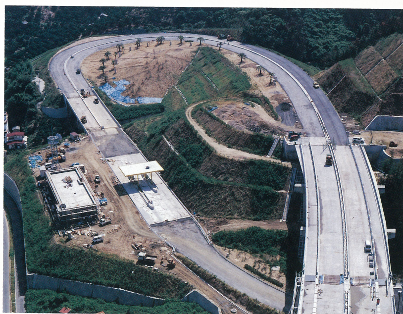
洲江側陸上部施工状況（生口橋3P塔頂より）
