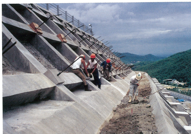
福江地区防災工事アンカー工
