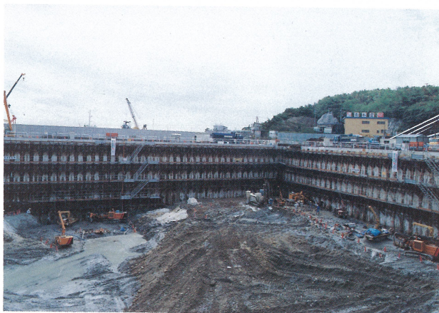
明石海峡大橋4A下部工（その2）工事（アースアンカー施工状況）
