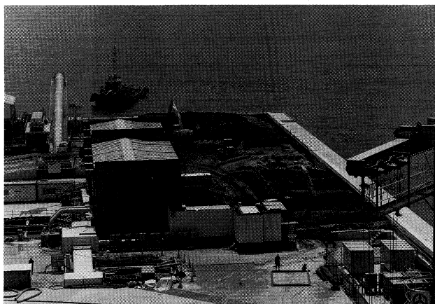
写真-8 土砂積出状況
