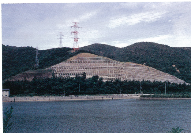
福江地区防災工事全景
