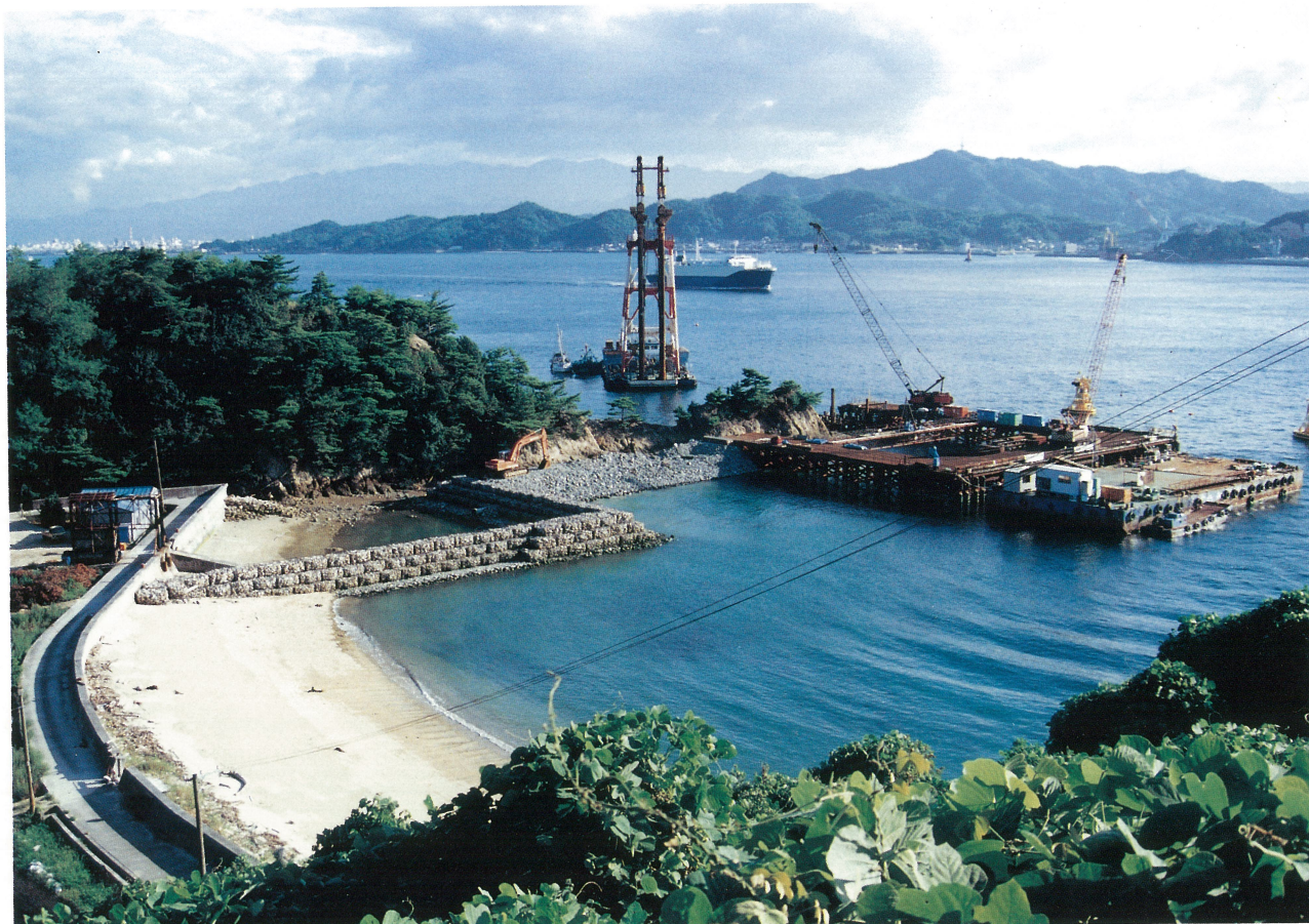
来島大橋8P作業足場施工状況
