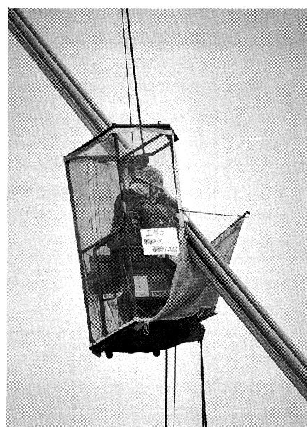
写真-2 ケーブル塗装 (チェア型ゴンドラ)
