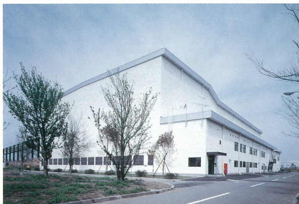
大型風洞施設（外観）
