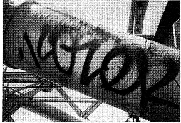
写真-16 ケーブルラッピング状況 (ウィリアムズバーグ橋)
