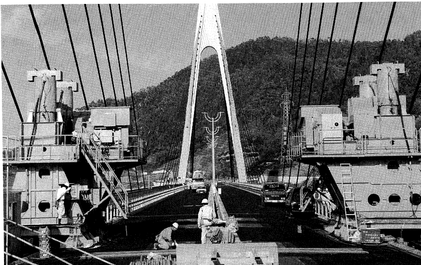
写真 生口橋振動実験
