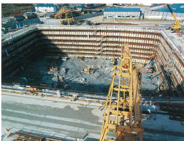
明石海峡大橋4A 掘削作業状況全景
