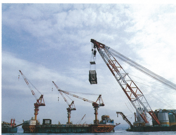
明石海峡大橋3P 下部工気中コンクリート工事
