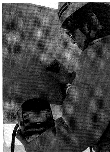
写真-1 電磁膜厚計による測定状況
