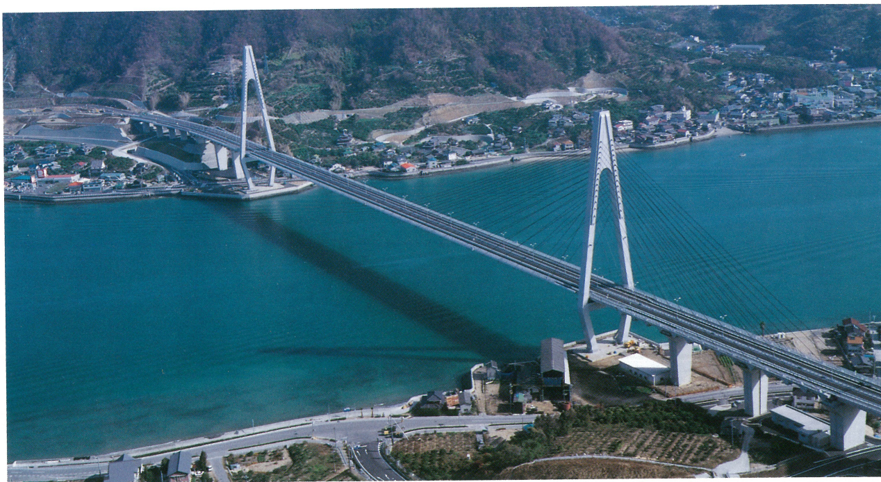
供用前の生口橋
