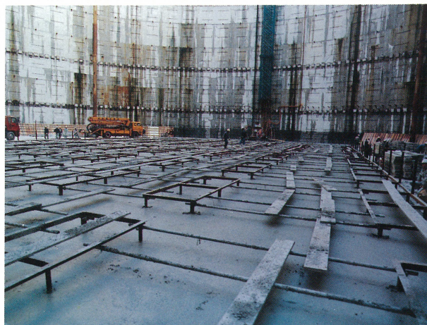
明石海峡大橋1A 底版コンクリート打設中
