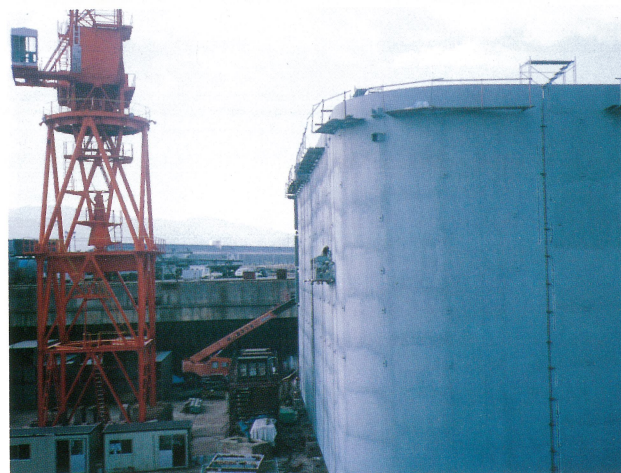
来島大橋4A鋼ケーソン工事
