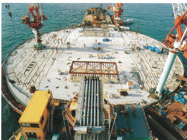
明石海峡大橋2P 気中コンクリート打設完了
