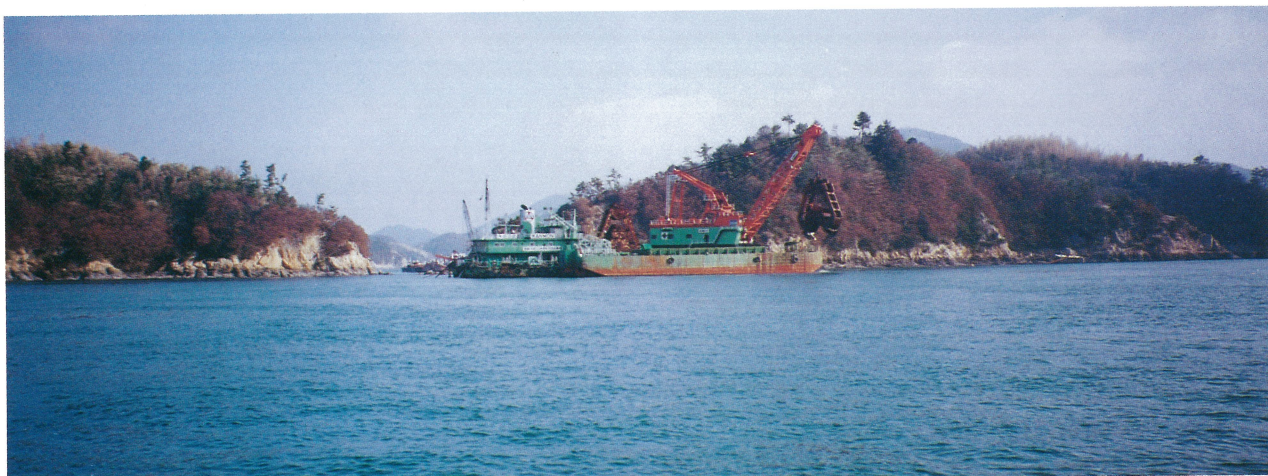
来島大橋5Pケーソン工事「関門」による直接掘削
