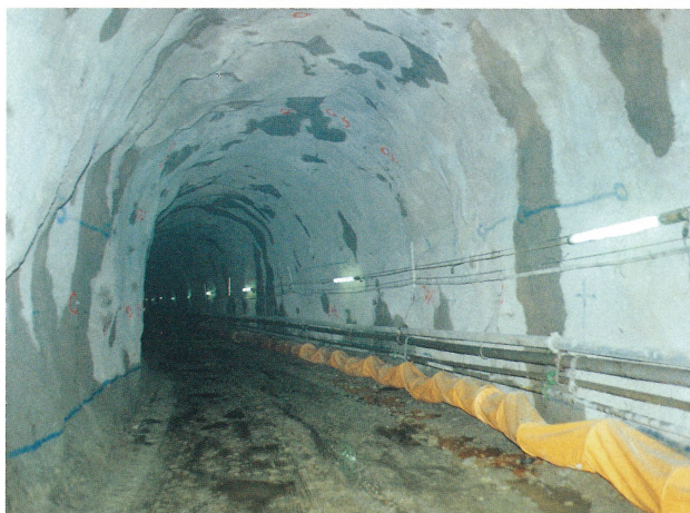
舞子トンネルシールド工事
