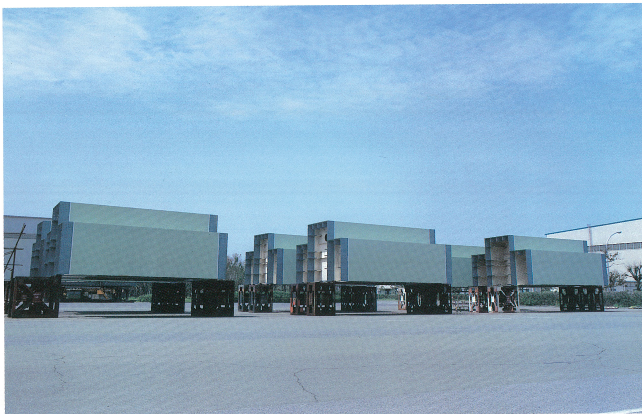
明石海峡大橋2P主塔工事 塗装完了した塔柱第14段、15段部材 2P Tower blocks of 14th level and 15th level , already painted
