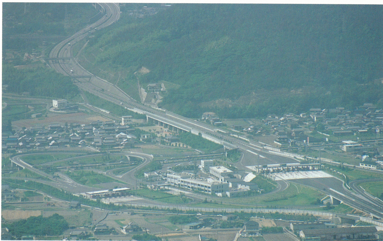
高松自動車道と連結後の坂出IC（左上方向が瀬戸中央自動車道、右下方向が高松自動車道）
