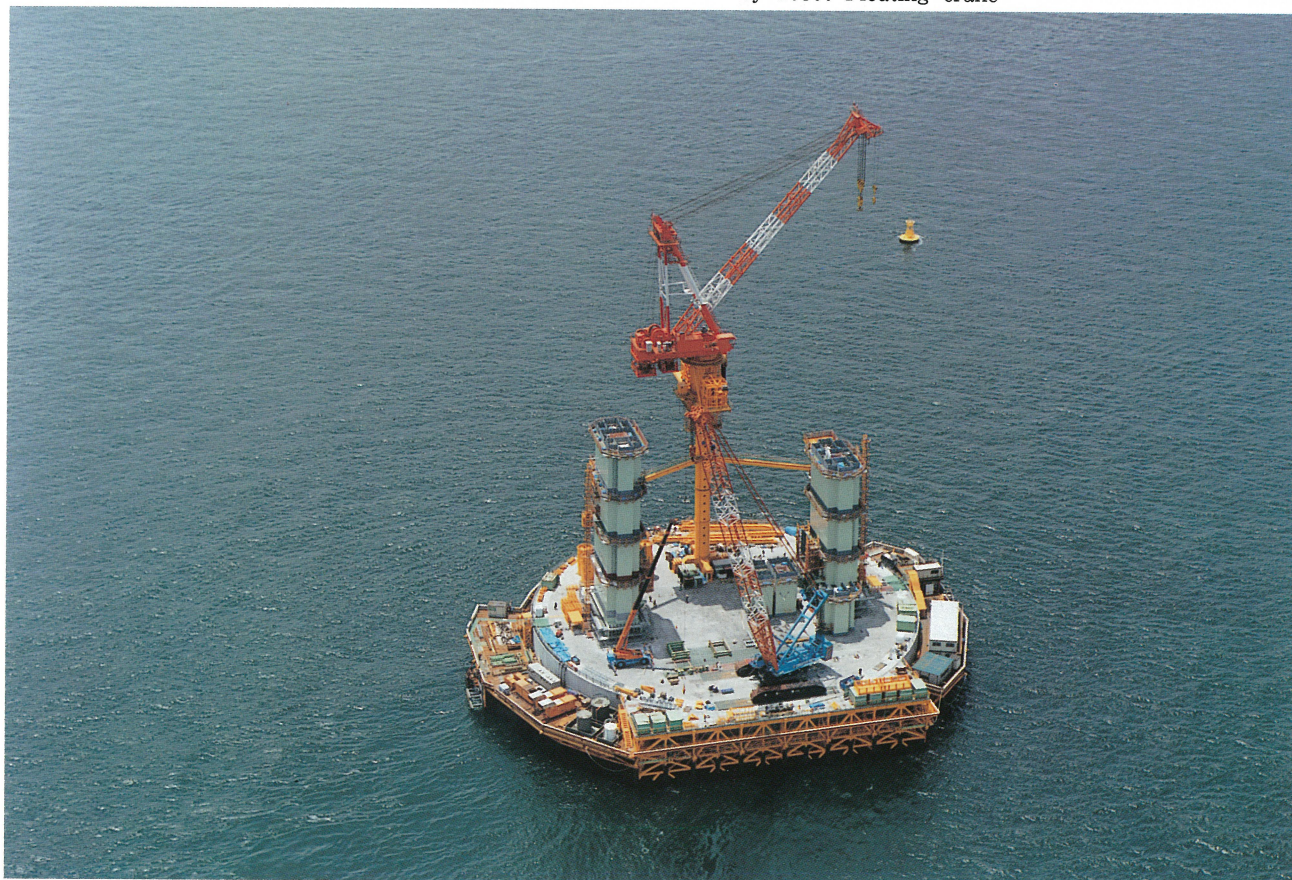
クライミングクレーンによる2P主塔の架設
