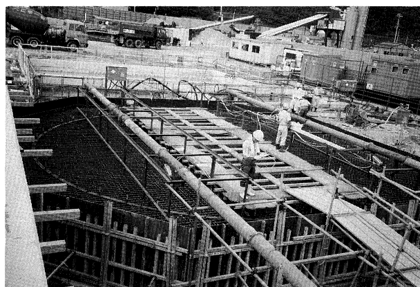
写真-2 層打ち打設実験の配管状況
