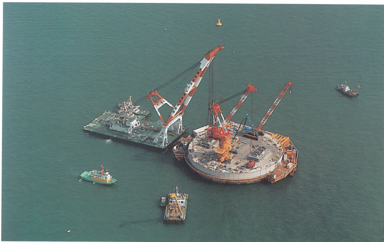
2050t吊フローティングクレーン船による2Pの底板および塔柱第一段の架設
