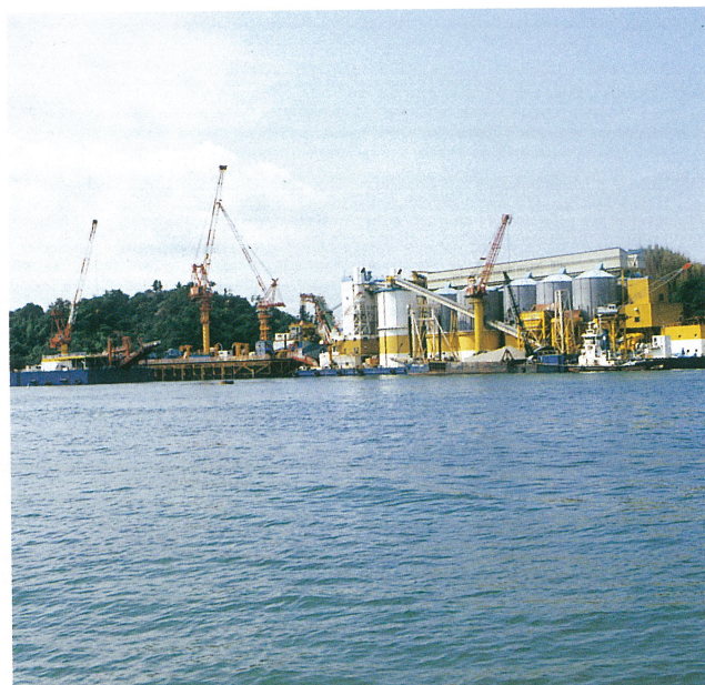
来島大橋 4A 水中コンクリート工（大型CP船の係留状況）（4年9月） Under water concrete casting for the Kurushima Bridge 4A anchorage-view of a large-capacity concrete plant barge moored at the site
