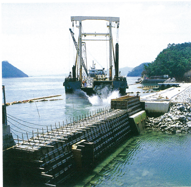
来島大橋 大島工区準備工事（被覆石投入）（4年9月） Preparatory work for the Kurushima Bridge substructures in the Oshima island-Placement of riprap
