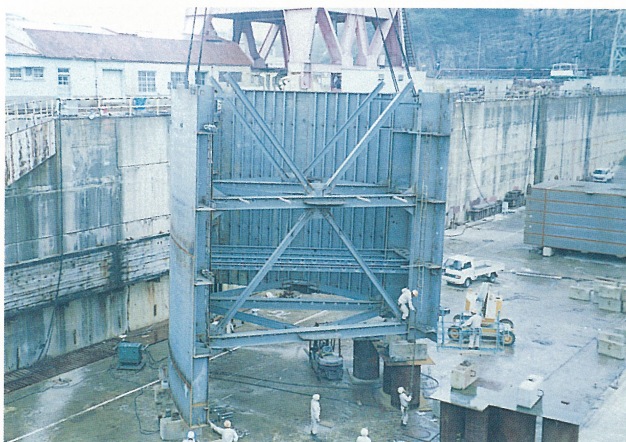
来島大橋5P (鋼ケーソン ブロック組立) (4年9月) Block assembly of the Kurushima Bridge 5P Steel Caisson
