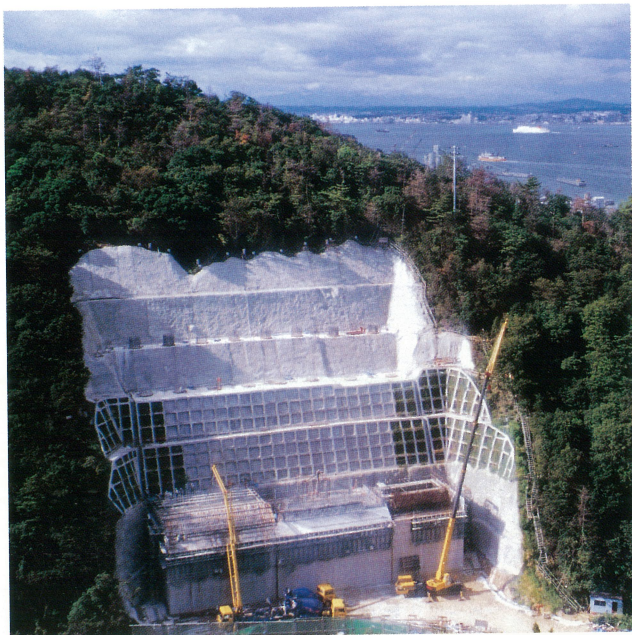
茶間川橋下部工工事 AA 1 橋台(起点側)躯体の施工状況～淡路町 (4年9月) Substructural work (Abntment AA 1 ) of the Chamagawa Bridge at Awaji-cho, Awaji-shima island
