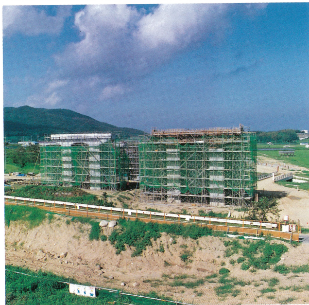
育波川橋下部工工事 P 1 , P 2 橋脚の施工状況～北淡町 (4年8月) Substructural work (Pier P 1 & P 2 ), of the Ikuhagawa Bridge at Hokutan-cho
