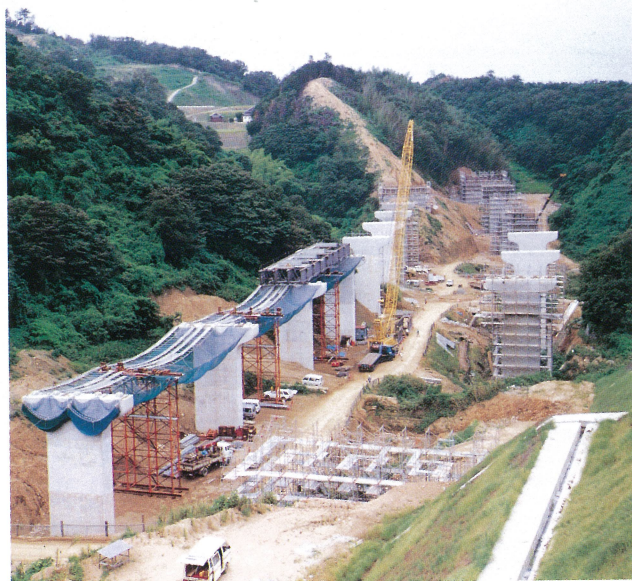
川井谷高架橋下部工工事 下り線下部工概成～北淡町 (4年8月) Substructural work of the kawai-dani Viaduct at Hokutan-cho, Awaji-shima island
