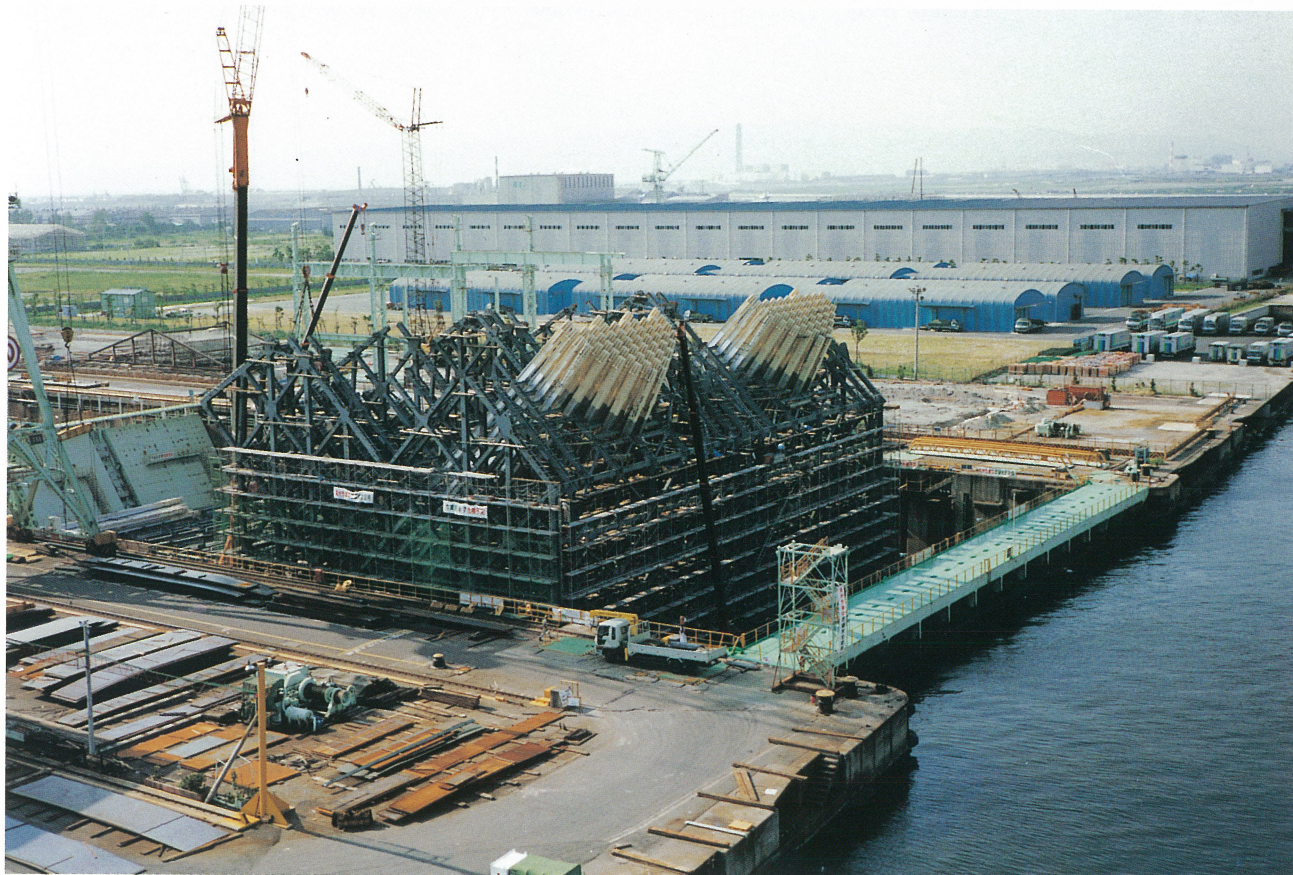
明石海峡大橋 1A ケーブルアンカーフレームの地組立
