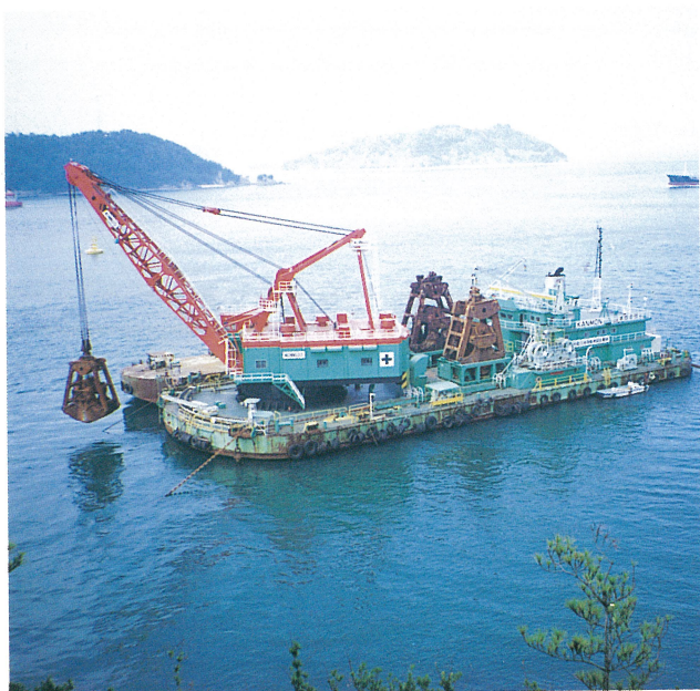
来島大橋 5P 海底掘削工（仕上げ掘削状況）（4年9月） Finishing excavation on the seabed for the Kurushima Bridge 5P pier
