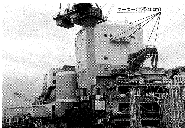
写真-2 CP 船に設置したマーカー Photo.2 Markers installed on the concrete plant barge
