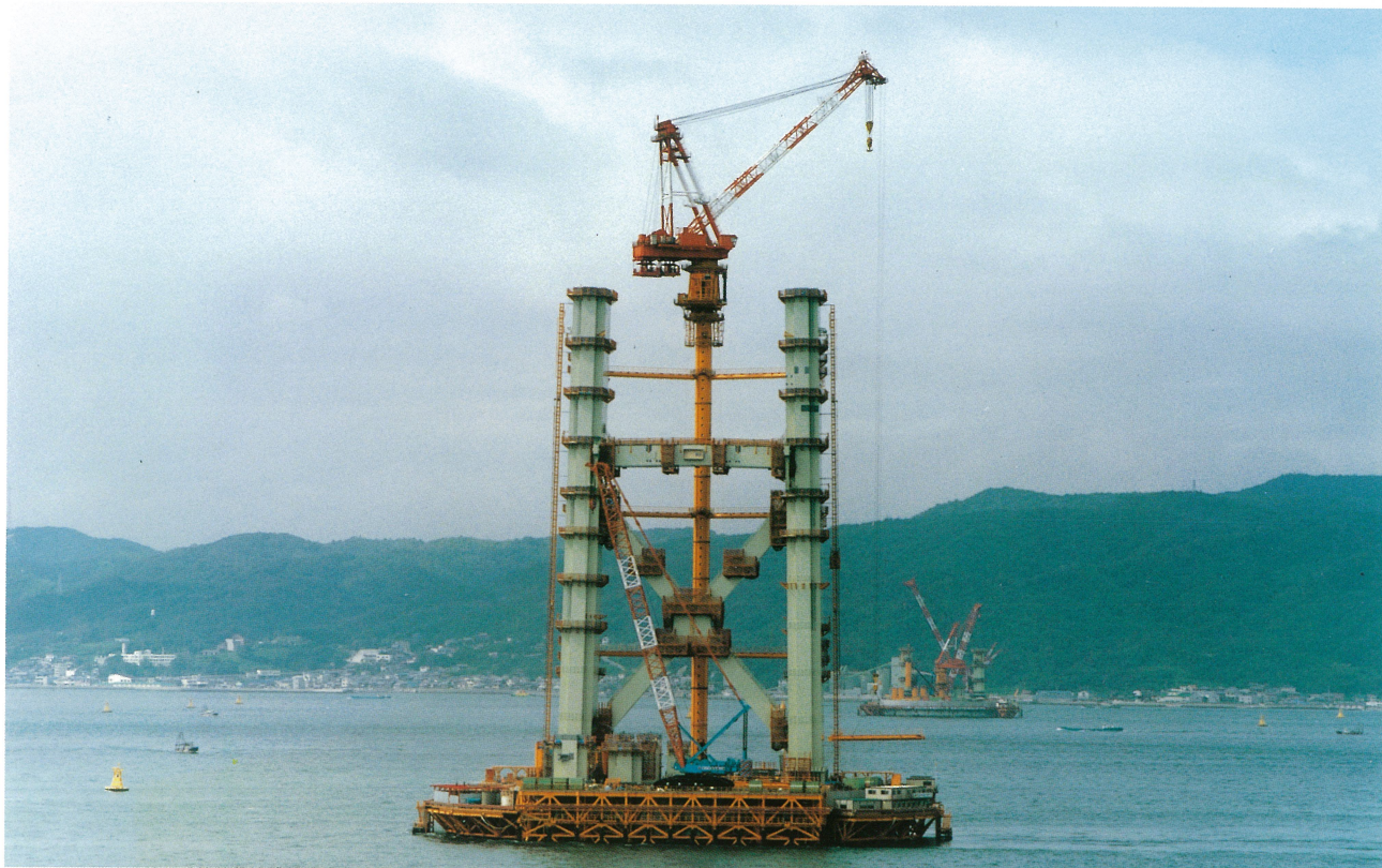
明石海峡大橋主塔の架設 (手前が2P)
