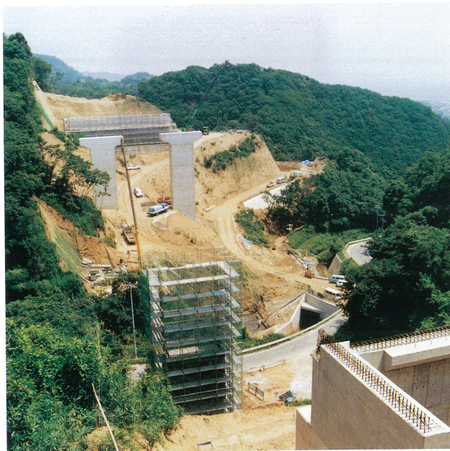
一谷川橋他1橋下部工工事 一谷川橋下部工の施工状況～東浦町 (4年8月) Substructural work of the Ichitani gawa Bridge at Higashiura-cho, Awaji-shima island
