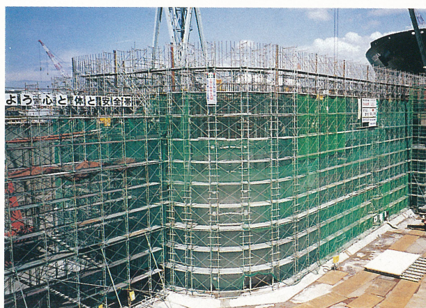
来島大橋9P (RCケーソン製作状況) (4年9月) Concrete casting for the Kurushima Bridge 9P RC Caisson
