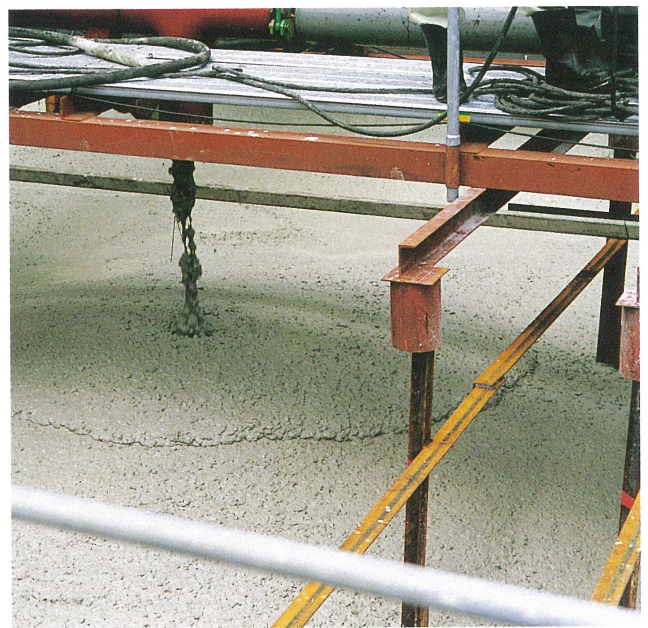
明石海峡大橋4A アンカレイジ打設地点の高流動コンクリートの流動状況 Flowing shape of highly - superplasticized concrete in casting for the Akashi Kaikyo Bridge 4A Anchorage
