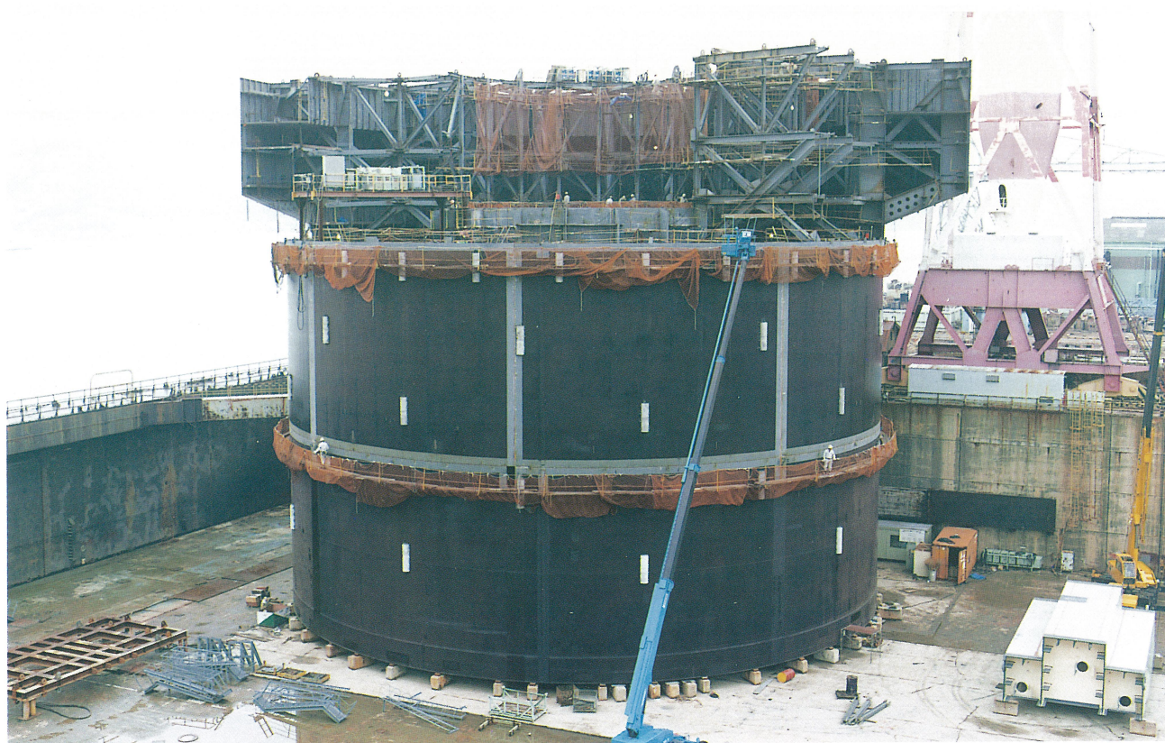
来島大橋5P (鋼ケーソン渠中大組立)
