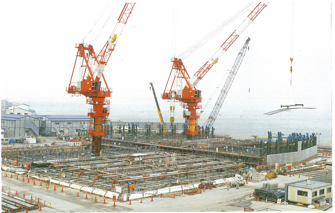
明石海峡大橋4A アンカレイジコンクリート打設状況 Concrete casting for the Akashi Kaikyo Bridge 4A Anchorage
