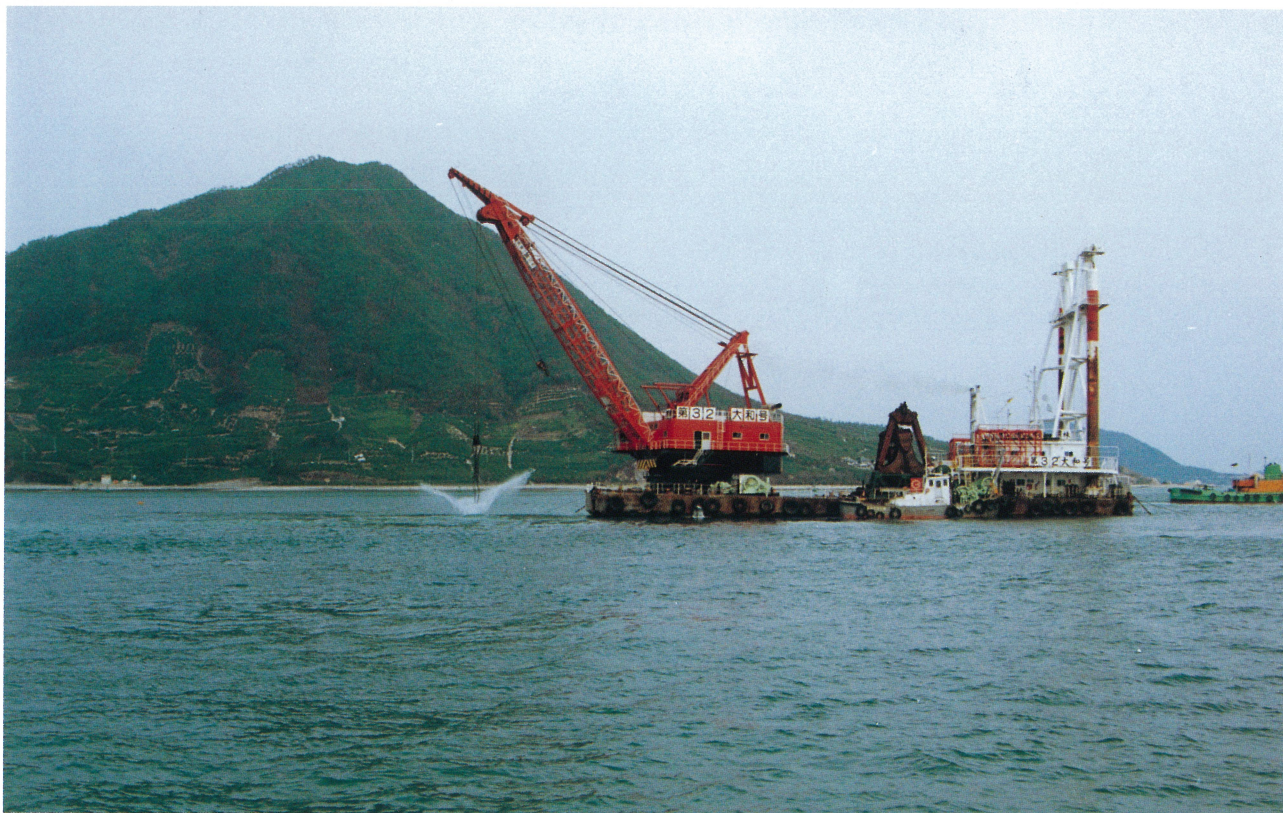
多々羅大橋3P: 大型グラブ船による砕岩掘削
