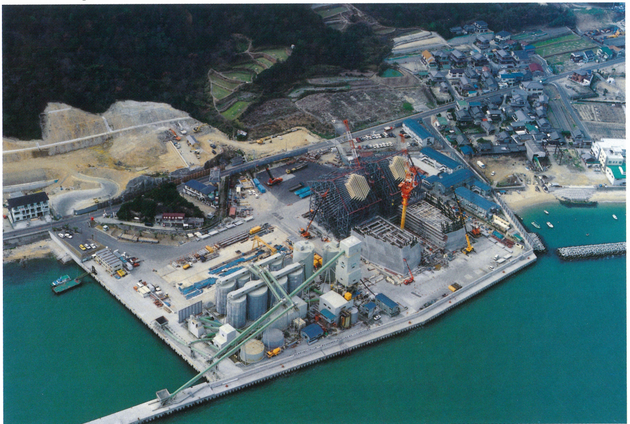
明石海峡大橋4A アンカレイジ躯体コンクリート打設 Concrete Casting for the Akashi Kaikyo Bridge 4A Anchorage
