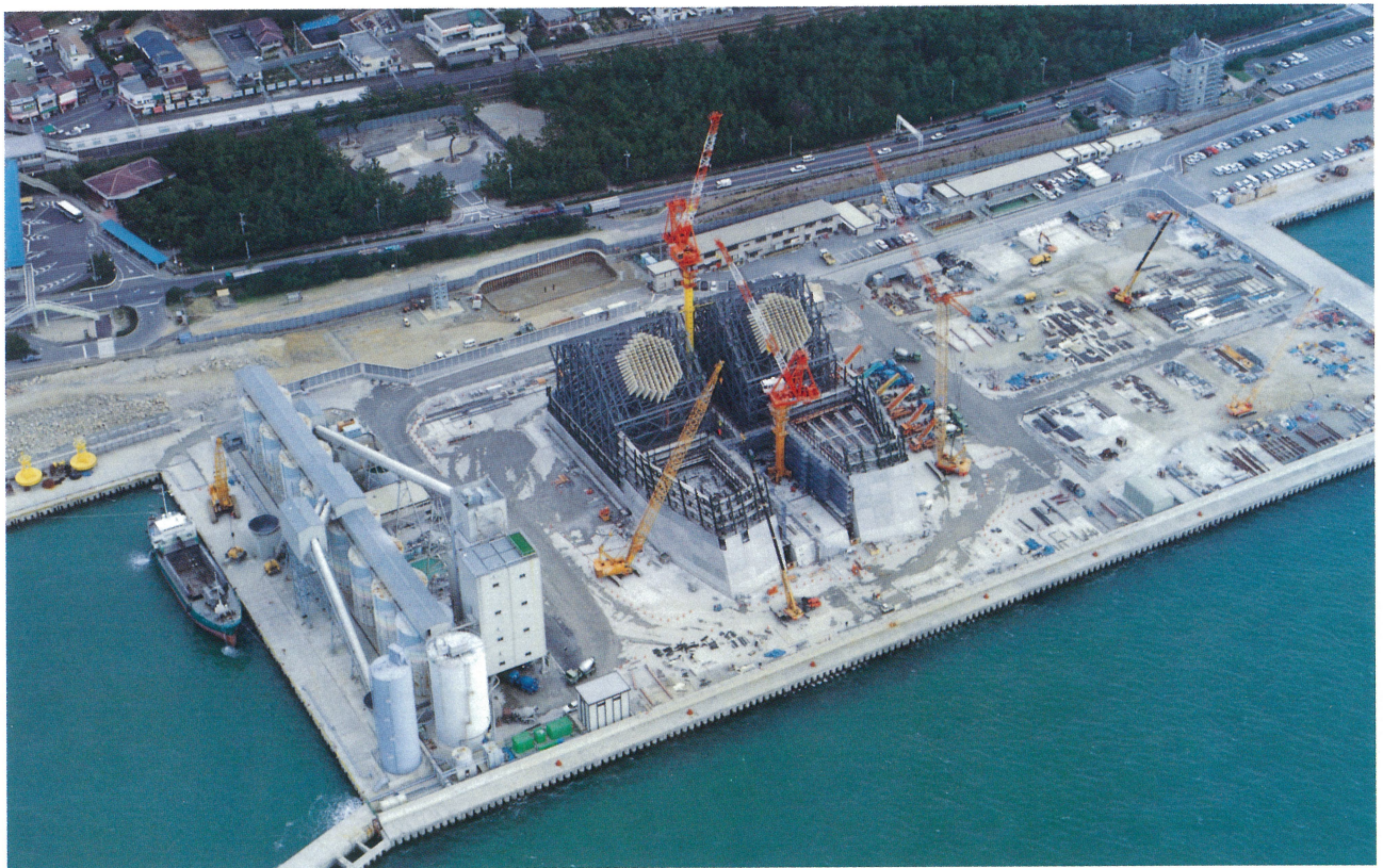
明石海峡大橋1A アンカレイジ躯体コンクリート打設 Concrete Casting for the Akashi Kaikyo Bridge 1A Anchorage
