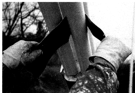
写真-13 ケーブル狭陰部ケレン工具
