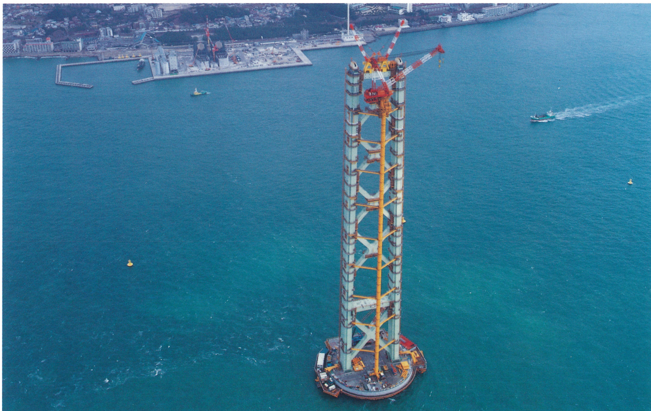
明石海峡大橋 2P 主塔架設完了
