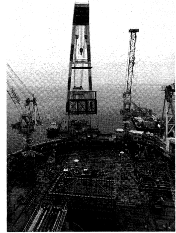
写真-5 主塔アンカーフレーム据付 (2P) Photo.5 Placement of the tower anchor frame for 2P foundation
