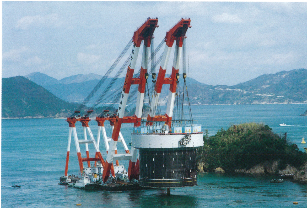
来島大橋5P: 鋼ケーソンの設置
