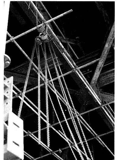
写真-21 作業床架設 (チェーンブロック) Photo.21 Installation of the work platform(chain block)
