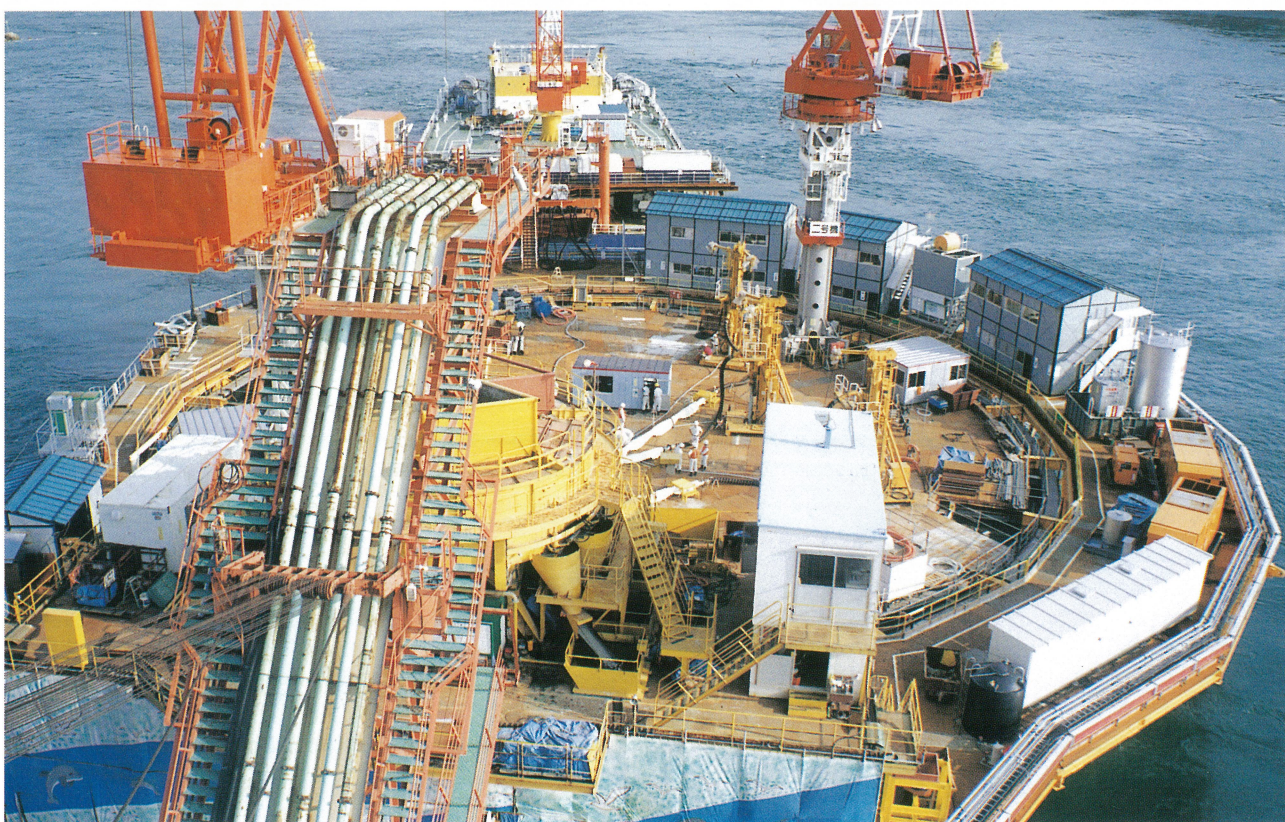
来島大橋5P水中コンクリート打設
