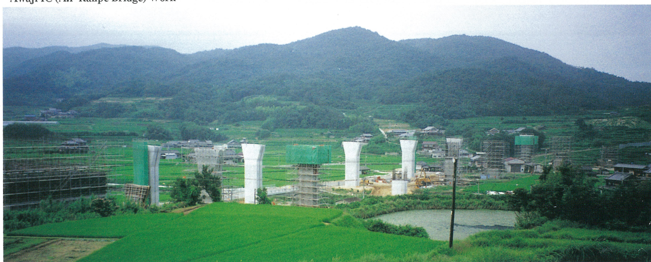
下部工施工中の室津高架橋 Substructural Work of Murotsu Viaduct
