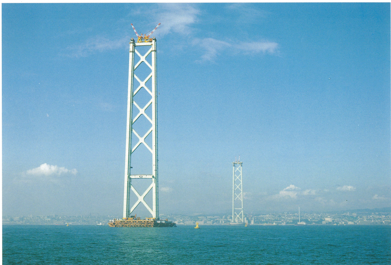
主塔が完成した明石海峡大橋 Completed Towers of Akashi Kaikyo Bridge
