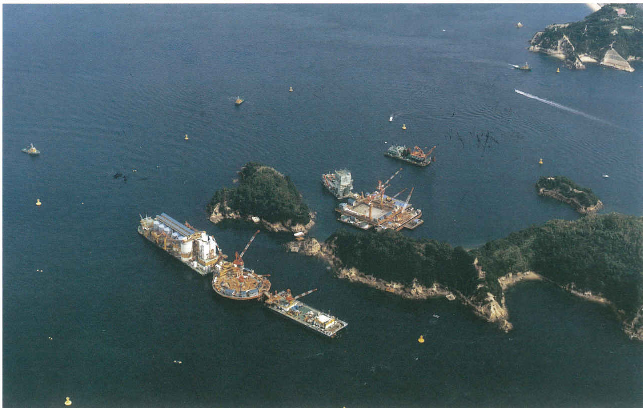
来島大橋3P、4A、5P工事現況(手前が5P)
