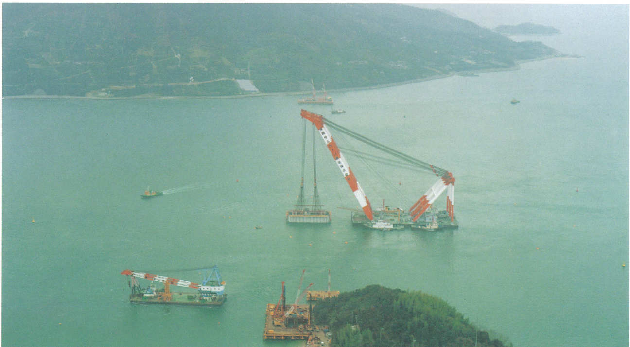
多々羅大橋3P鋼ケーソン沈設作業
