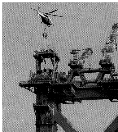
パイロットロープ渡海中の状況
