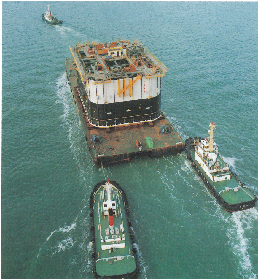
多々羅大橋3P鋼ケーソン輸送
