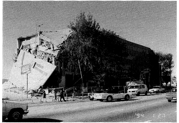
写真-16 カイザー・パーマメント病院の倒壊。左右両端と、1F～2F間が破壊した。
