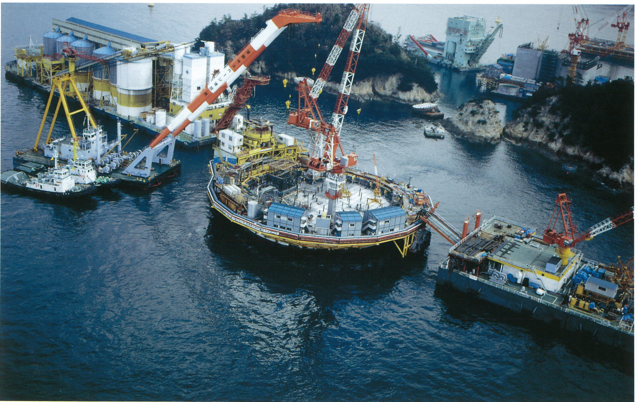
来島大橋5P塔アンカーフレーム設置作業
