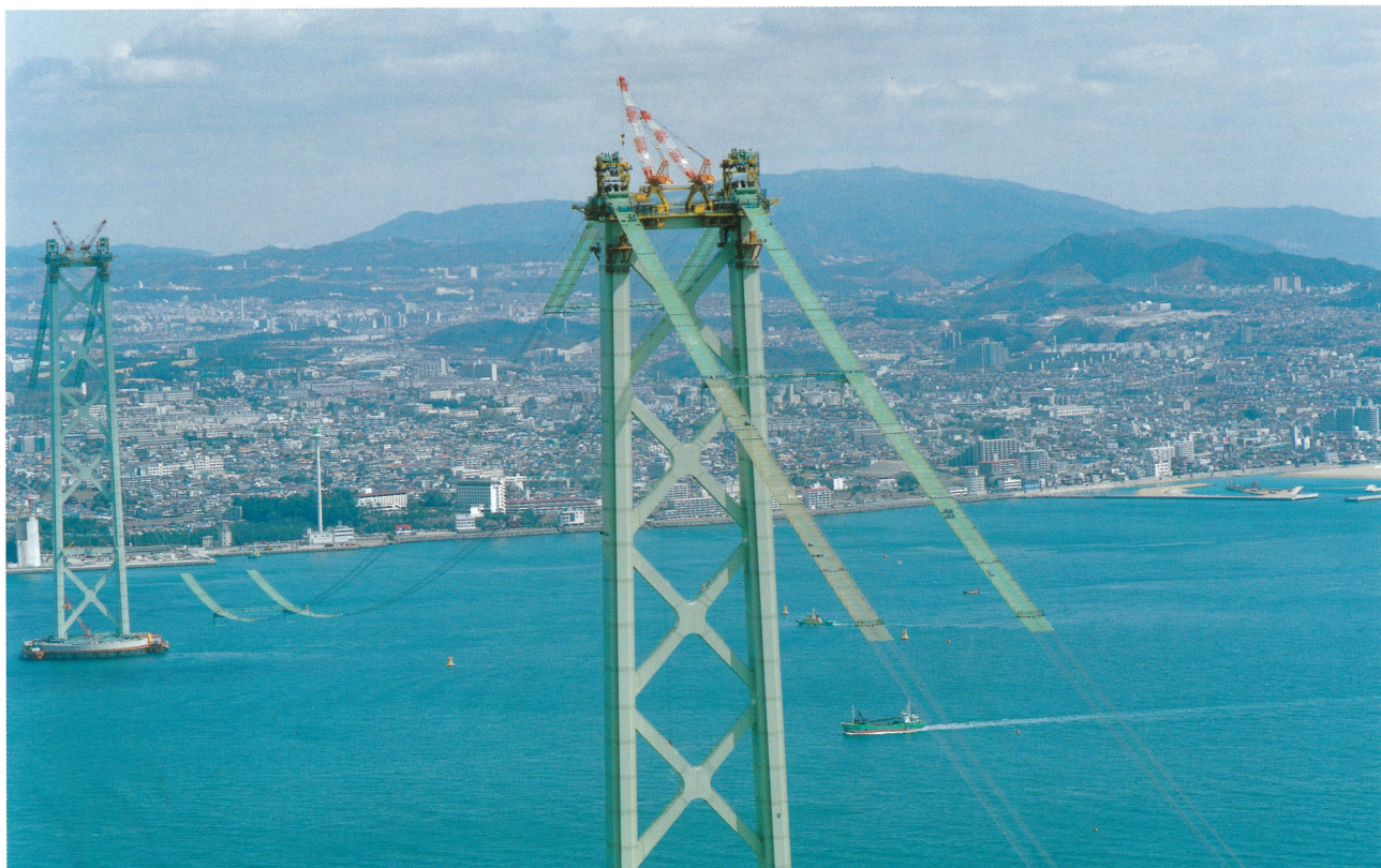
明石海峡大橋キャットウォーク架設状況(1)
