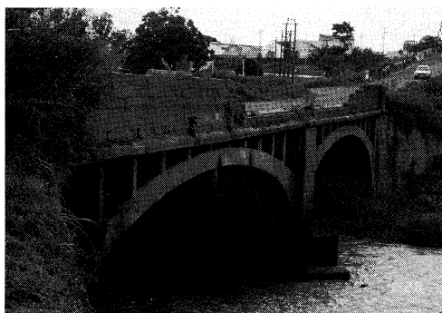
写真－4 ルイル川アーチ橋(34地区) Photo.4 Ruiru River Arch Bridge(Area 34)
