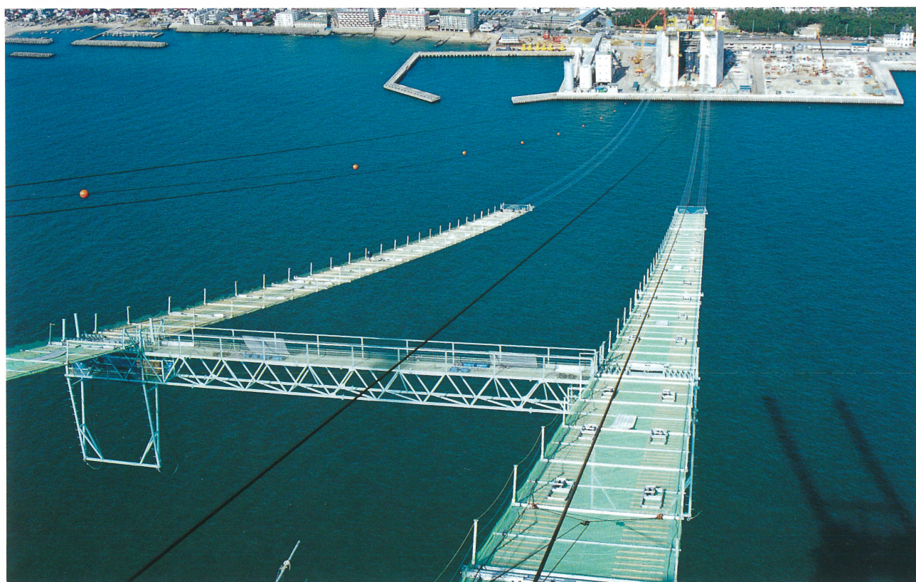
明石海峡大橋キャットウォーク架設状況(2)
