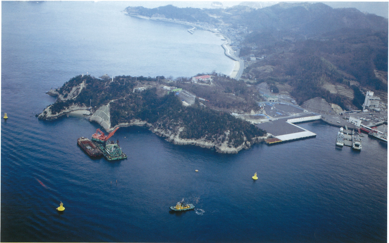
来島大橋下部工工事現況 (2P、P1、1A)
