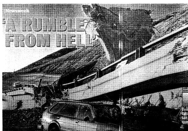
写真-13 S-14・インターチェンジ橋の落橋。 現地版“Newsweek”（Jan.31, 1994）による。
