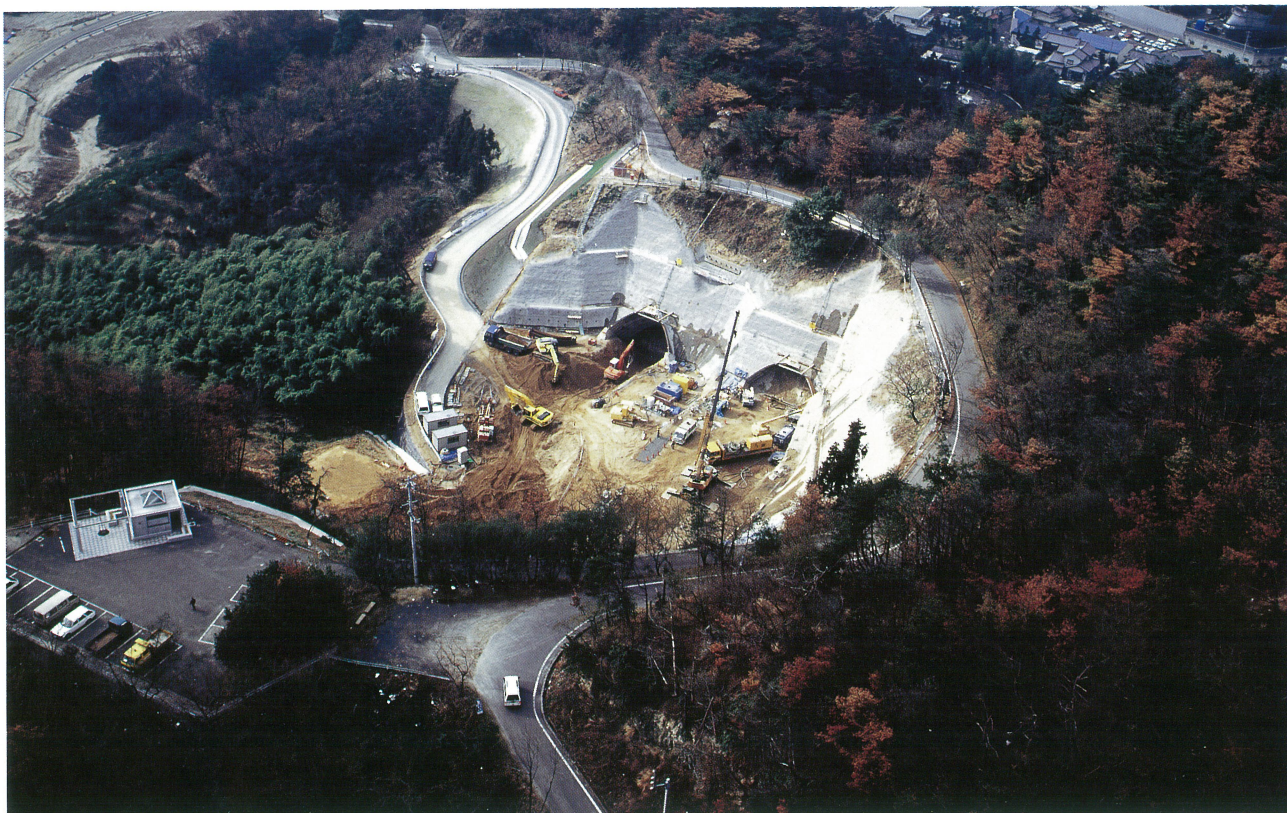
来島大橋 10A アンカレッジ工事現況
