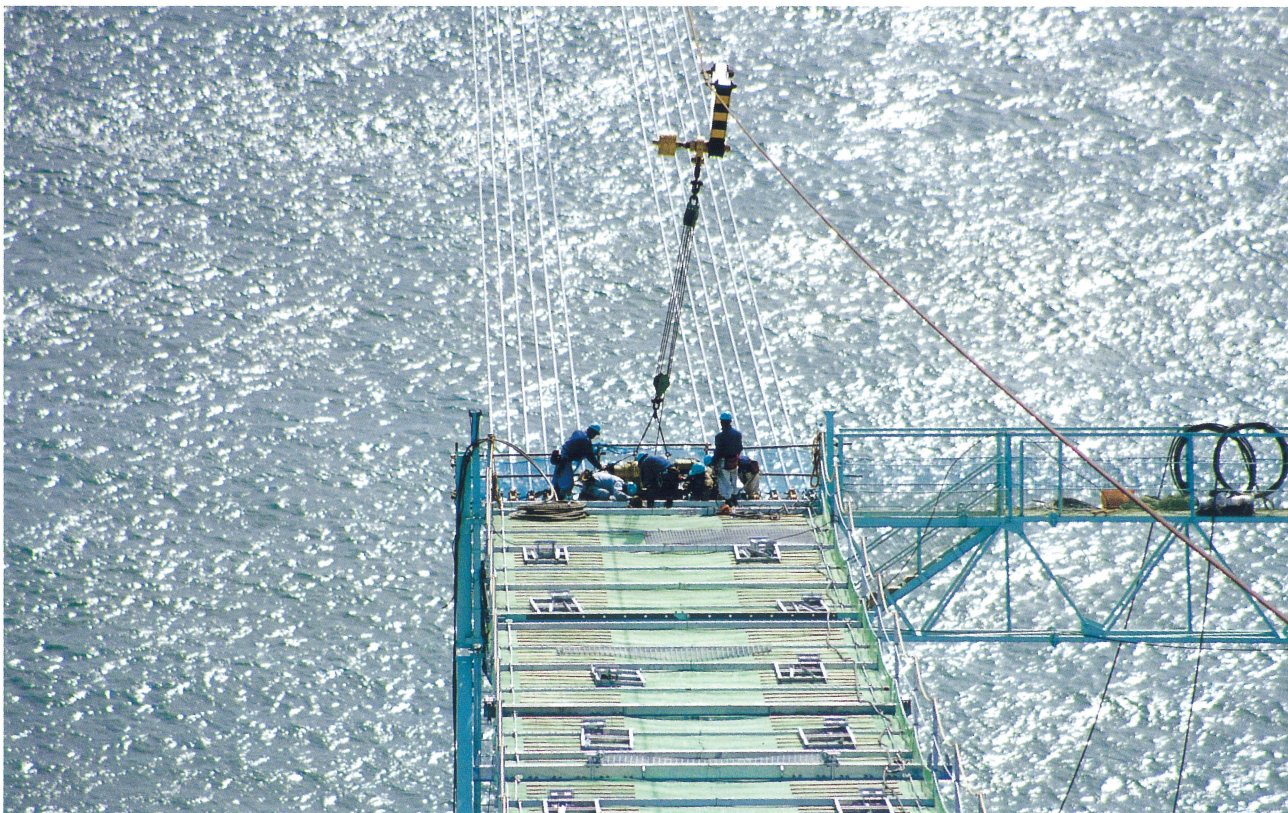
明石海峡大橋キャットウォーク架設状況(3)
