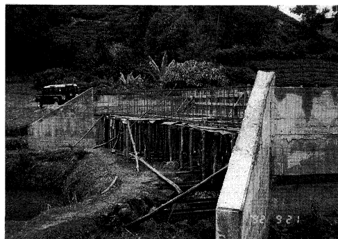
写真－8 ルイル橋建設現場(34地区) Photo.8 Construction of the Ruiru Bridge(Area 34)
