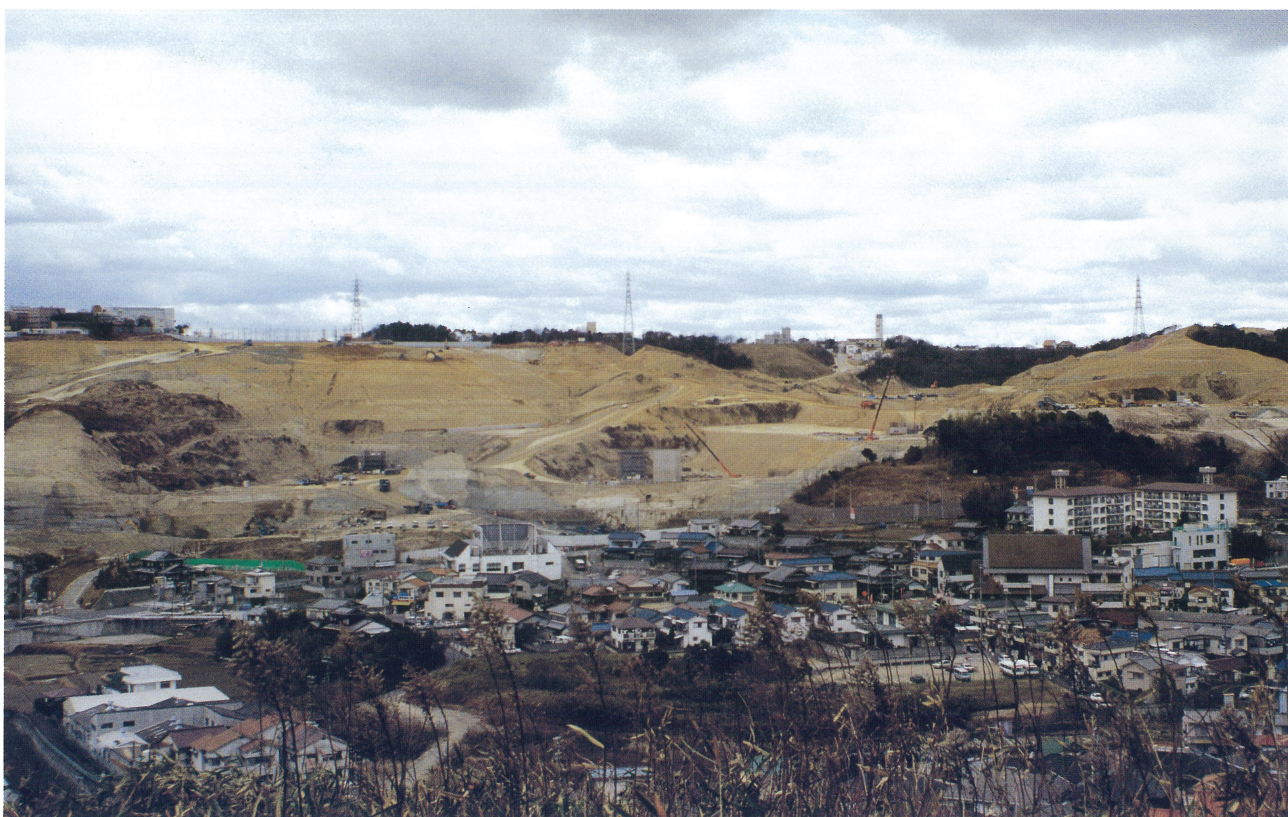
垂水J.C.T. の工事現況
