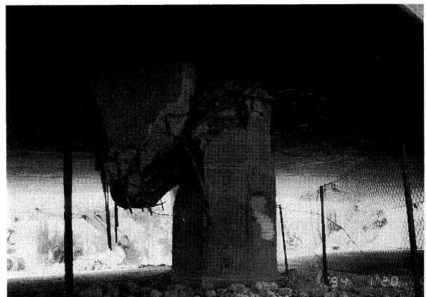
写真-5 橋脚の圧壊状況。橋脚が完全に分断されている。
