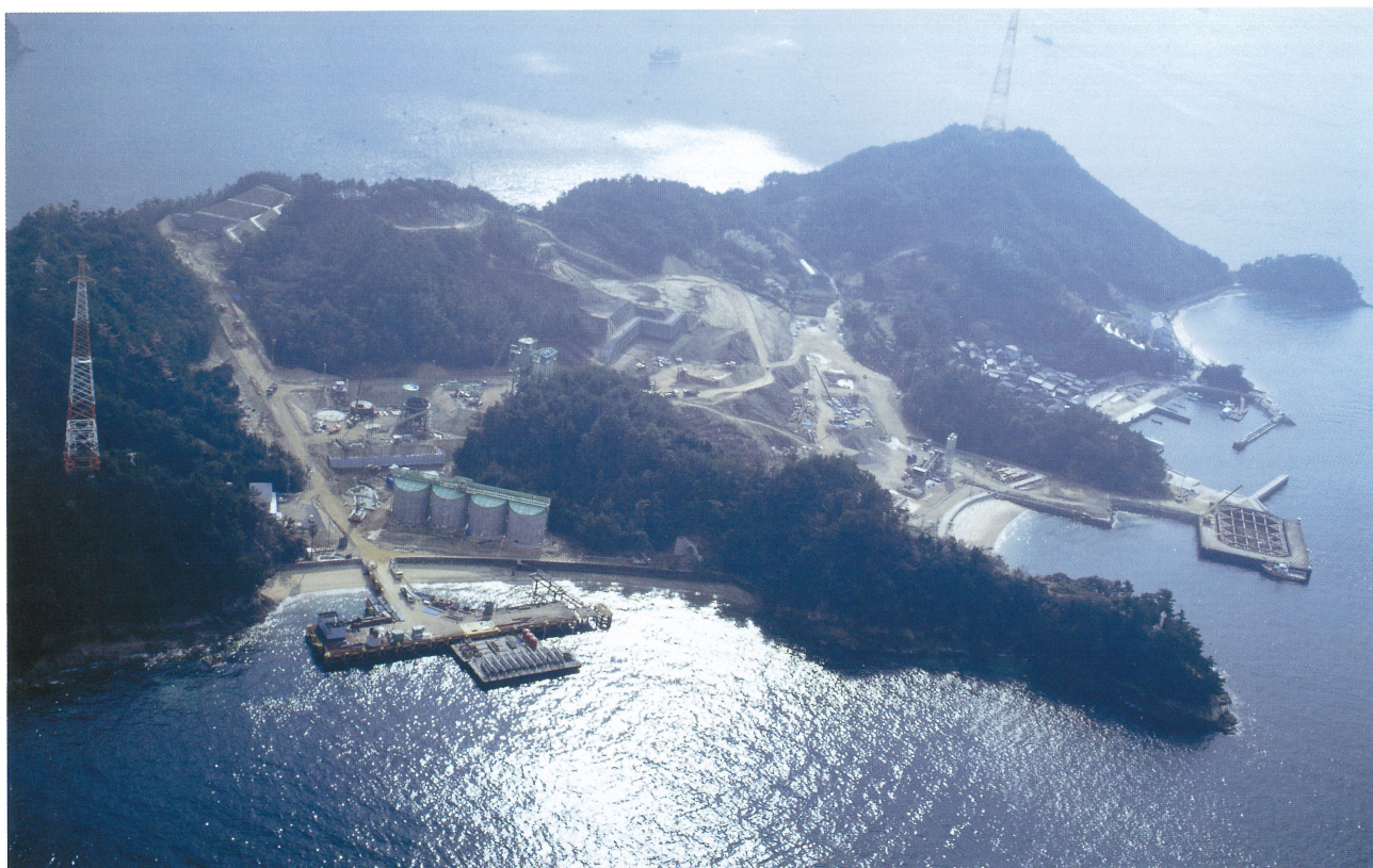
来島大橋下部工工事現況 (馬島島内)
