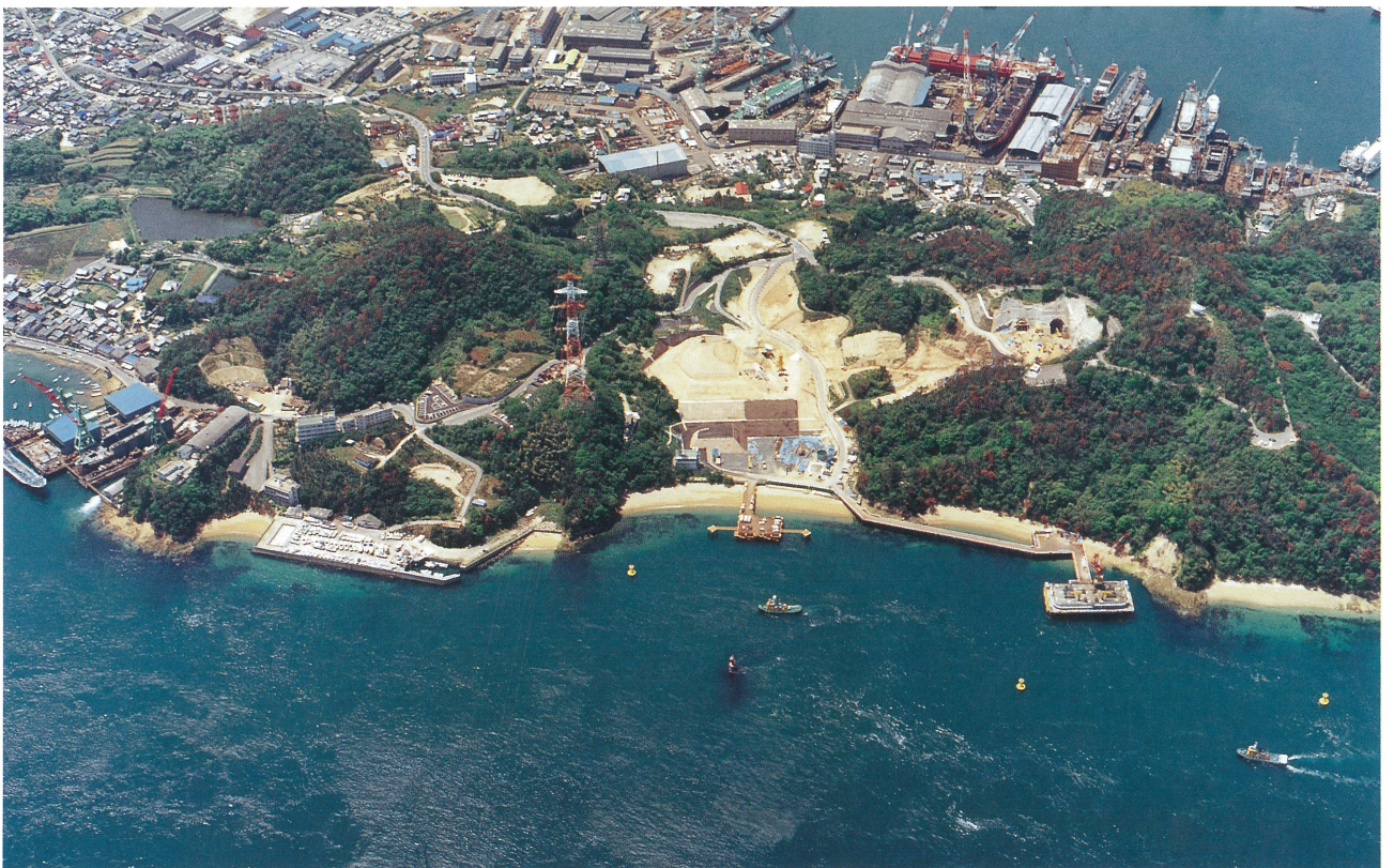
来島大橋下部工工事現況(9P、10A)
