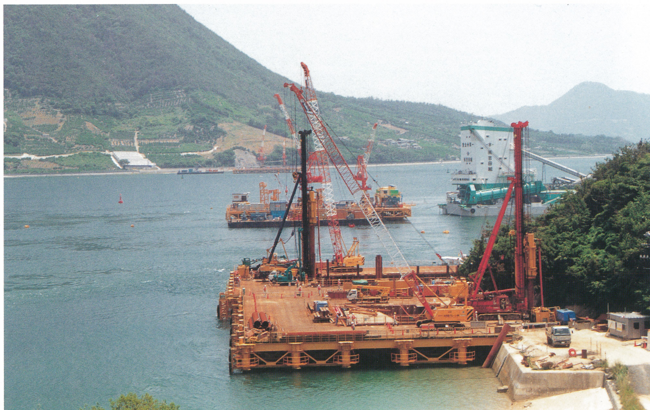
多々羅大橋下部工工事現況(大三島側より)
