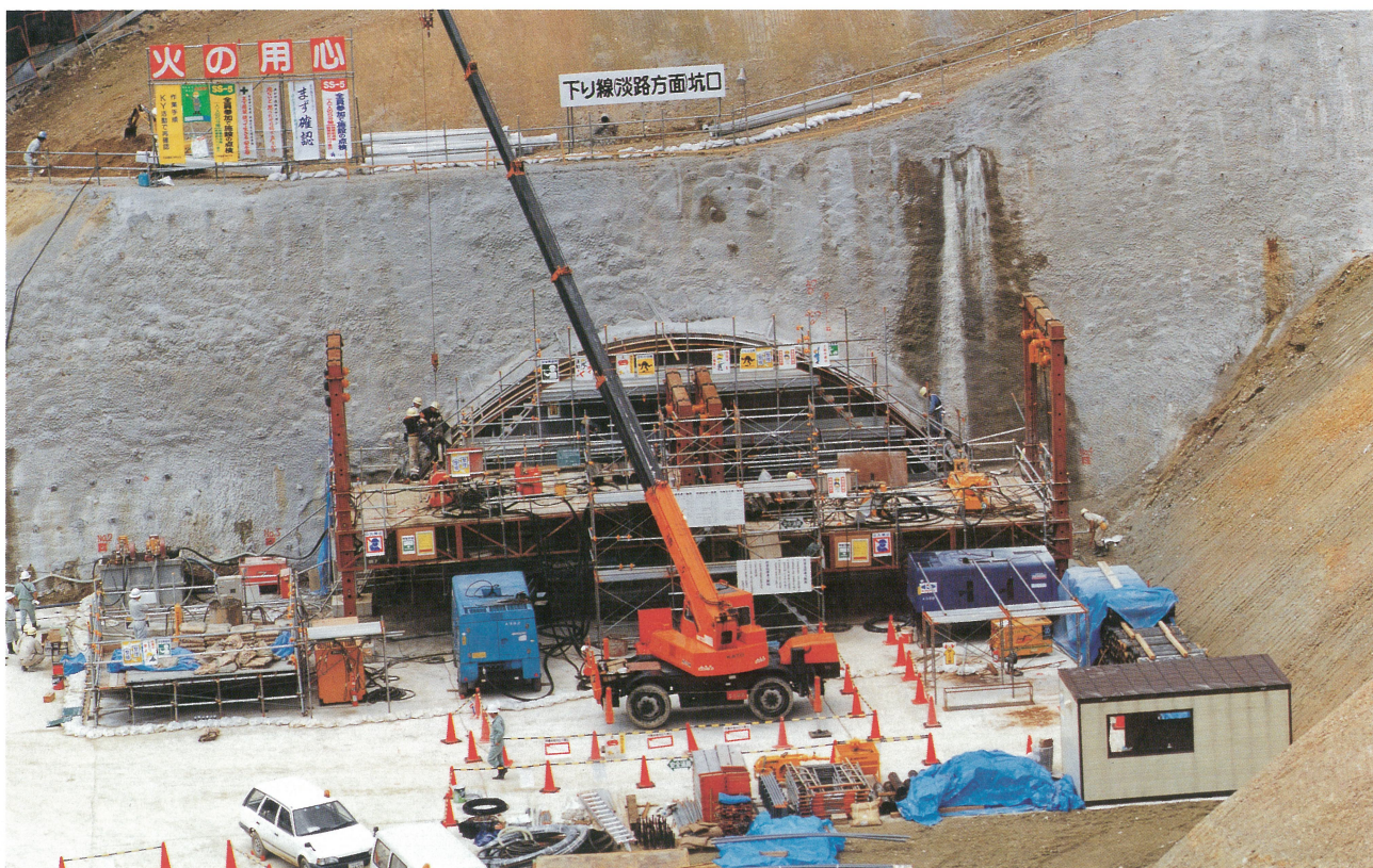
舞子トンネル北坑口施工状況(パイプブルーフ工) Recent view of Maiko Tunnel North Portal Work(Pipe Roof Method)
