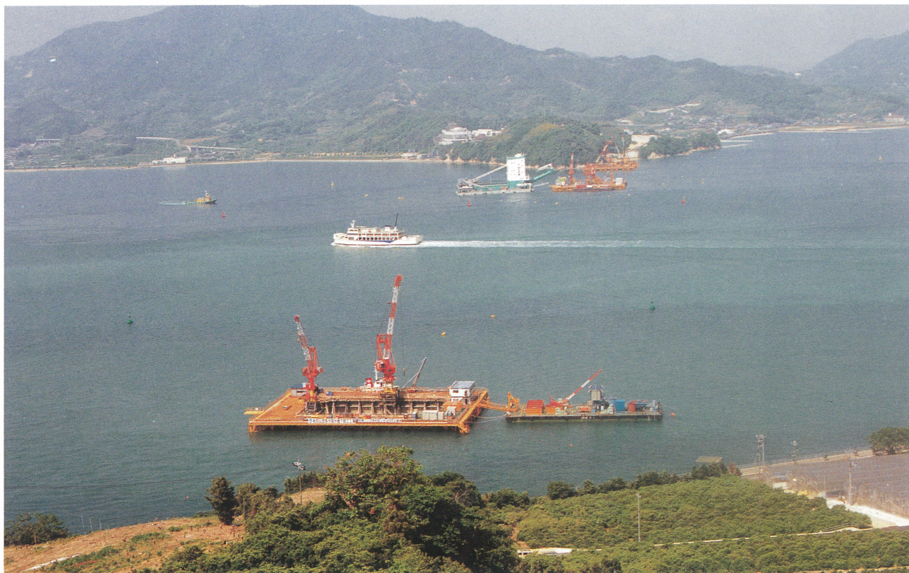
多々羅大橋下部工工事現況(生口島側より)
