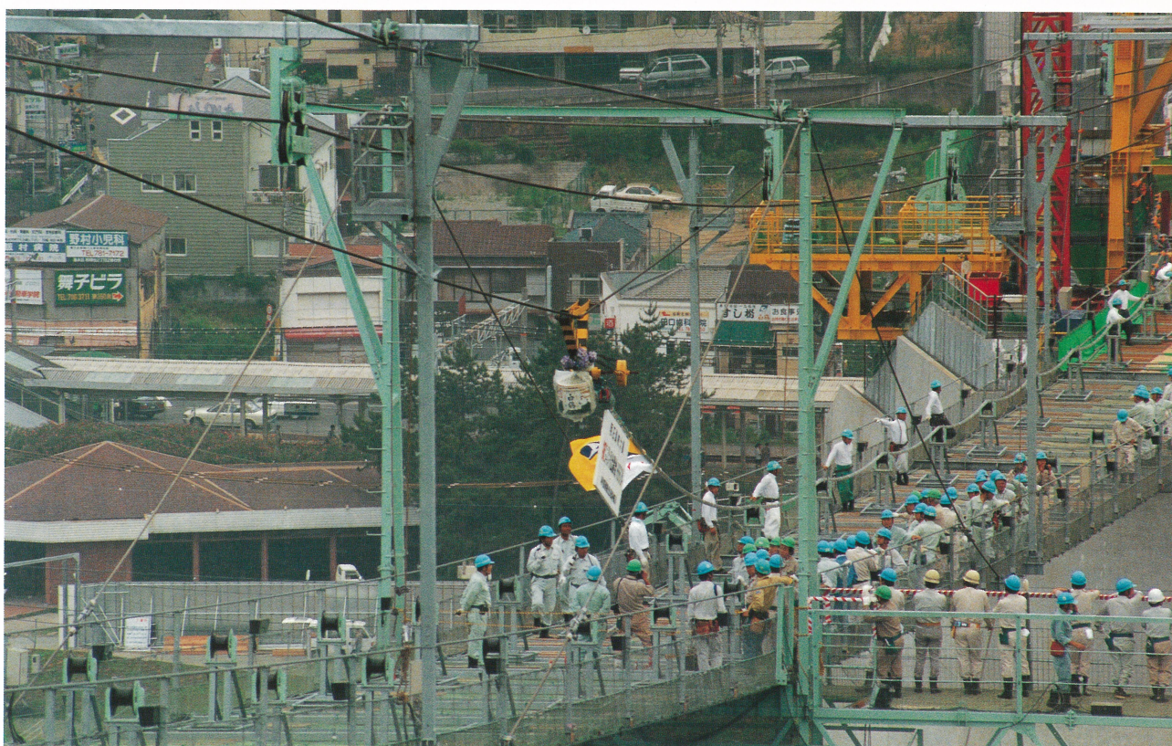
明石海峡大橋ストランド引き出し開始 Start of strand extension operation for Akashi Kaikyo Bridge
