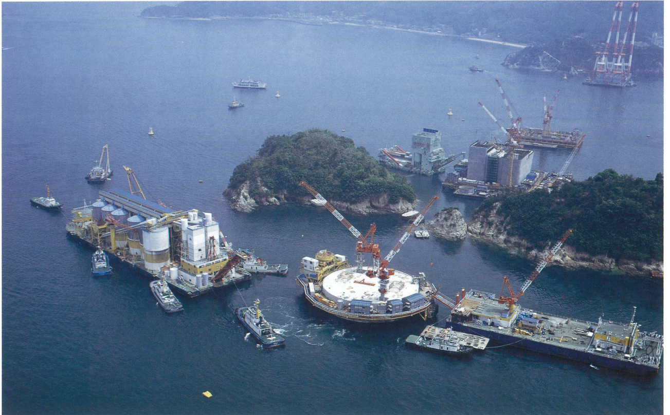
来島大橋下部工工事現況(2P、3P、4A、5P)
