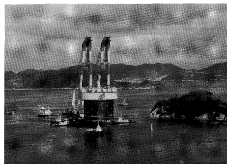
来島大橋5Pケーソン設置状況
