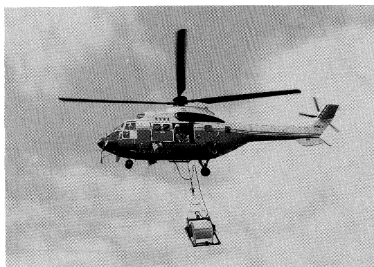
写真-5 延線機のブレーキ操作状況 Photo.5 Braking manipulation of unreeler
