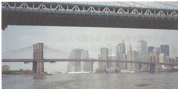
写真-10 ブルックリン橋(供用110年) Photo.10 Brooklyn Bridge—110 years in use
