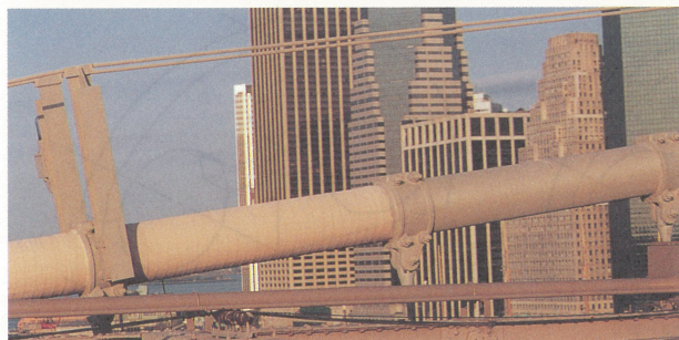
写真-12 左側 ゴムラッピング+塗装 右側 ワイヤラッピング+塗装 Photo.12 Left half :Rubber wrapping plus coating Right half : Steel-wire wrapping plus coating
