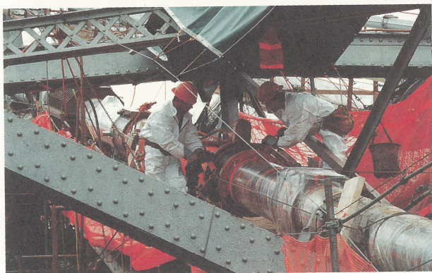
写真-5 ケーブルラッピング ペーストは鉛丹 ワイヤーは 素線と同じメッキなし。 Photo.5 Cable wrappin-Paste consists of red lead; wires are no galvanized.
