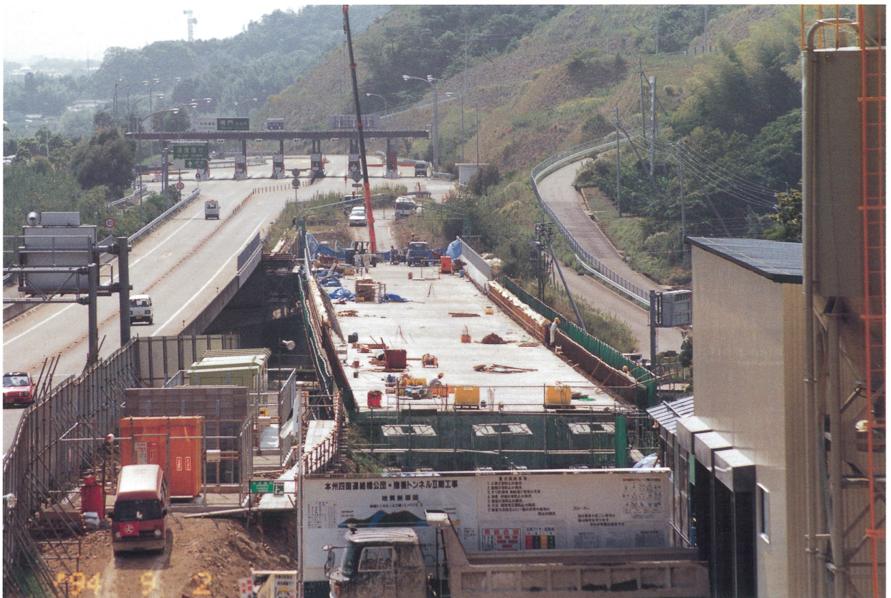
木津高架橋工事 Work of Kitsu Viaduct
