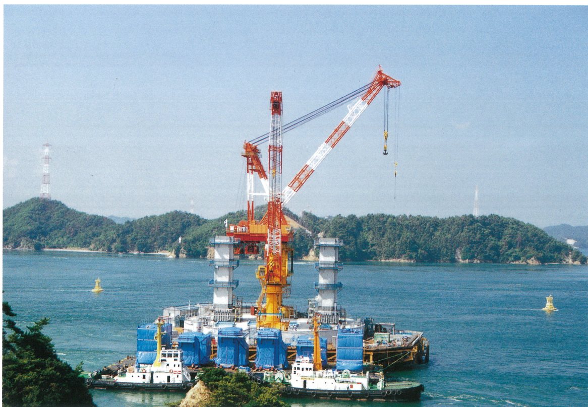
来島大橋主搭工事 (5P)
