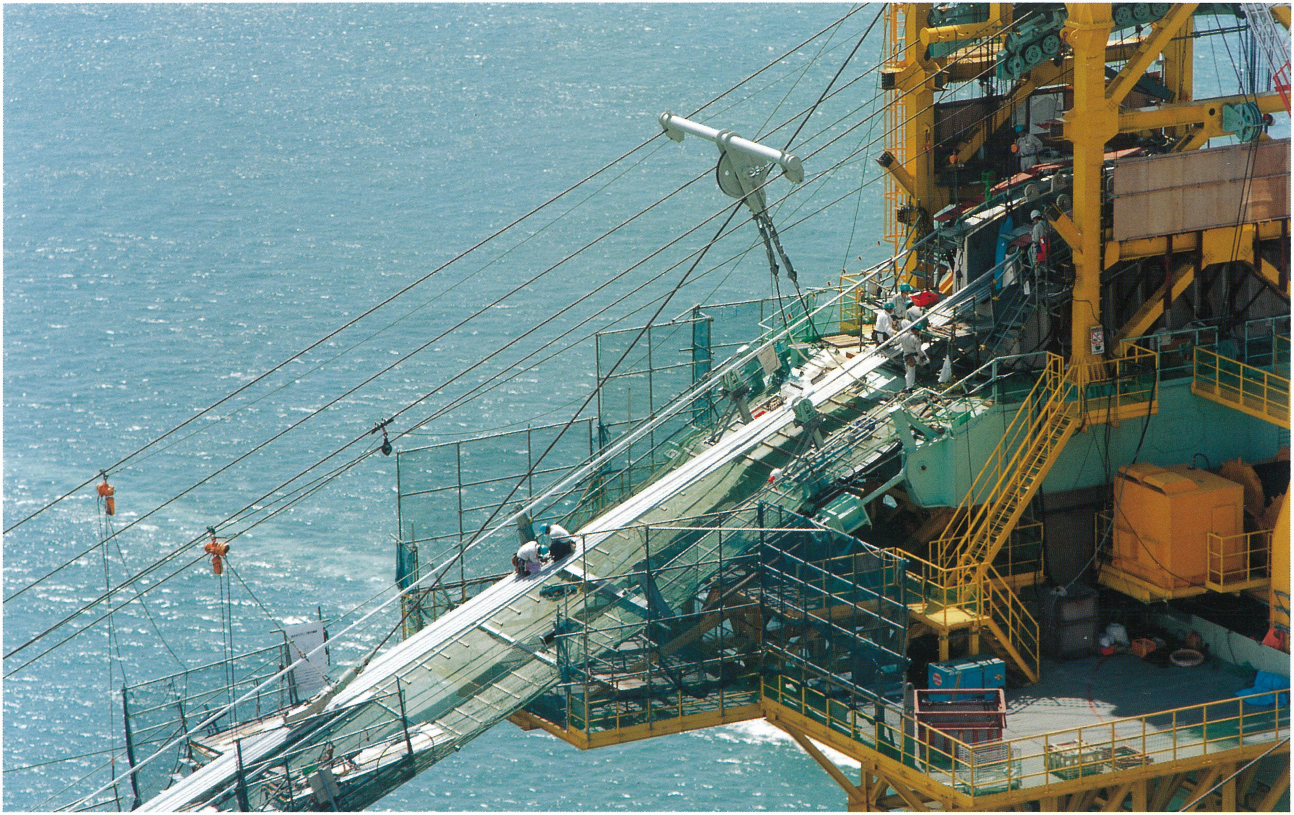
明石海峡大橋ケーブル工事 Cable Work of Akashi Kaikyo Bridge
