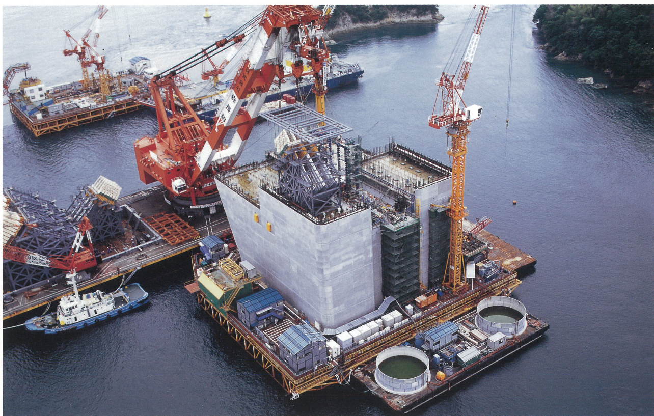
来島大橋 4A ケーブルアンカーフレーム架設 Erection of Kurushima Bridge 4A Cable Anchor Frame
