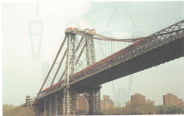
写真-1 ウィリアムズバーグ橋 補修状況 Photo.1 Repairs on Williamsburg Bridge
