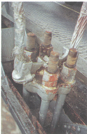
写真-7 旧ハンガー定着部 (鞍掛け定着)
