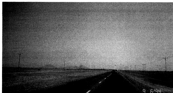
写真-5 土漠地帯の地方道路
