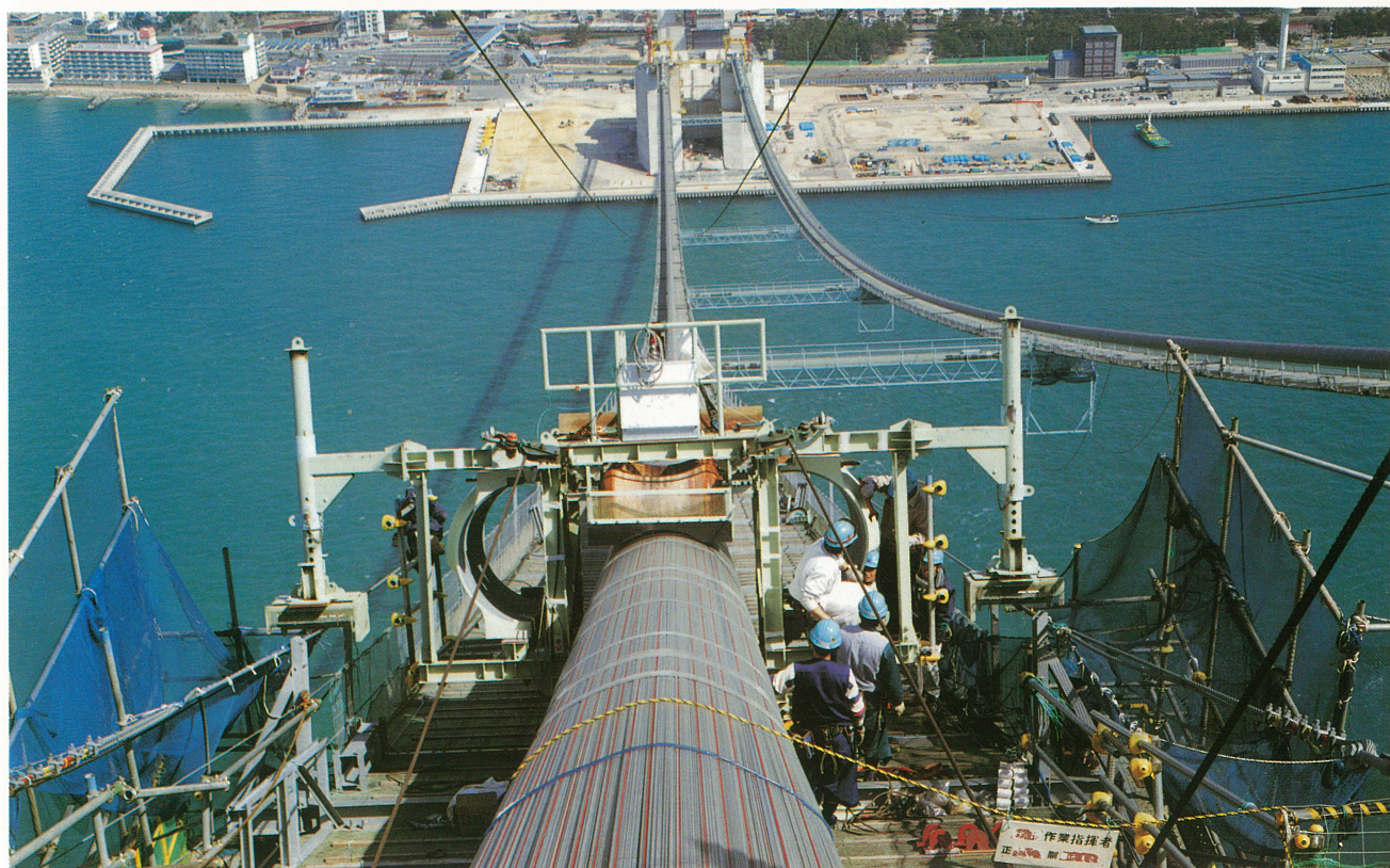
明石海峡大橋ケーブル工事(ケーブルバンド架設作業) Akashi Kaikyo Bridge Cable Work (Cable band installation)
