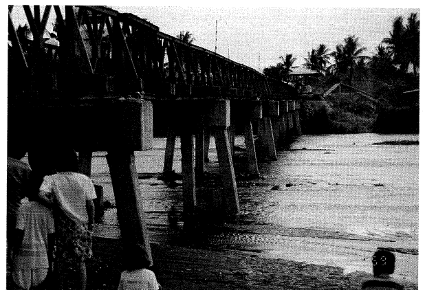
写真-1 ローワー・シルウェイ橋 Photo.1 Lower Silway Bridge
