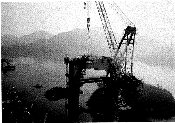
5P 最終ブロック架設
