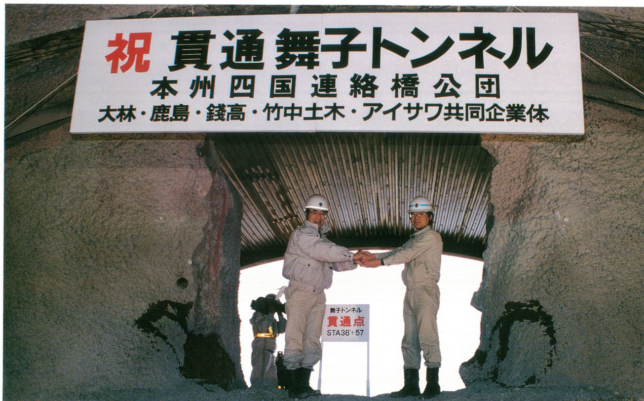
舞子トンネル南工事(上り線貫通)
