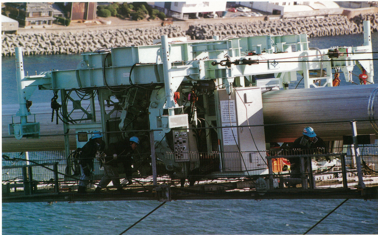
明石海峡大橋ケーブル工事(ケーブルスクイズング作業) Akashi Kaikyo Bridge Cable Work (Cable Squeezing)
