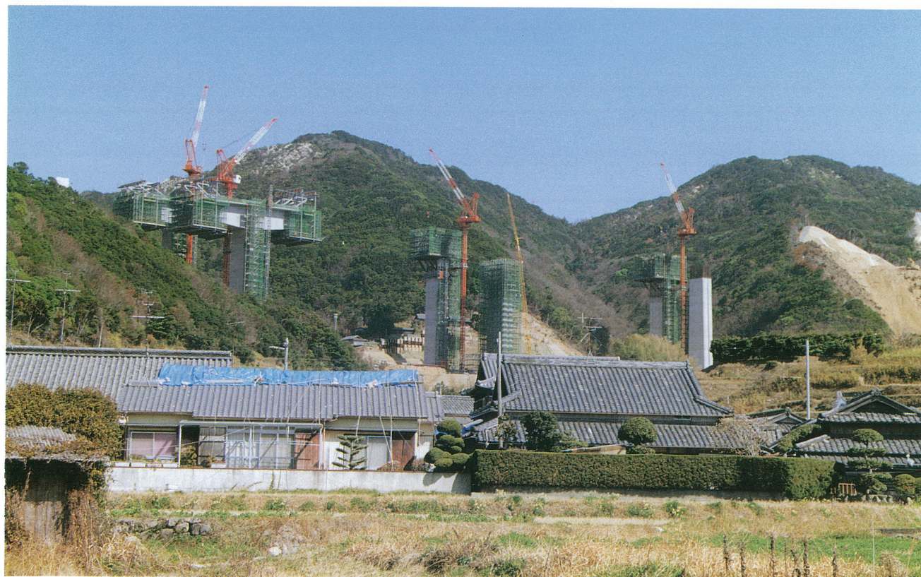
楠本川橋工事(PC 4 径間連続ラーメン箱桁)
