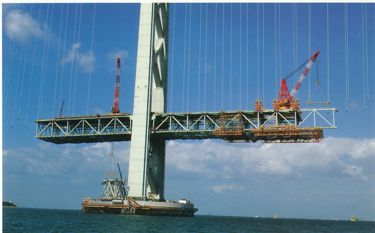
明石海峡大橋補剛桁工事・3P中央径間側面材架設
