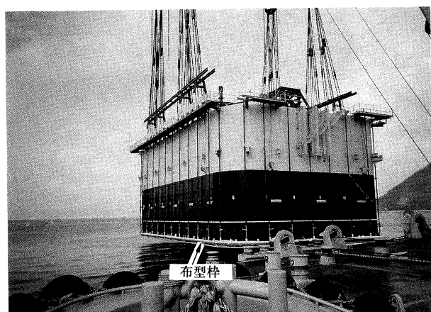
写真-5 3Pケーソン全景 Photo.5 3P caisson
