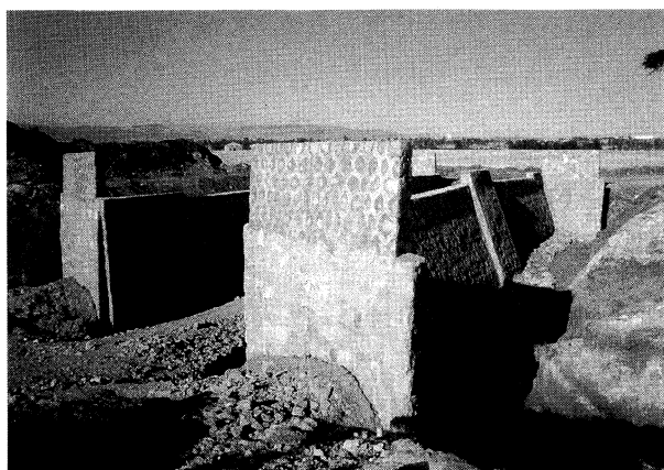
写真-3 完成した下部工 Photo.3 Completed substructure
