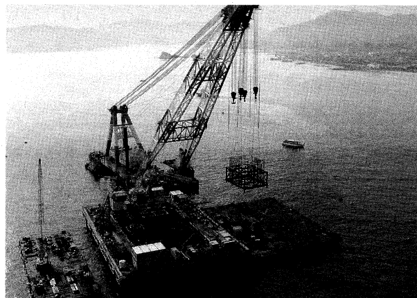
写真-10 塔アンカフレームの設置
