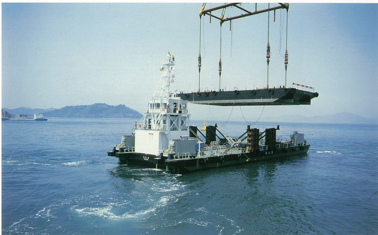
自航台船「うましま」による来島海峡における補剛桁直下吊り架設の模擬施工試験 Site experiment for deck erection by self-propelling bort "Umashima"
