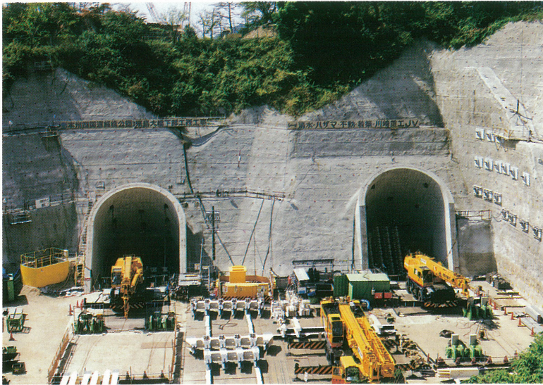
来島大橋(10 A トンネルアンカー) (7 年 9 月末) Kurushima Bridge (10A tunnel anchorage) September 30, 1995
