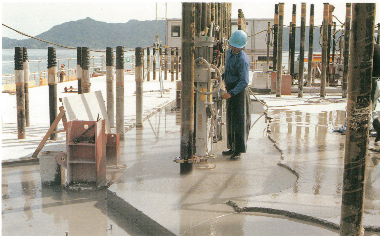
多々羅大橋(主塔基礎コンクリート研磨作業) Tatara Bridge (facing work on tower foundation)
