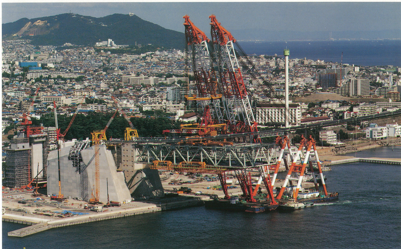
明石海峡大橋補剛桁工事・第6回大ブロック架設(1A橋台8パネル)
