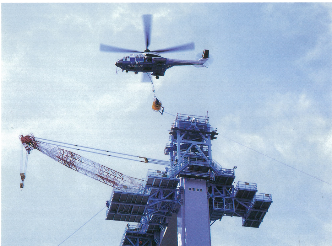
来島第一大橋、中央径間パイロットロープ渡海 Pilot rope crossing for 1st Kurushima Bridge center span
