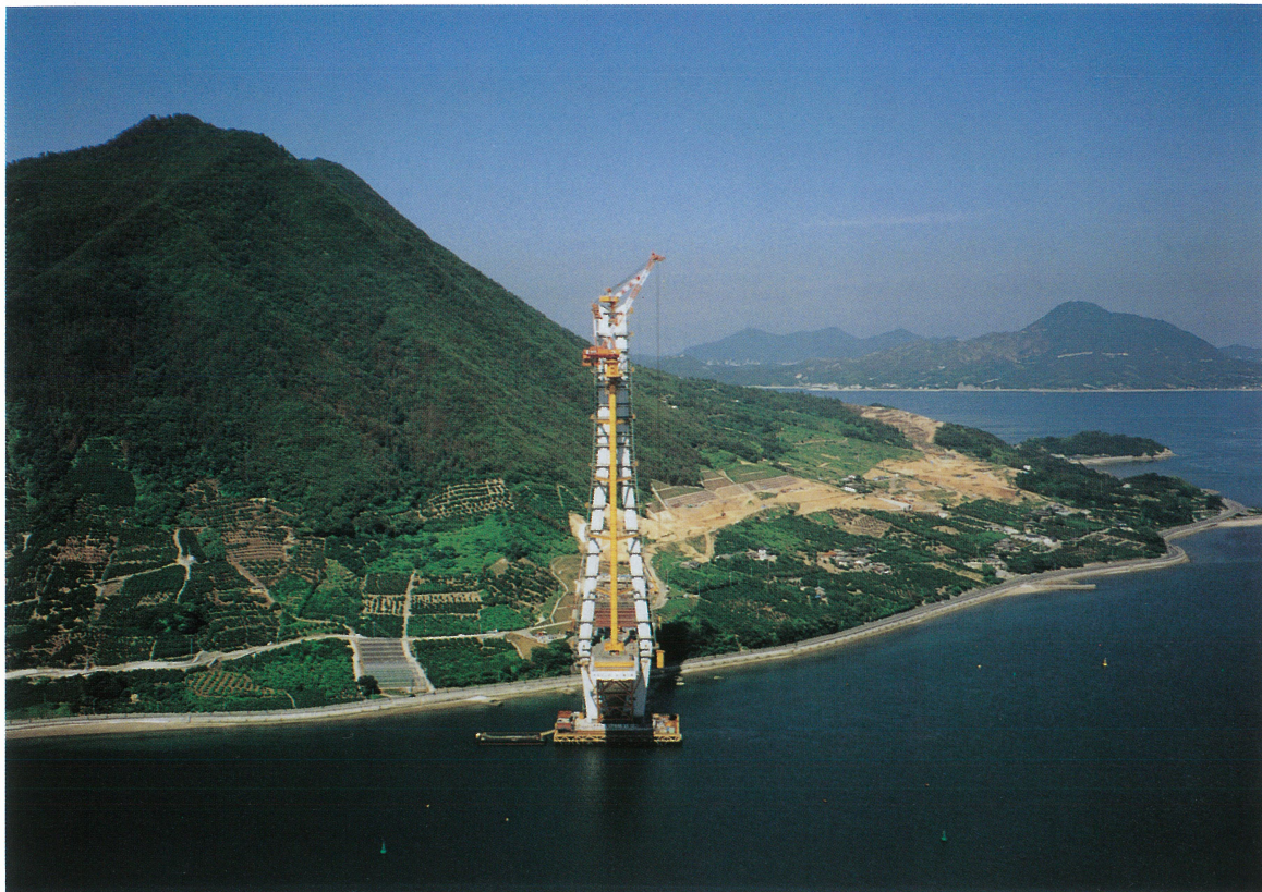
多々羅大橋 2P 主塔の完成、3P 塔頂より生口島側を望む Completion of Tatara Bridge 2P, viewed from 3P pylon to Ikuchijima side
