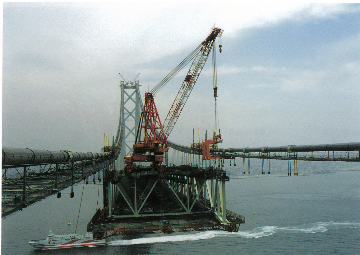
明石海峡大橋補剛桁架設工事（コの字天秤を用いた中央径間短ハンガー部の架設） Akashi Kaikyo Bridge Stiffening Girder Work (Erection of short suspender ropes of center span using angular U-shaped balance)
