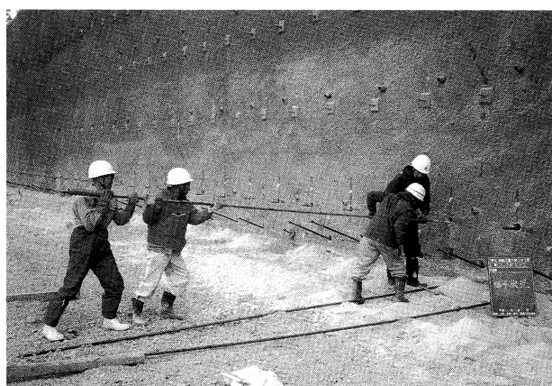
写真-3 ロックボルト挿入状況 Photo.3 Lock bolt setting
