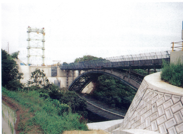
路谷池橋鋼上部工工事 (8年6月29日) (上路ローゼ桁) [淡路島側陸上部] Michitaniike Bridge Steel Superstructure (June 29, 1996) Work on Awajishima side (top-deck rose bridge)
