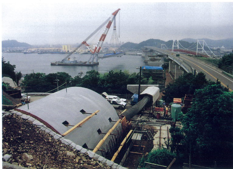
手前から第2鳴門トンネル南坑 (8年6月24日) 口、撫養橋北高架橋下部工、撫 養橋大ブロック一括架設状況 [鳴門側陸上部] From front to back; 2nd Naruto Tunnel (June 24, 1996) South Portal, Muya-Kita Viaduct Substruc- ture, Muya Bridge Large Block Erection on Naruto side
