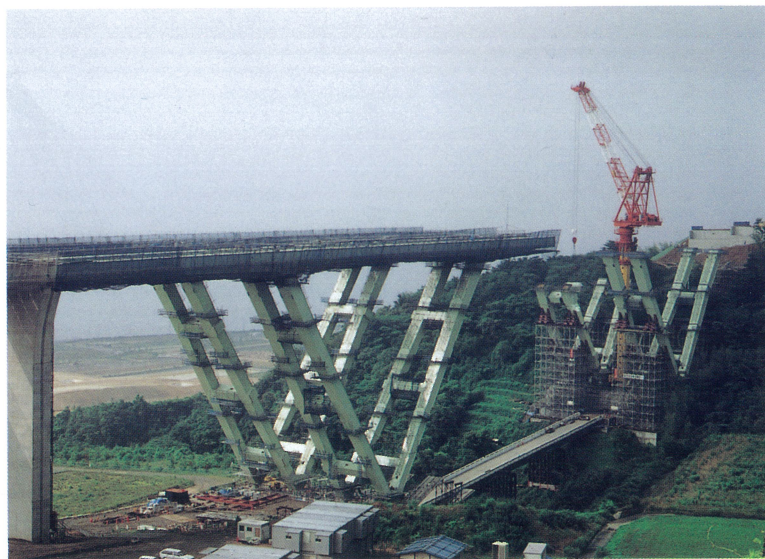
灘川橋鋼上部工工事 (8年6月29日) (V脚ラーメン橋) [淡路島側陸上部] Nadagawa Bridge Superstructure Work (June 11, 1996) on Awajishima side (V-shaped rigid frame bridge)
