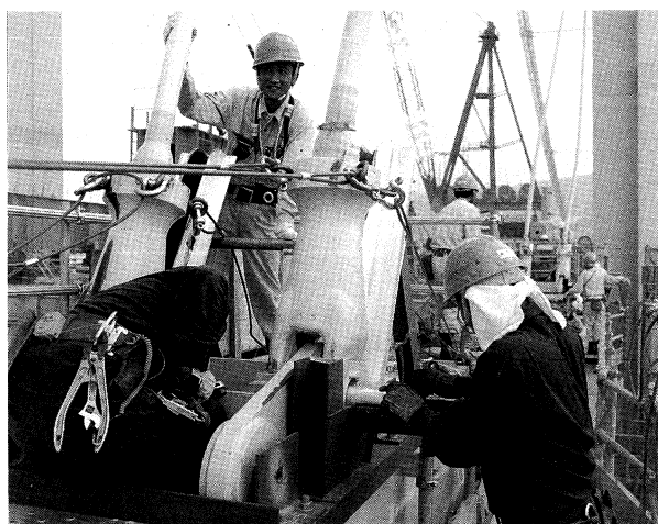
写真-4 塔付部大ブロックハンガー定着作業状況
