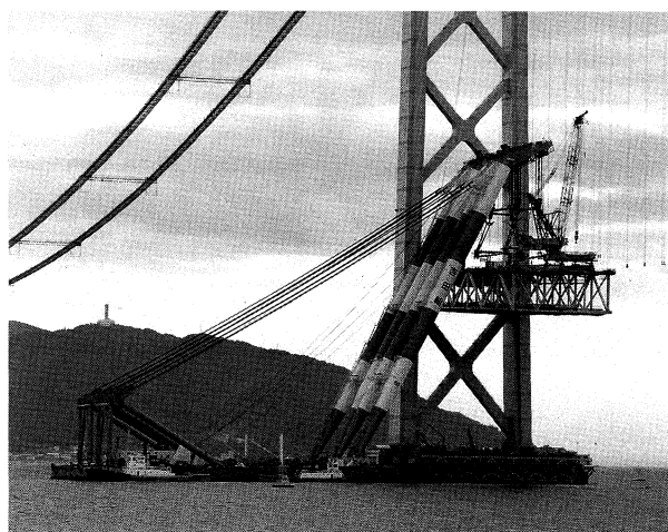
写真一3 塔付部側径間大ブロック架設状況 Photo.3 Large block erection for tower portion of side span
