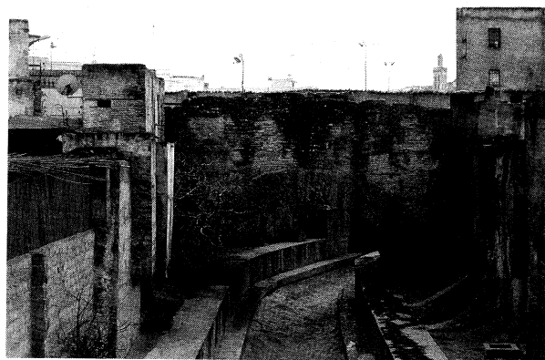
写真-11 フェズ・メディナの橋 Photo.11 A bridge at Medina in Fes
