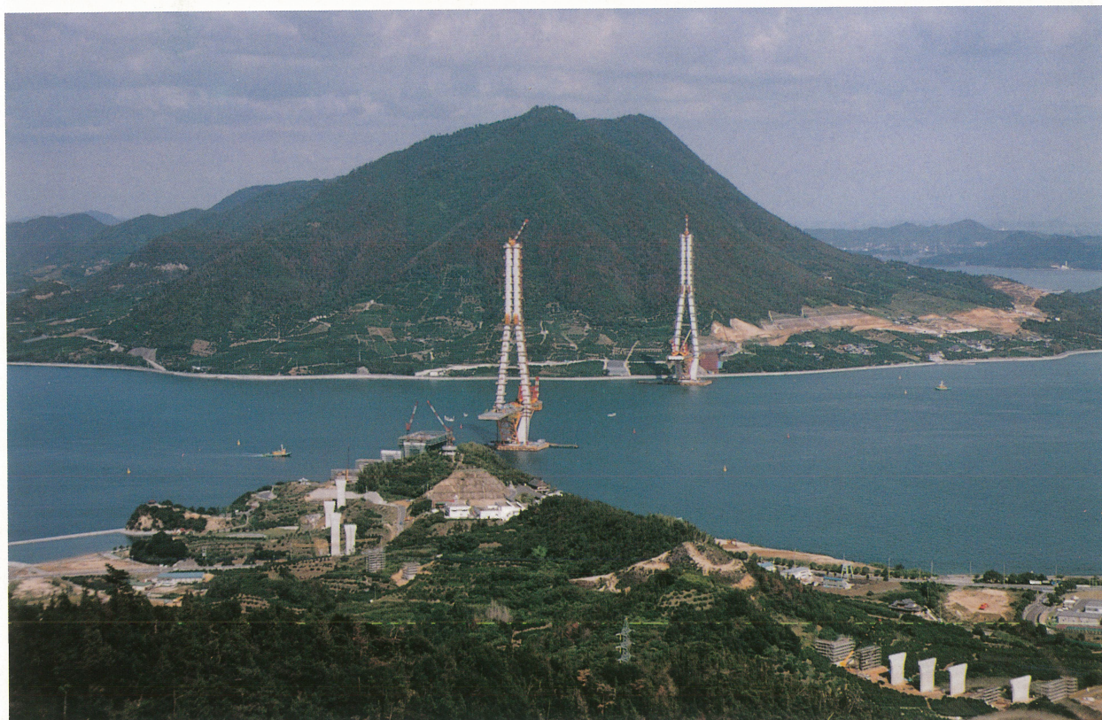
多々羅大橋および同関連区間 [PC 桁コンクリート打設、側径間大ブロック架設準備工実施中] Tatara Bridge and approach highway--Concrete Casting on PC girder and preparatory work for side span large block erection
