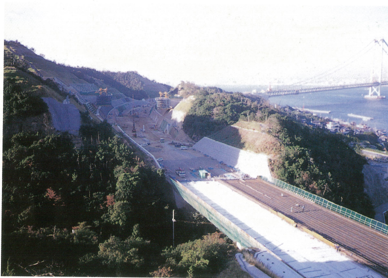
岩屋西工事 [淡路島側陸上部] (平成 8 年 10 月 25 日) Iwaya West Work--Awaji side (October 25, 1996)
