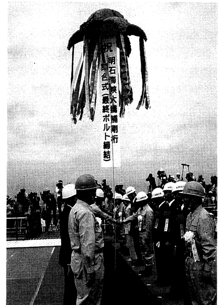
写真 補剛桁閉合式（最終ボルト締結）の状況
