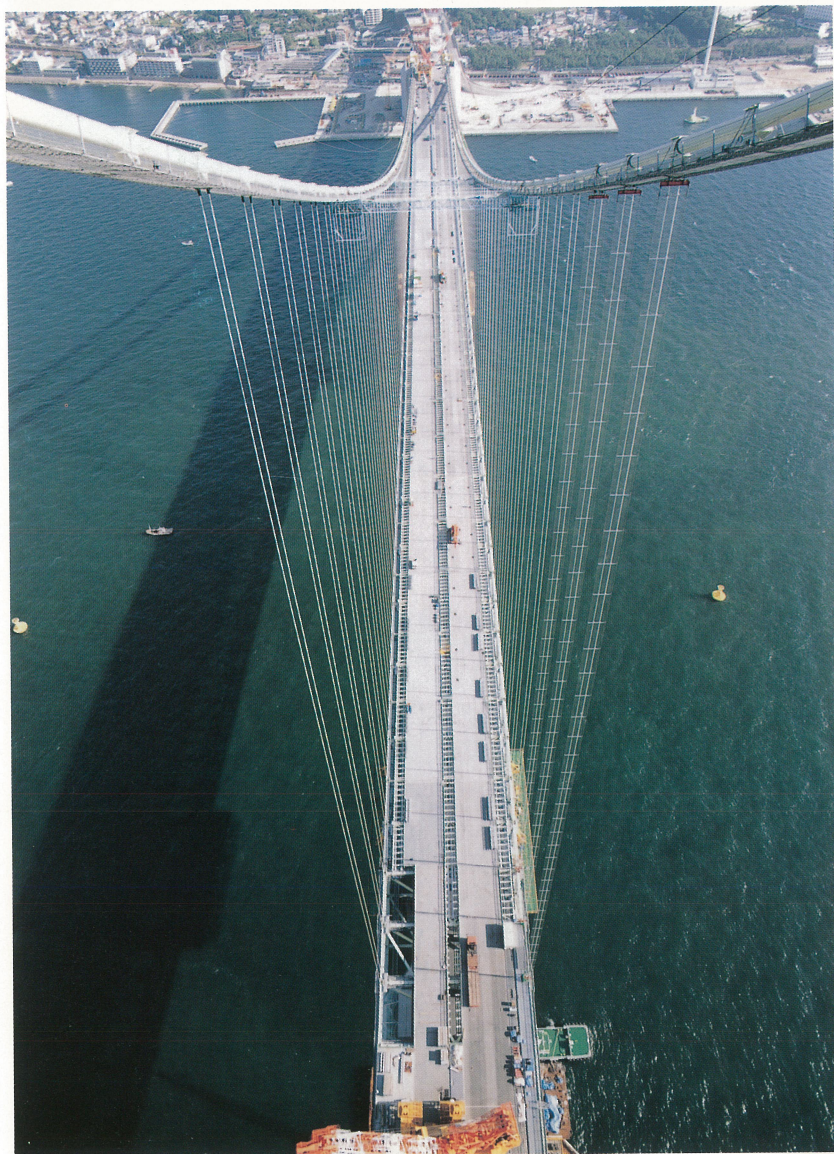
明石海峡大橋・神戸側側径間 Kobe side span of Akashi Kaikyo Bridge (平成 8 年 10 月 24 日) (October 24, 1996)
