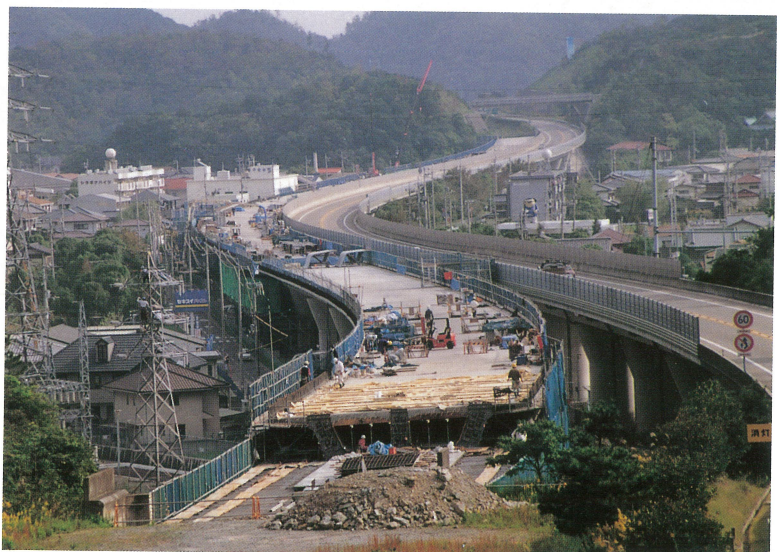
撫養高架橋 PC 上部工工事 [鳴門側四車線化区間] (平成 8 年 10 月 25 日) Muya Viaduct PC superstructure work-- for 4 lane widening part in Naruto side (October 25, 1996)
