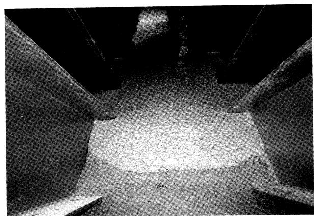
写真-2 打込み地点での流動状況 Photo.2 Flow at casting front
