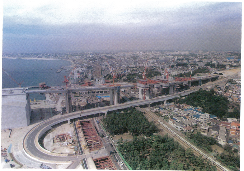
舞子高架橋上部工工事 (PC) [神戸側陸上部] (平成 8 年 10 月 25 日) Maiko Viaduct superstructure work (PC)-- for on land part of Kobe side (October 25, 1996)
