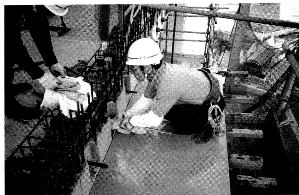
写真-4 樹脂の除去作業
