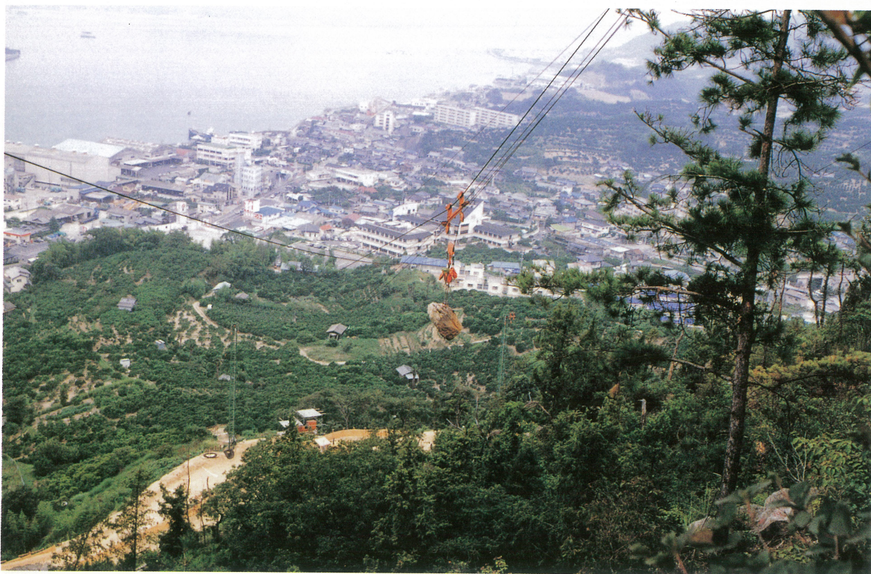
因島田熊地区 [転石除去工]
