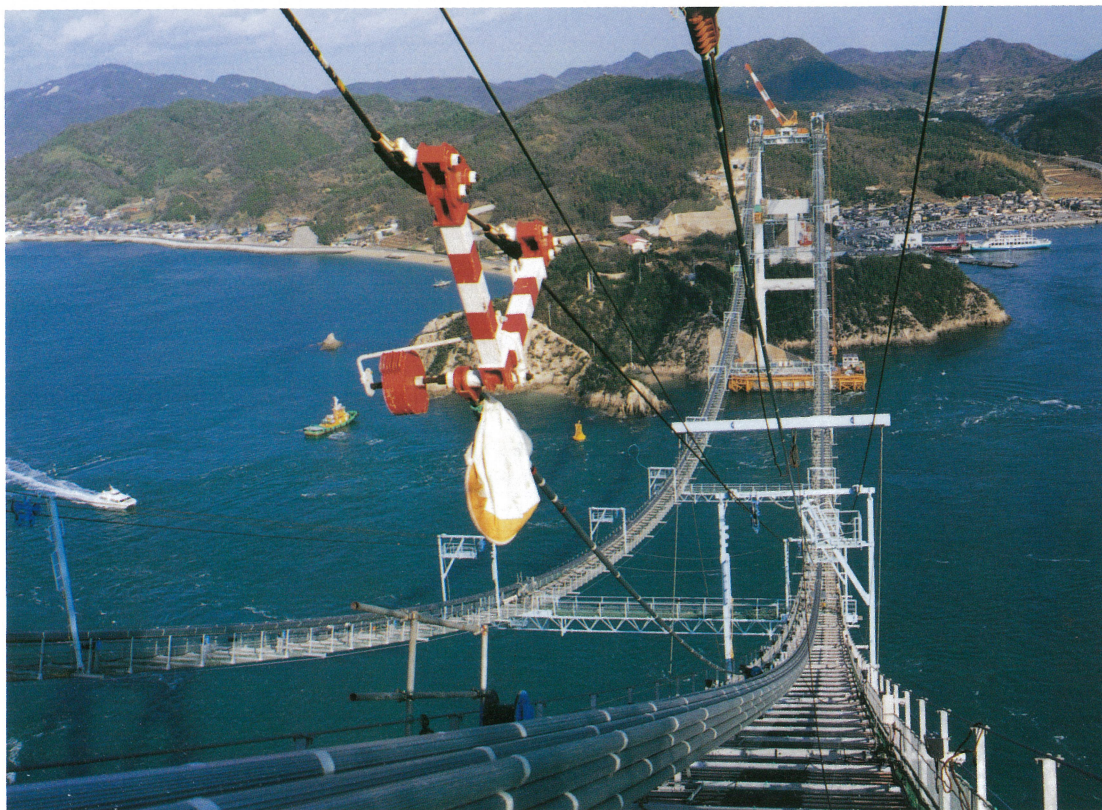
来島第一大橋 [ケーブルストランド架設] First Kurushima Bridge—erection of cable strand
