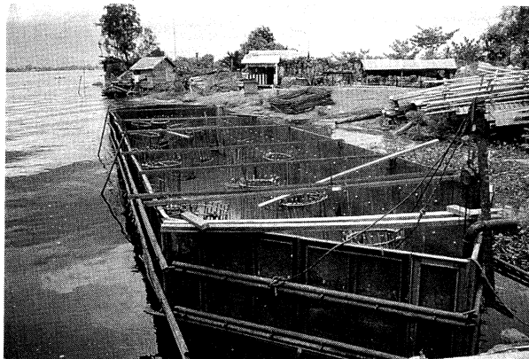
写真-4 バンジャールマシン側の吊橋の橋脚
