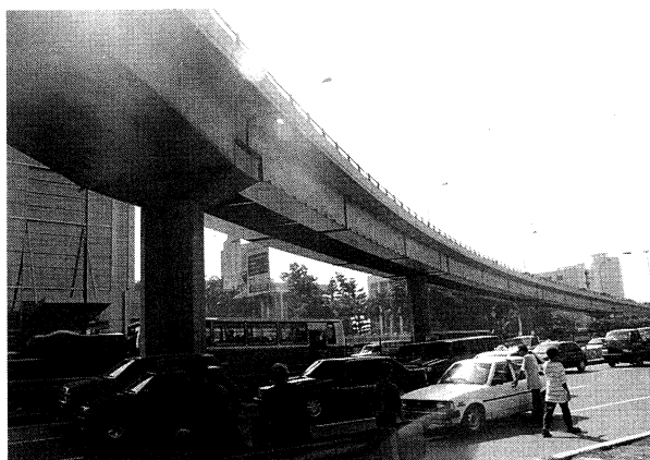
写真-4 MAMPANG 高架橋 Photo.4 Mampang Flyover
