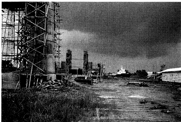
写真-1 バリトー橋の建設現場
