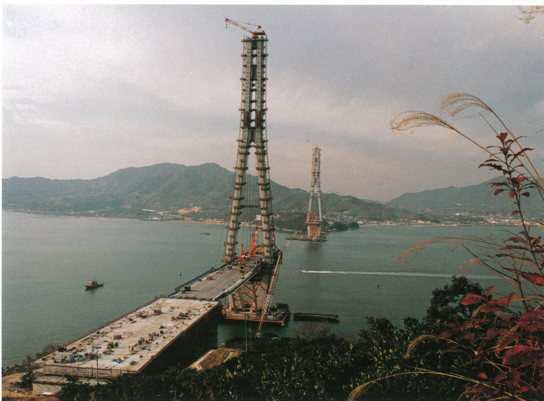
多々羅大橋 [全景] Tatara Bridge—Overview
