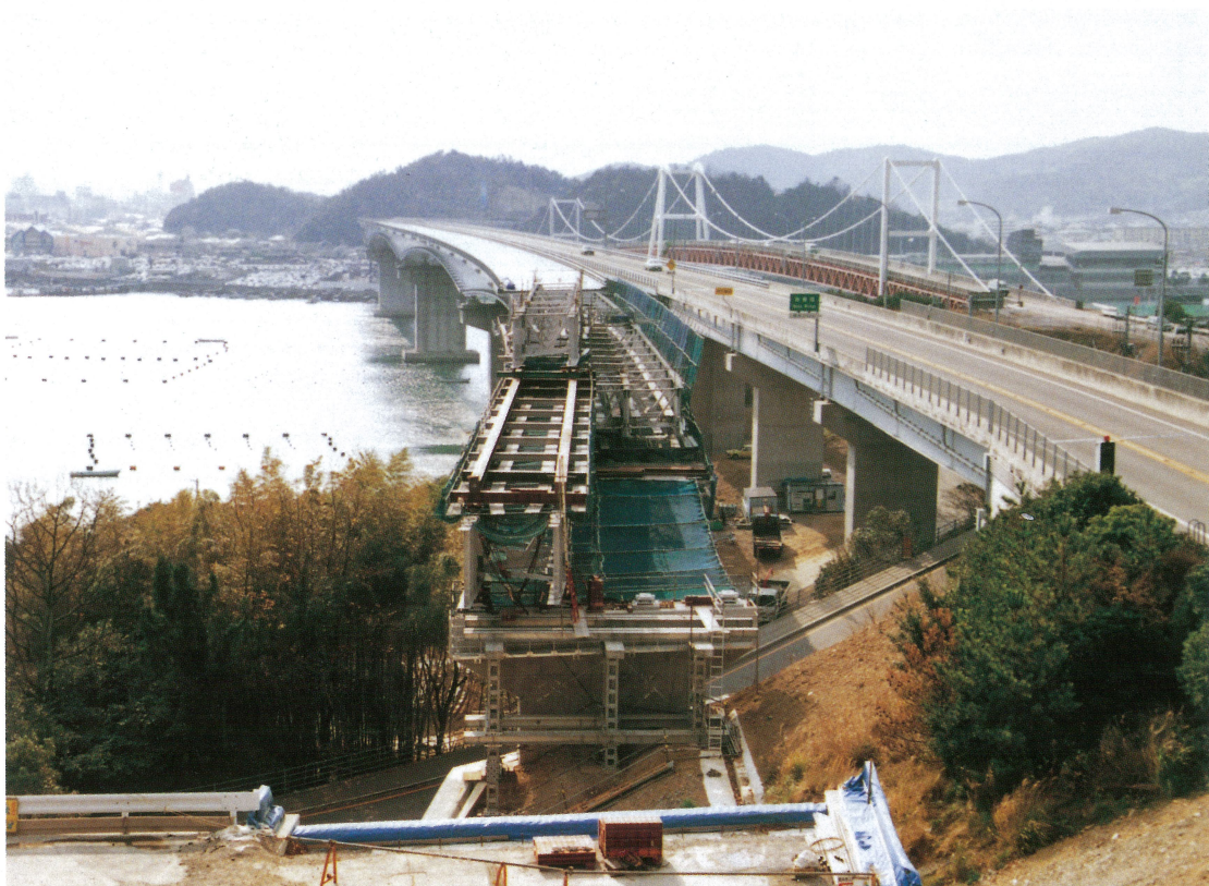
手前から撫養北高架橋、撫養橋 From front to back; Muya-Kita Viaduct, Muya Bridge
