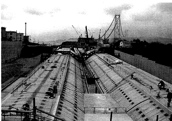
写真-4 ボルトボックス部防水工 Photo.4 Waterproofing for bolt box
