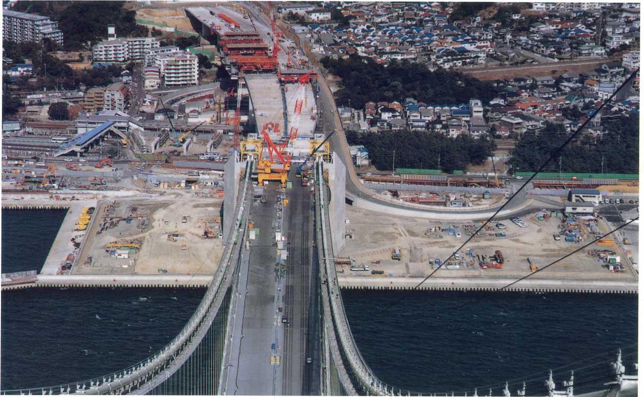
神戸側陸上部 [舞子高架橋] Kobe side - Maiko Viaduct
