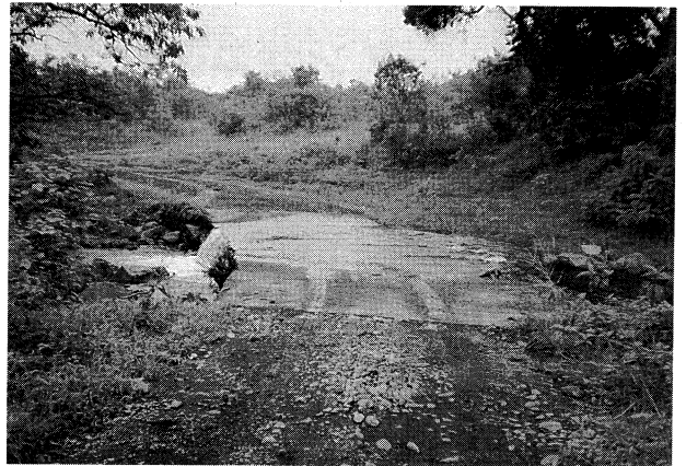
写真-4 川底にコンクリートを打設した箇所 Photo.4 Riverbed covered with concrete
