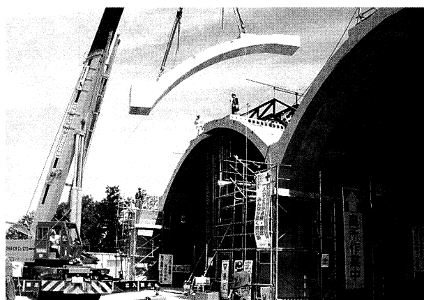
写真-3 アーチ部材架設状況 Photo.3 Installation of arch segment
