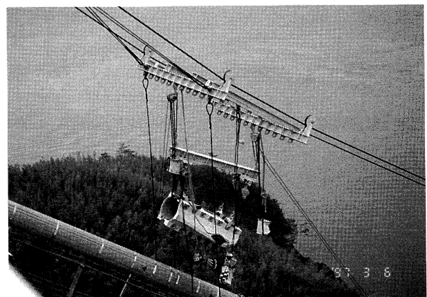
ケーブルバンド施工状況
