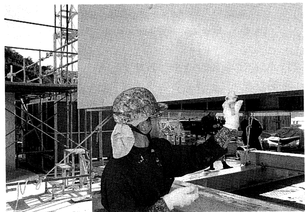
写真-2 端面の塗込み状況 Photo.2 Coating of flange
