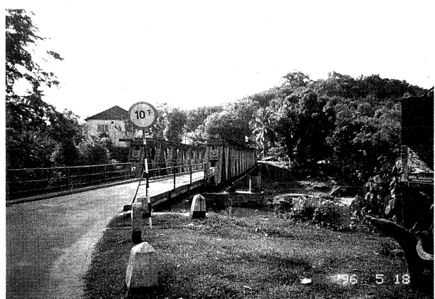
写真-4 トラス橋(荷重制限されている)
