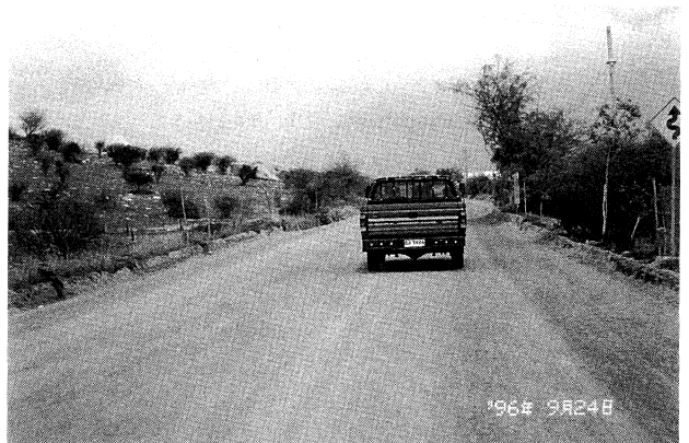
写真-5 地方の砂利道路 Photo.5 Rural gravel road
