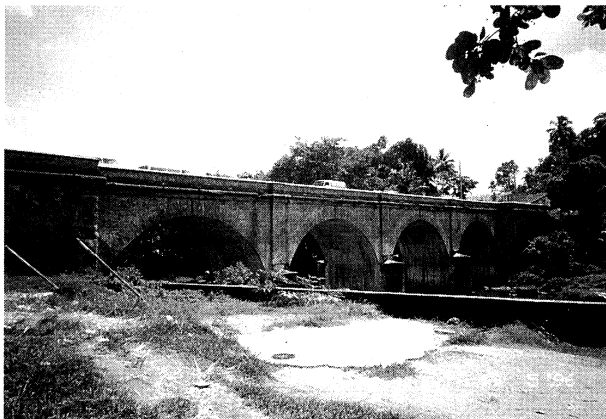
写真-1 石積みアーチ橋(道路橋)
