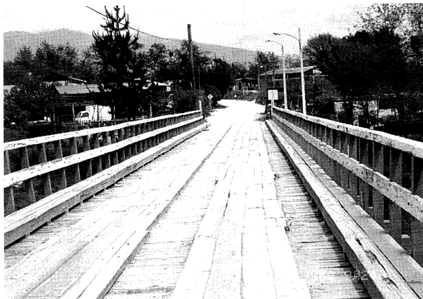
写真-7 地方の橋
