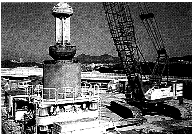
写真-3 全旋回オールケーシング工法 Photo.3 Full-turning casing
