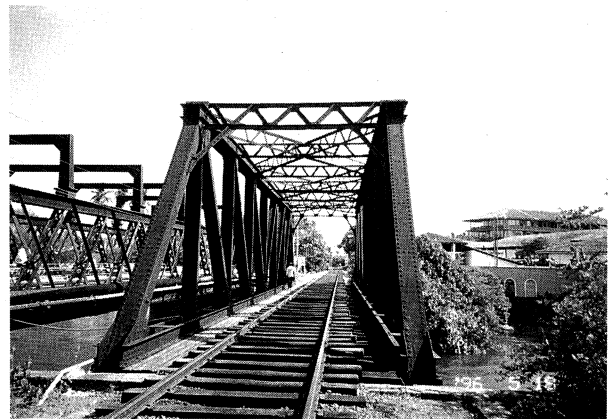
写真-2 スリランカの鉄道橋(トラス橋)
