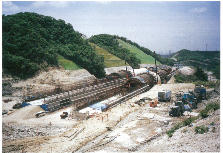
布施畑開削トンネル [西神地区] (平成9年5月28日) Fusehata open-cut tunnel on Seishin section (May 28, 1997)
