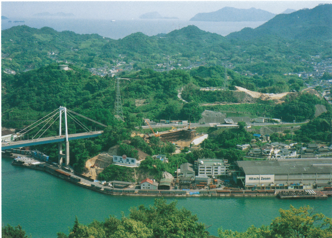
新尾道大橋 向島側下部工の工事現況 Shin Onomichi Bridge—Substructure work on Mukaishima side
