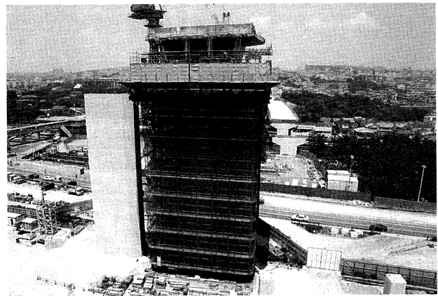
写真-2 柱頭部支保工施工状況(P7)
