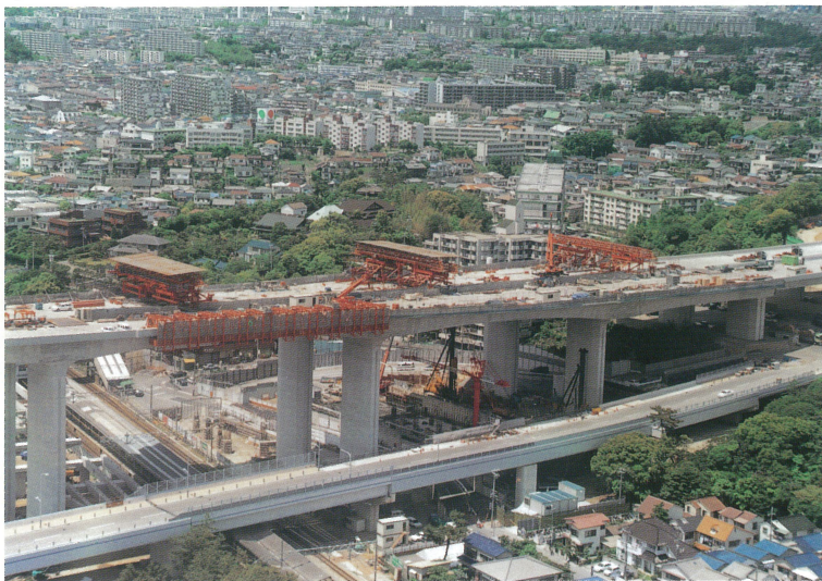
舞子高架橋上部工工事 [神戸側陸上部] (平成9年5月27日) Maiko Viaduct superstructure work on Kobe side (May 27, 1997)
