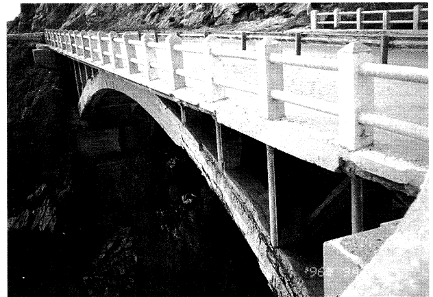
写真-9 老朽化したコンクリートアーチ橋
