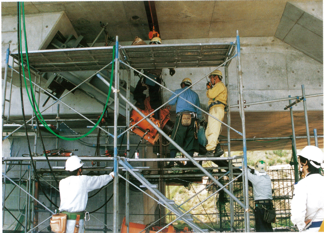
多々羅大橋 PC 桁側ケーブル定着状況 Tatara Bridge - cable erection on PC girder
