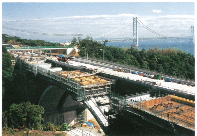
茶間川橋上部工工事 [淡路島側陸上部] (平成9年5月26日) Chamagawa Bridge superstructure work in Awaji Island side (May 26, 1997)
