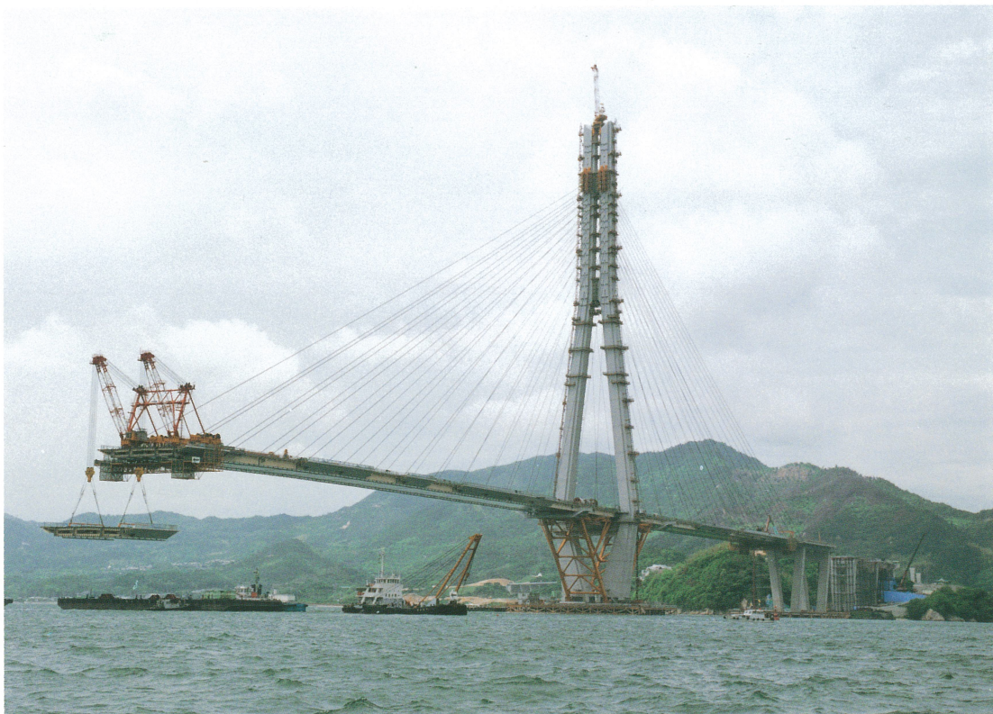
多々羅大橋 大三島側の工事現況 Tatara Bridge—works on Ohmishima side
