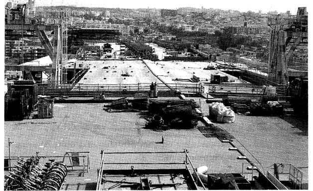
1A側アンカレイジ鋼道路桁（吊橋側から舞子高架橋方向を望む）
