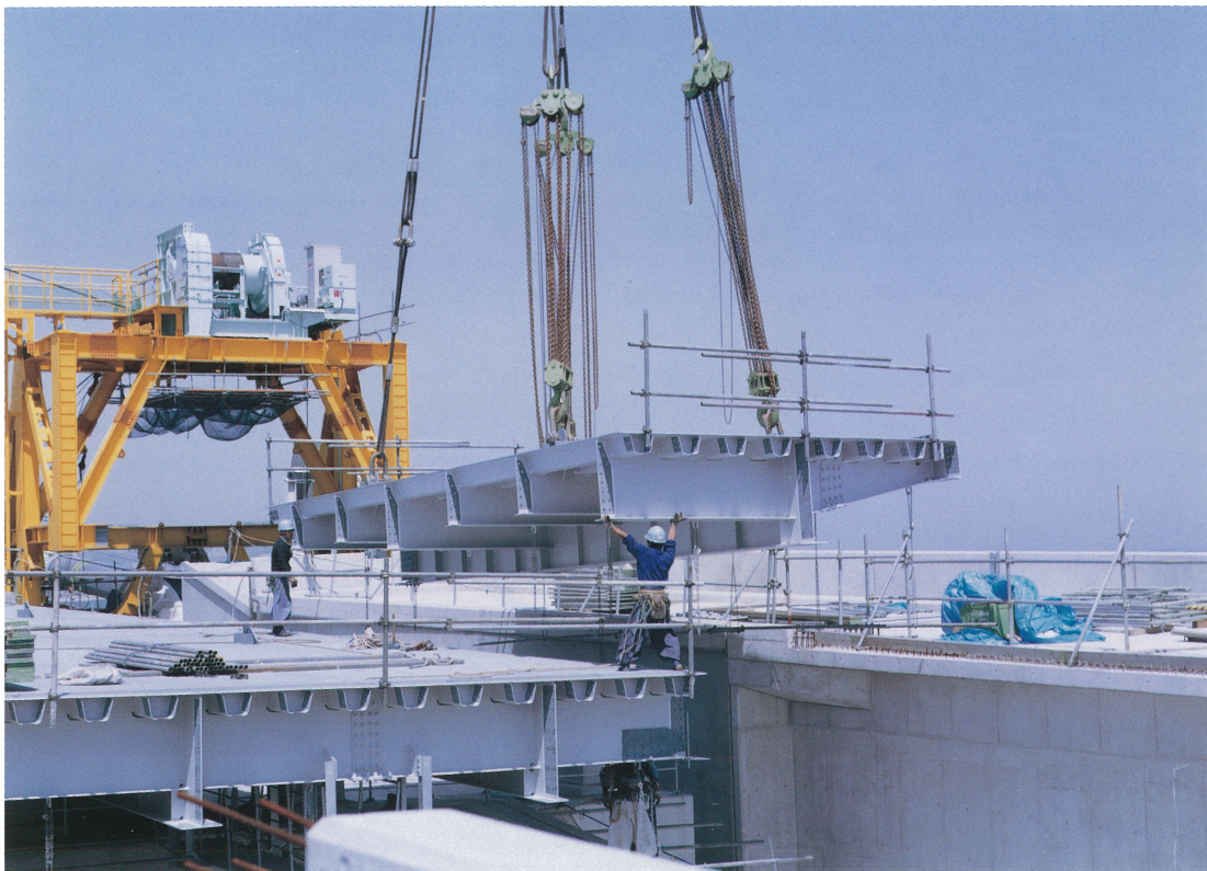
4A アンカレイジ鋼道路桁架設状況 Steel deck erection on Anchorage 4A
