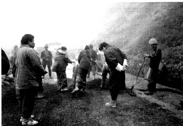
写真-5 人力による舗装のオーバーレイ Photo.5 Pavement overlay by manpower
