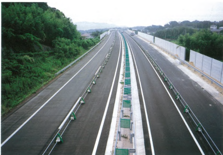
津名・洲本地区舗装(その2)工事 [淡路島側陸上部] (平成9年8月30日) Second pavement work in Tsuna-Sumoto section in Awaji Island side (August 30, 1997)
