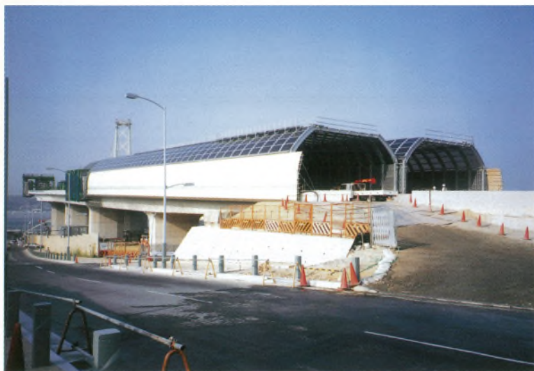
舞子地区遮光施設等工事 [神戸側陸上部] (平成9年8月27日) Shelter work in Maiko section on Kobe side (August 27, 1997)
