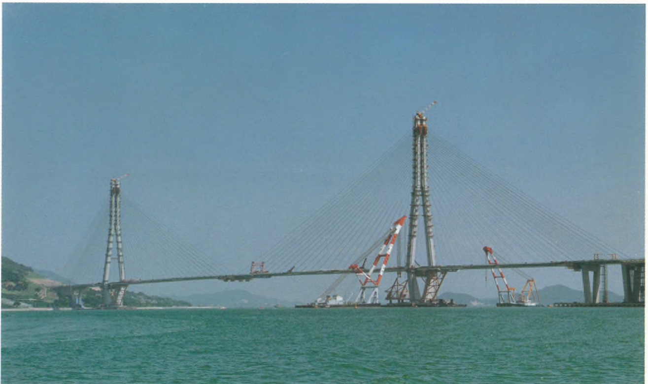
多々羅大橋 斜ベントの撤去 Tatara Bridge—removal of inclined bent
