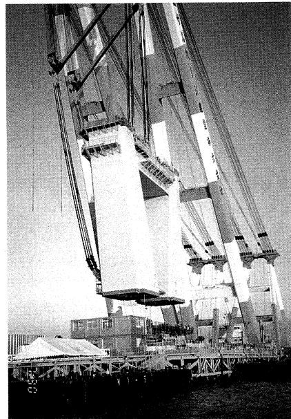
写真-2 塔下部大ブロックの架設
