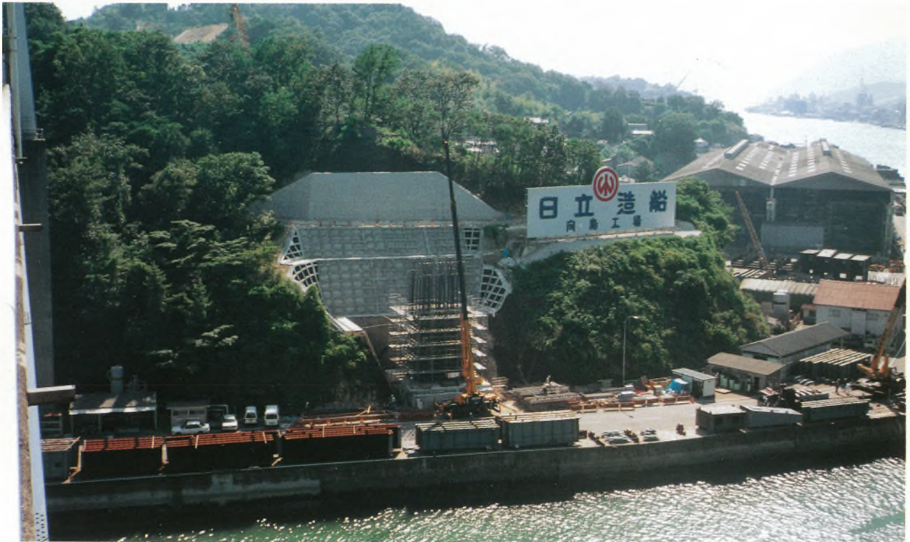
新尾道大橋 3P の工事現況 Shin Onomichi Bridge—works on 3P
