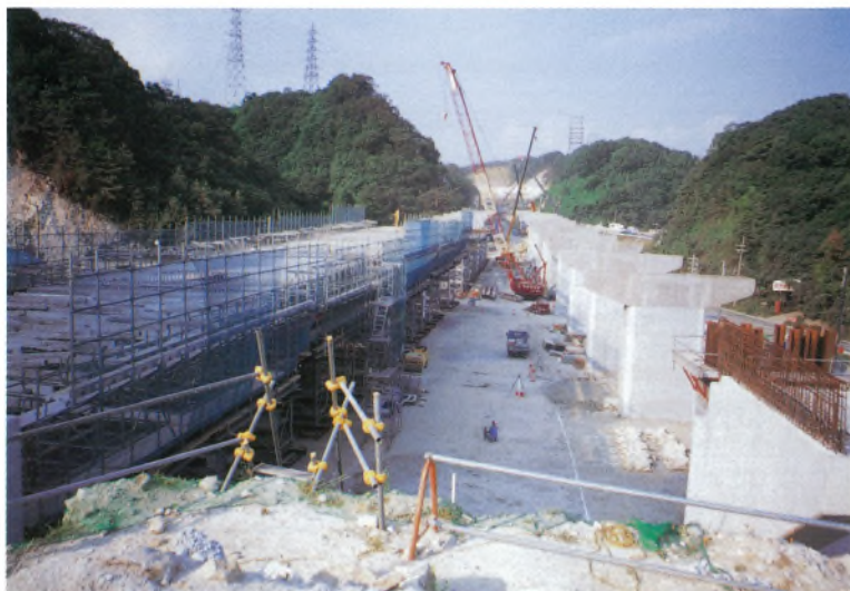
柏木谷高架橋工事 [西神地区] (平成9年8月27日) Kashiwagidani Viaduct work in Seishin section (August 27, 1997)
