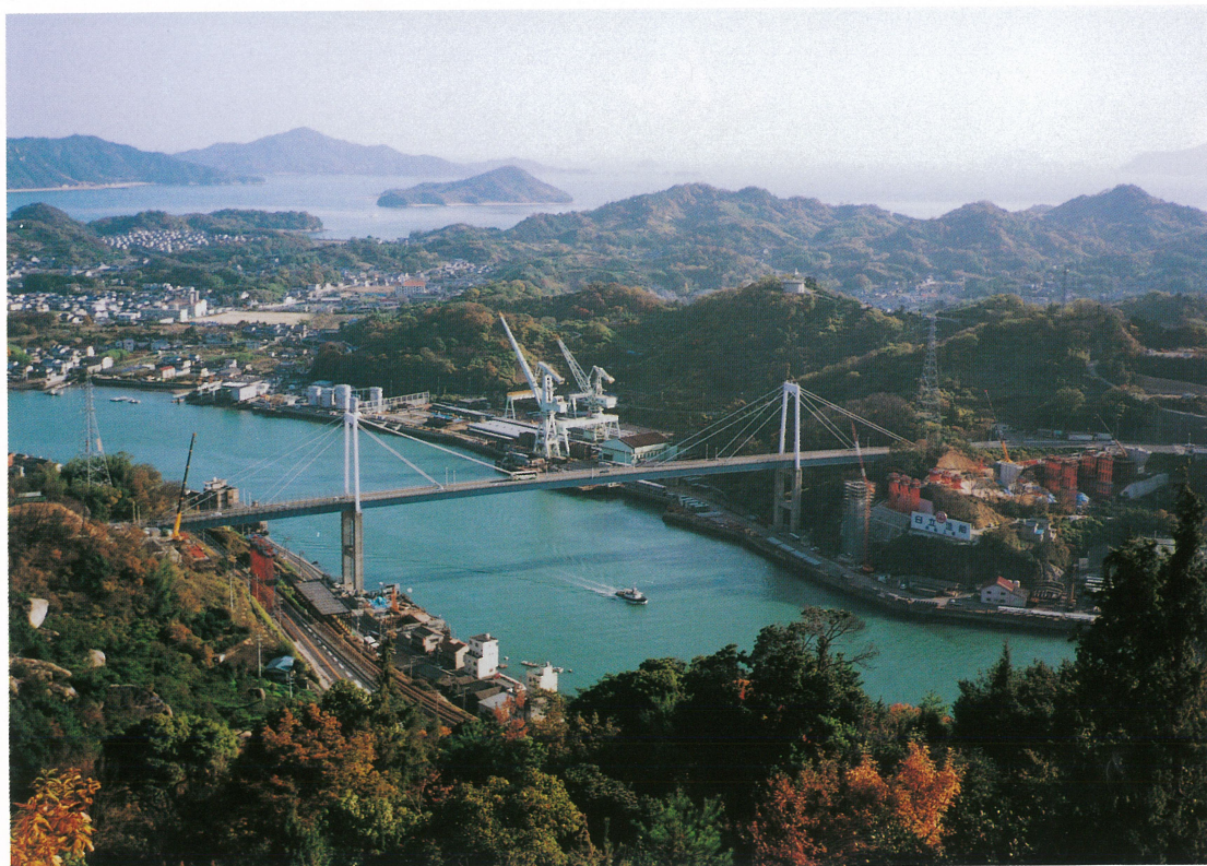
新尾道大橋 上・下部工施工状況 Shin Onomichi Bridge-Superstructure and substructure work
