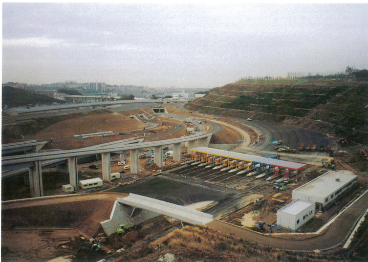
垂水JCT・IC工事現況 (J・Hランプ料金所付近) (平成9年11月28日) Current condition of Tarumi JCT·IC construction works (November 28, 1997)
