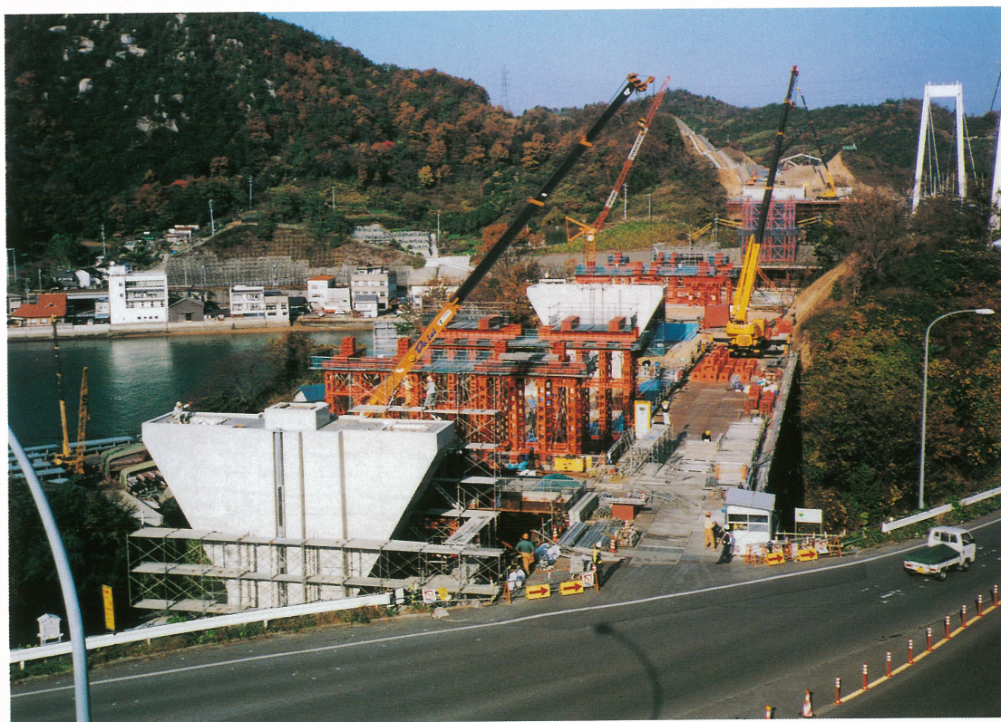
新尾道大橋 向島側施工状況 Shin Onomichi Bridge-Construction work on Mukaijima side
