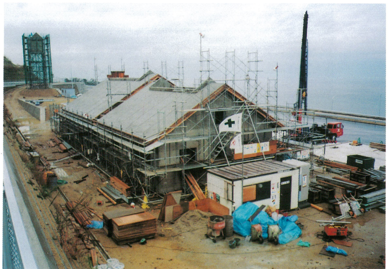
室津PA休憩施設新築工事現況 (下り線側) (平成9年11月30日) Current condition of rest house construction works in Murotsu PA (November 30, 1997)
