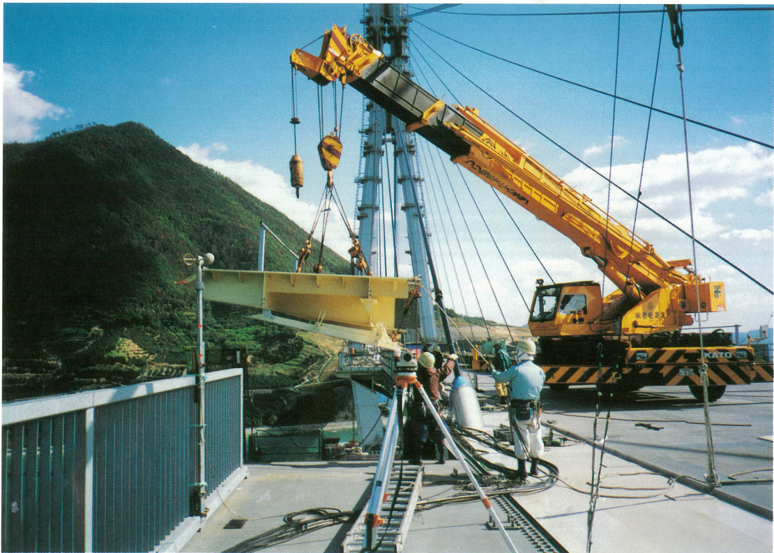
多々羅大橋 施工状況 Tatara Bridge-Construction work
