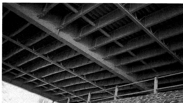
写真-15 Rhine橋の桁（新旧で横リブのスティフナーに違いが見られる）
