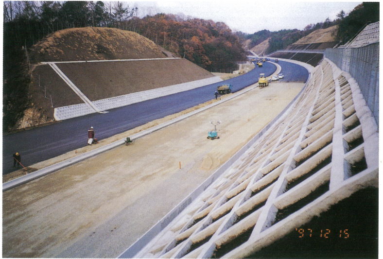
西神地区工事現況 (木見地区、STA+68付近) (平成9年12月15日) Current condition of Komi Road construction works in Seishin section (nearby STA+68) (December 25, 1997)
