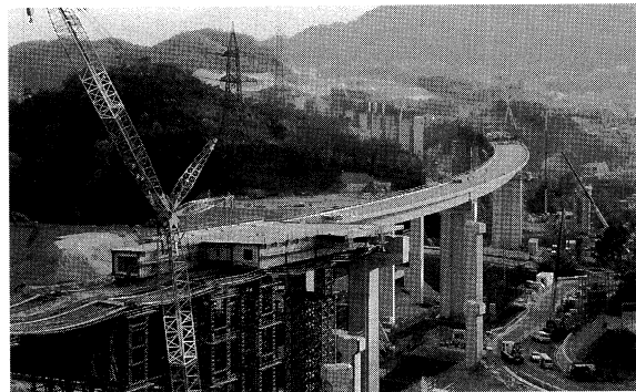
来島大橋関連区間 小浦高架橋
