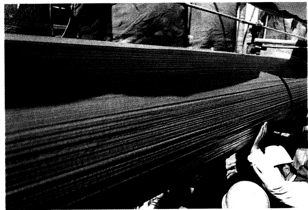
写真-6 ケーブル素線が現れたウレタン表面
