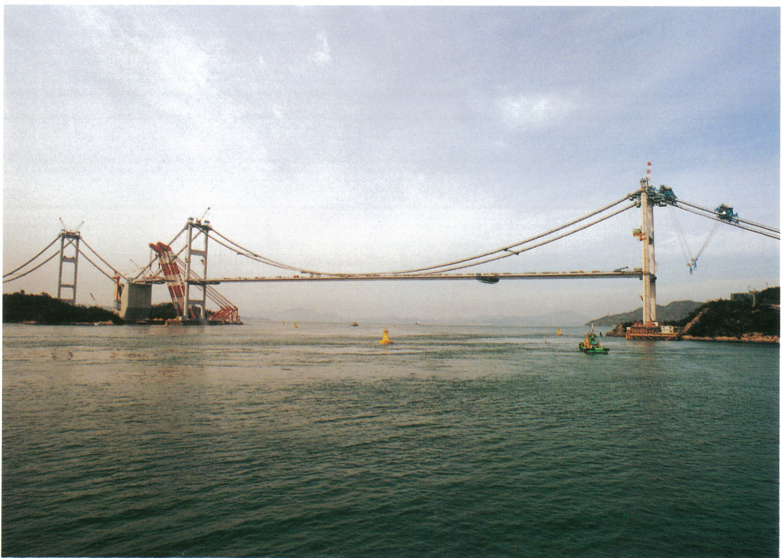
来島第一大橋 補剛桁大ブロック架設状況 First Kurushima Bridge-Erection work of large block on stiffening deck
