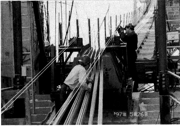
写真-7 スプレーサドル部での死活ワイヤーの仕分け作業 Photo.7 Wiring work on live and dead wires at spray saddle
