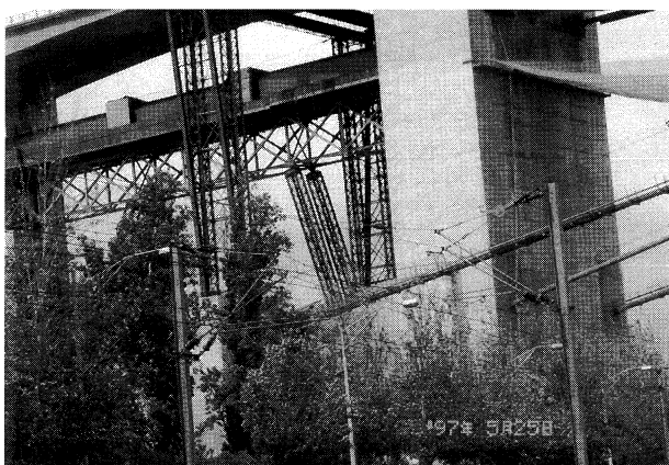
写真-3 第二ケーブル用のアンカレイジ Photo.3 Anchorage for second cable
