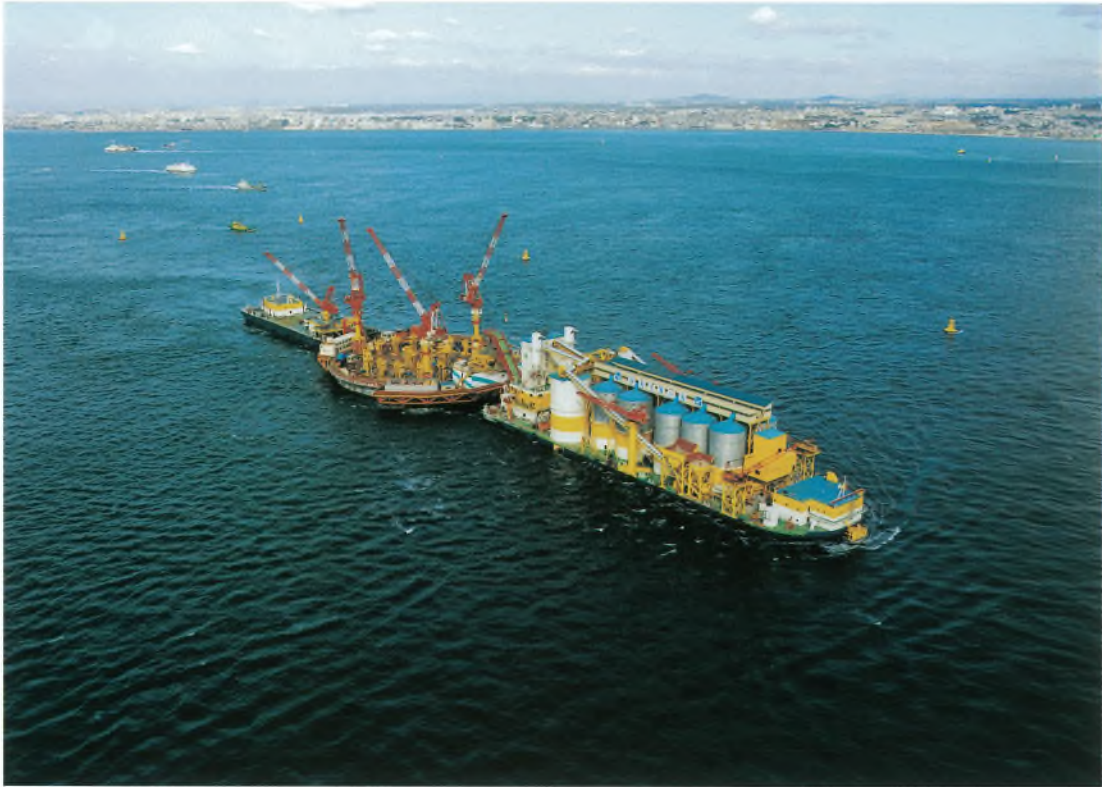
主塔ケーソン水中コンクリート打設 Casting underwater concrete for caisson of main tower
