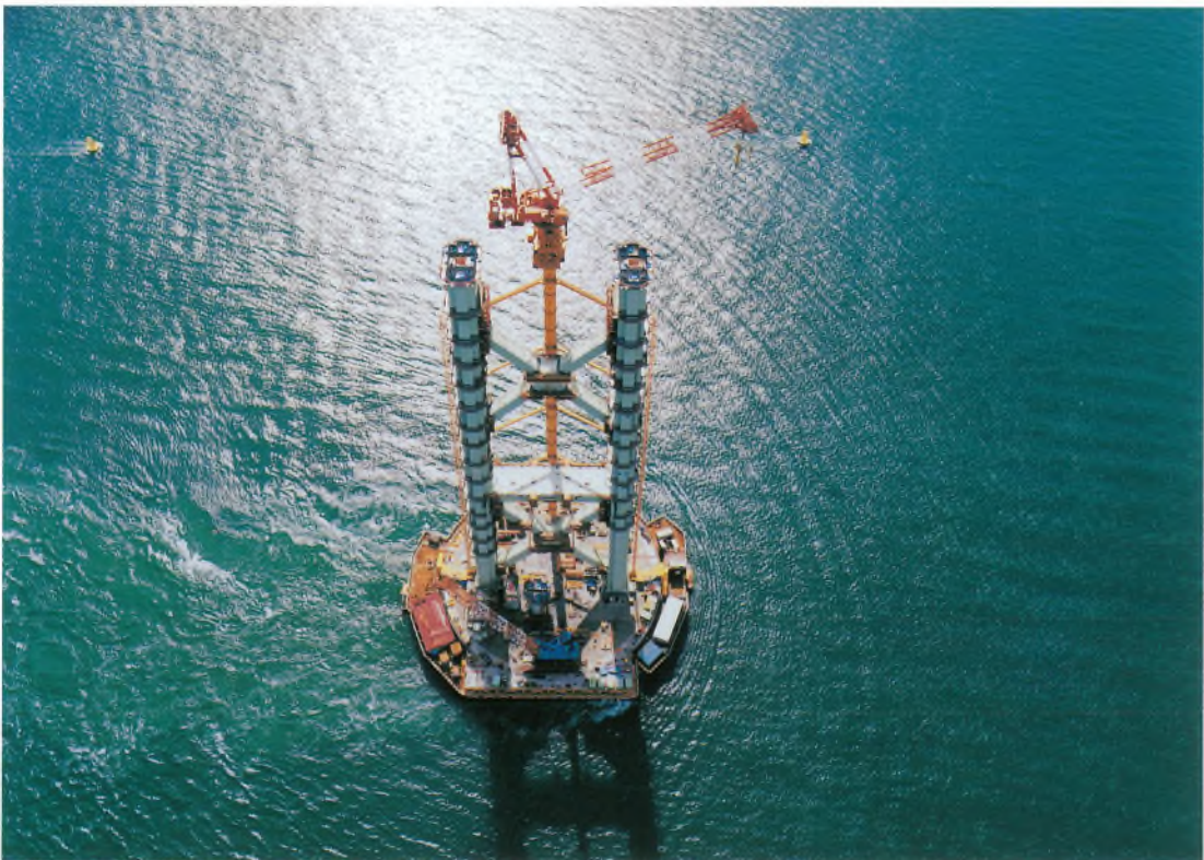
主塔架設 Erection of main tower
