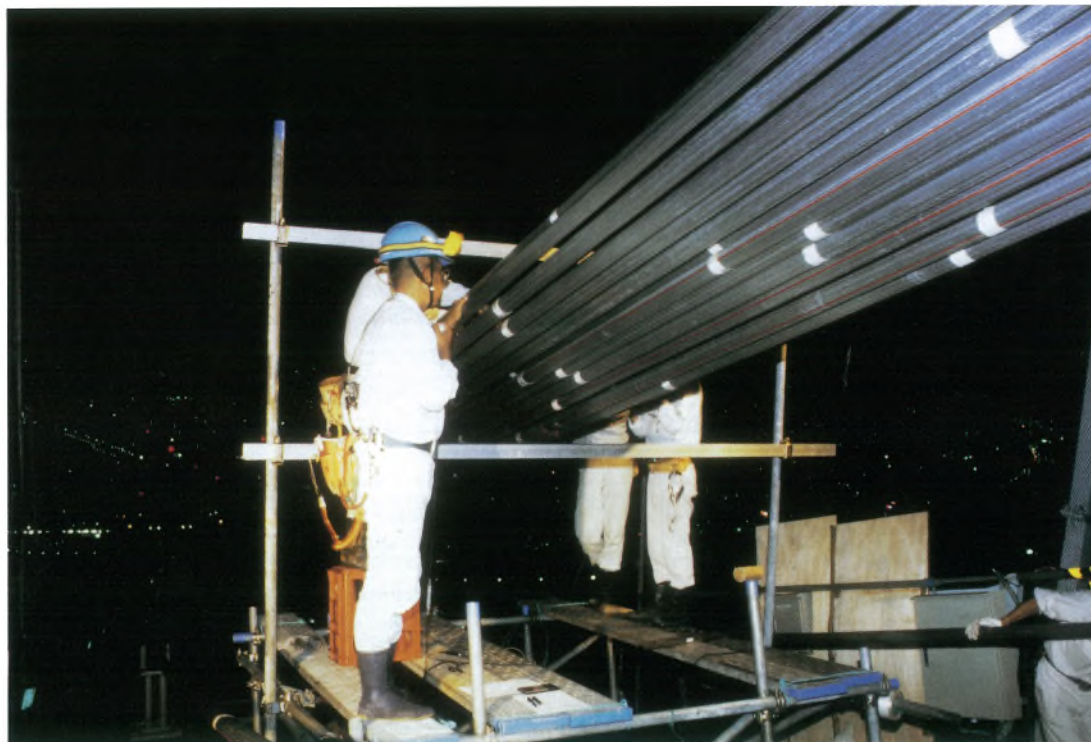
ケーブルサグ調整 Arrangement of cable sag
