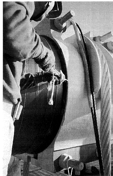
写真-3 コーキング作業中（ブチルゴム）
