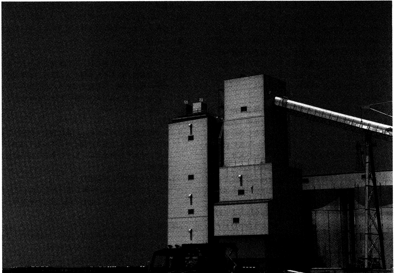
写真-2 大型色見本の現地視察（地上35mのコンクリートプラント屋上）
