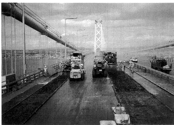
写真-1 5レーン分割2レーン同時施工
