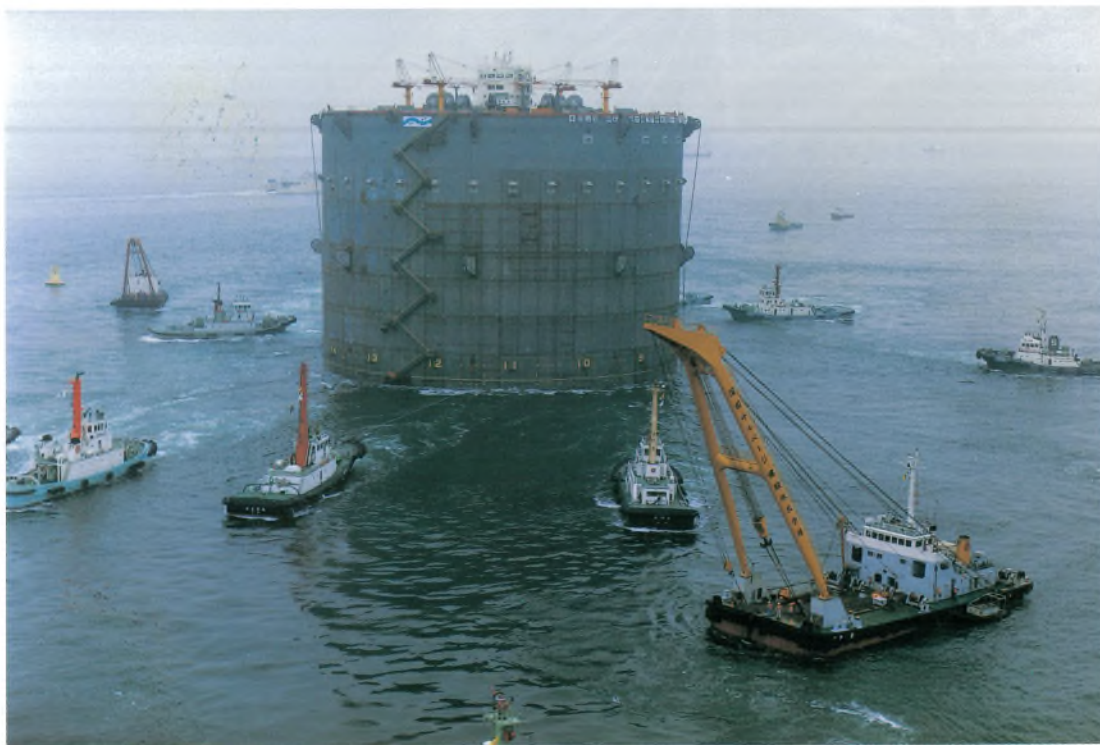
ケーソン曳航 Towing a caisson
