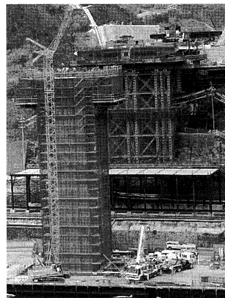
尾道側施工状況
