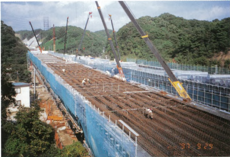
柏木谷高架橋 Kashiwagidani Viaduct
