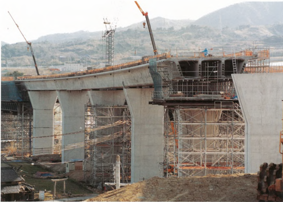
室津高架橋 Murotsu Viaduct
