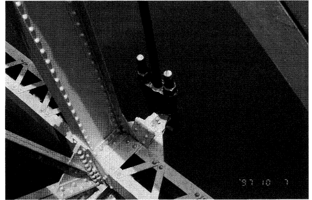
写真-7 U型ボルトを用いた桁とハンガーの定着。 Photo.7 Installation of hanger to the deck with U-shaped bolt.
