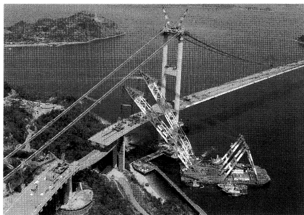
大ブロック架設状況（小浦高架橋）
