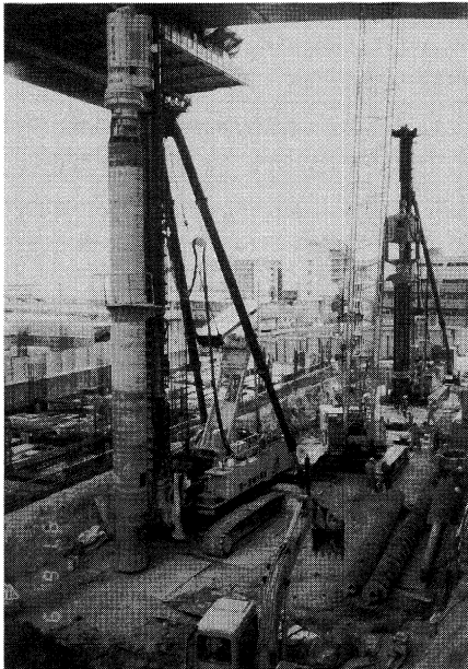
写真-3 鋼管矢板杭（プレボーリング工法）の施工状況
