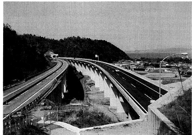
写真-1 土佐泊浦高架橋（下り線）
