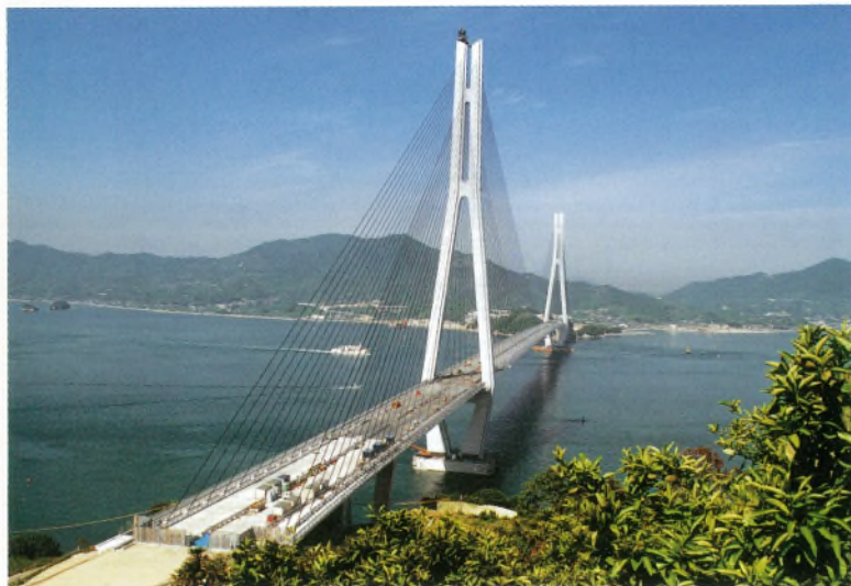
多々羅大橋 全景 Overview of Tatara Bridge
