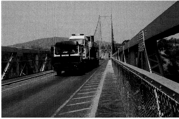
写真-5 橋上をザンビアからジンバブエへ向かうトレーラー。 Photo. 5 Trailer driving on the bridge, heading from Zambia for Zimbabwe.
