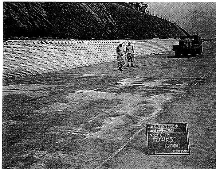
写真-8 表面防護工施工状況 Photo. 8 Work on slope protection
