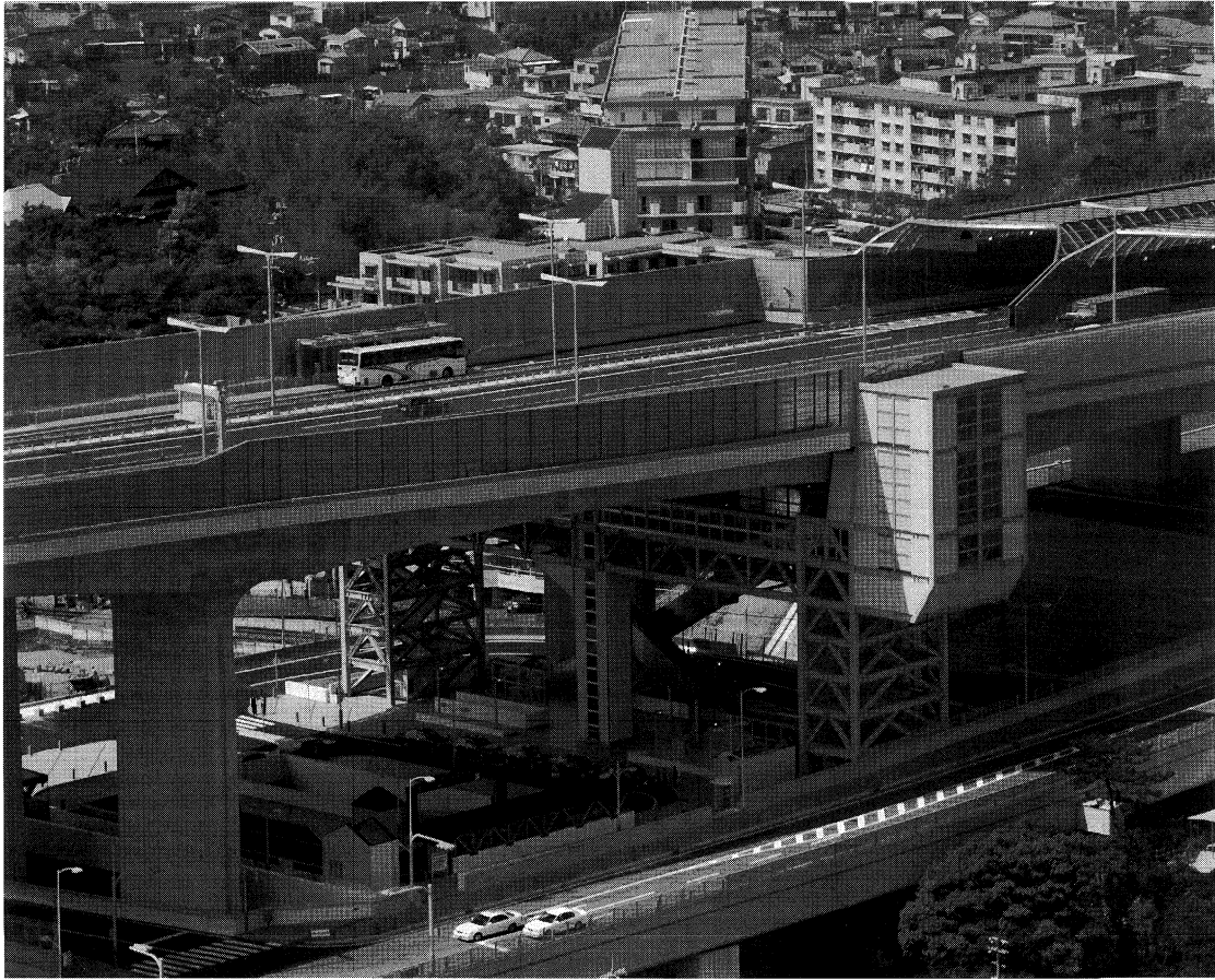
写真-11 舞子BS連絡施設完成状況
