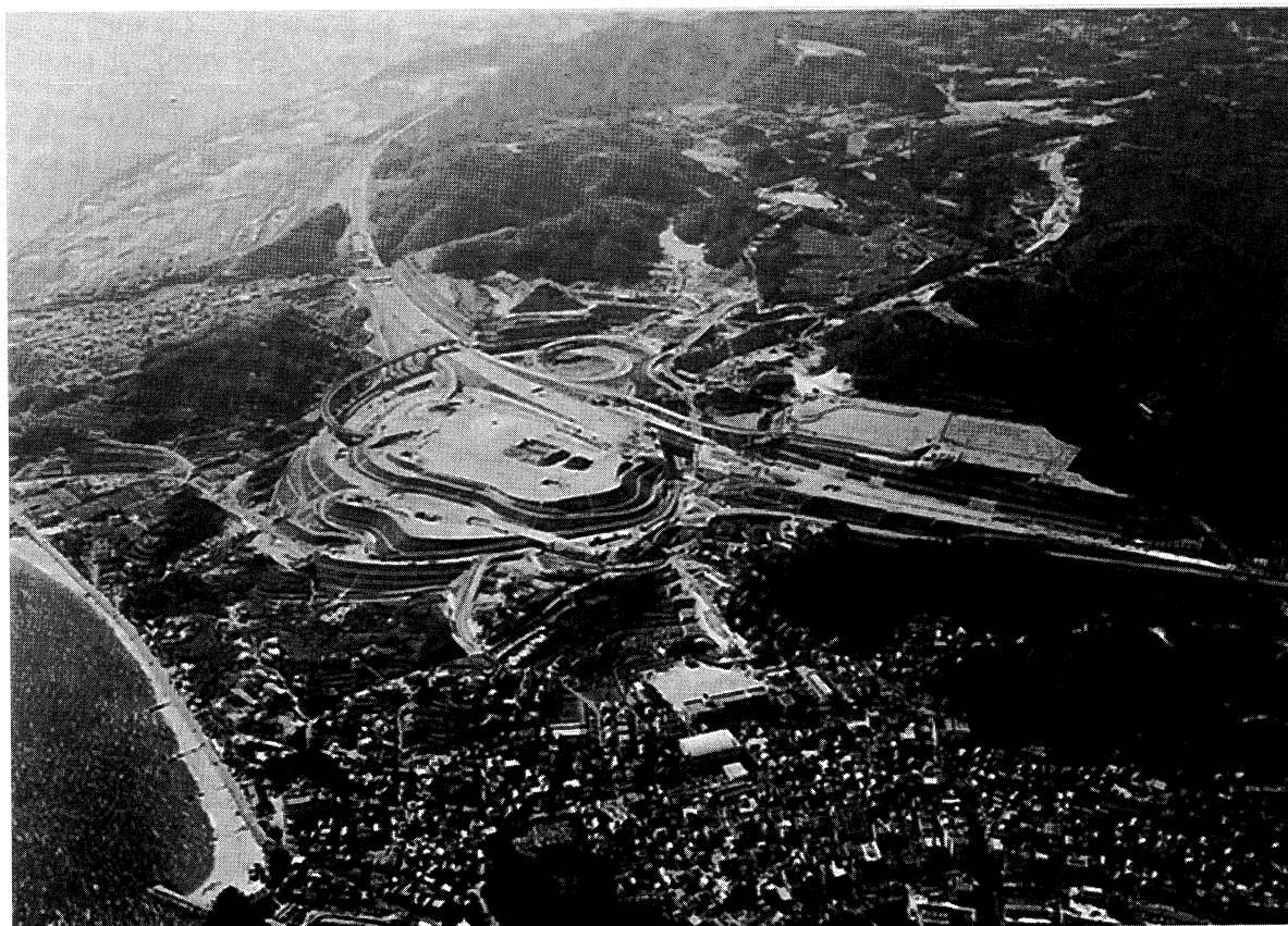
写真－9 淡路IC・SA土工完了状況（平成8年12月）
