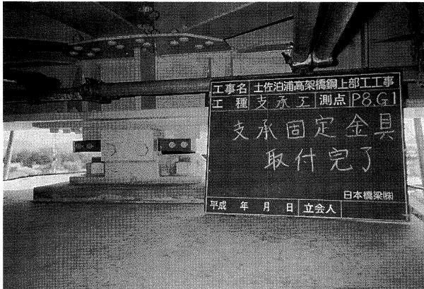
写真-5 固定金具での仮可動沓の固定
