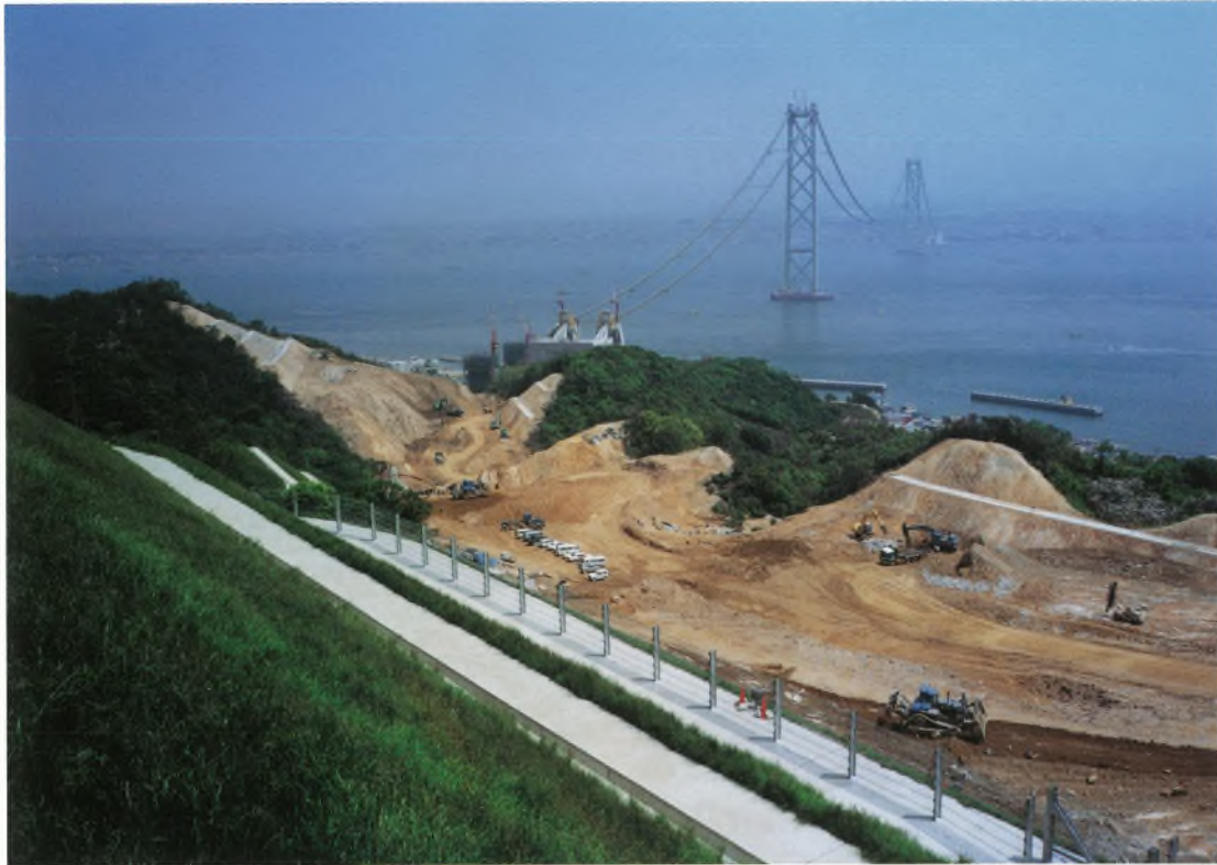
岩屋地区切土状況 Cut work on Iwaya section
