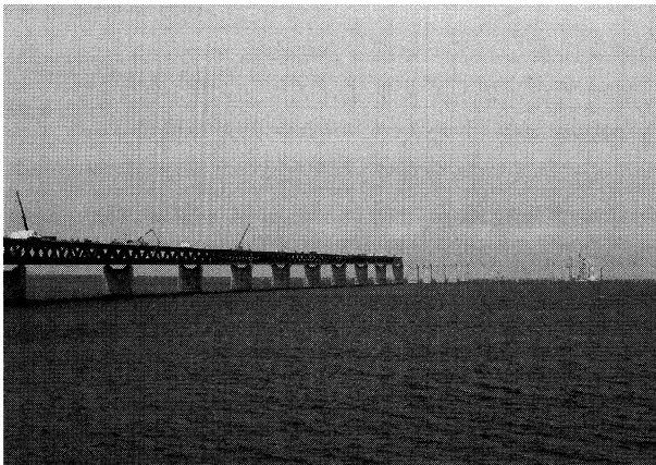
写真-6 高架橋部現況 スウェーデン側から望む
