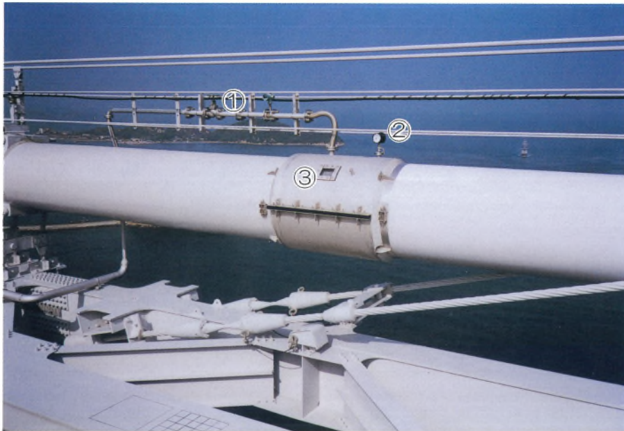
ケーブル防食のための送気設備(送気バンド) 〈北備讃瀬戸大橋 中央径間部〉
