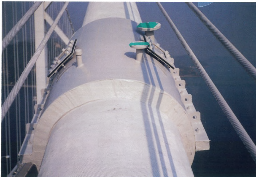
ケーブル防食のための送気バンド（緑テープ：送気配管・圧力計の設置前） 海側・路面側の両サイドにチェック窓の設置
