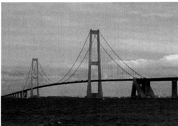
写真-2 グレートベルト東橋全景 人工島より望む Photo. 2 Great Belt East Bridge Viewed from manmade island
