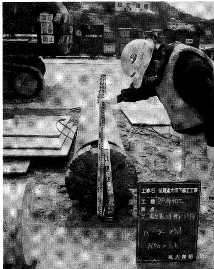
写真-2 DHH 工法ハンマービット Photo. 2 DHH method-hammer bit
