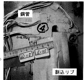
(B) 割込リブ先端でまわし溶接のないすみ肉止端部
