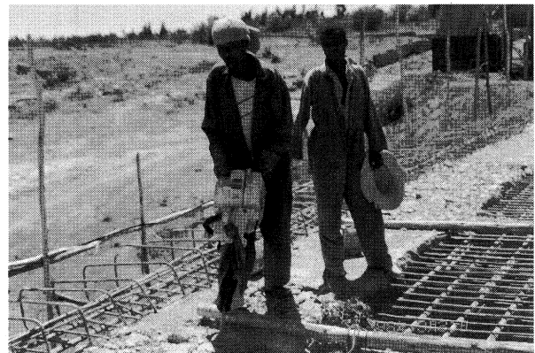
写真—8 Mojo 橋 スラブ部はつり中 Photo.8 Mojo Bridge under chipping slab
