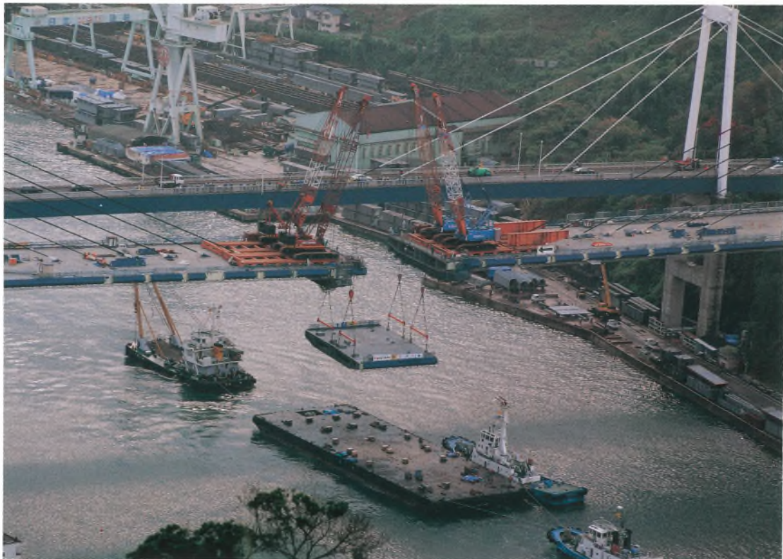
新尾道大橋主桁閉合ブロック架設状況 Shin Onomichi Bridge-erection of block for closing main girder
