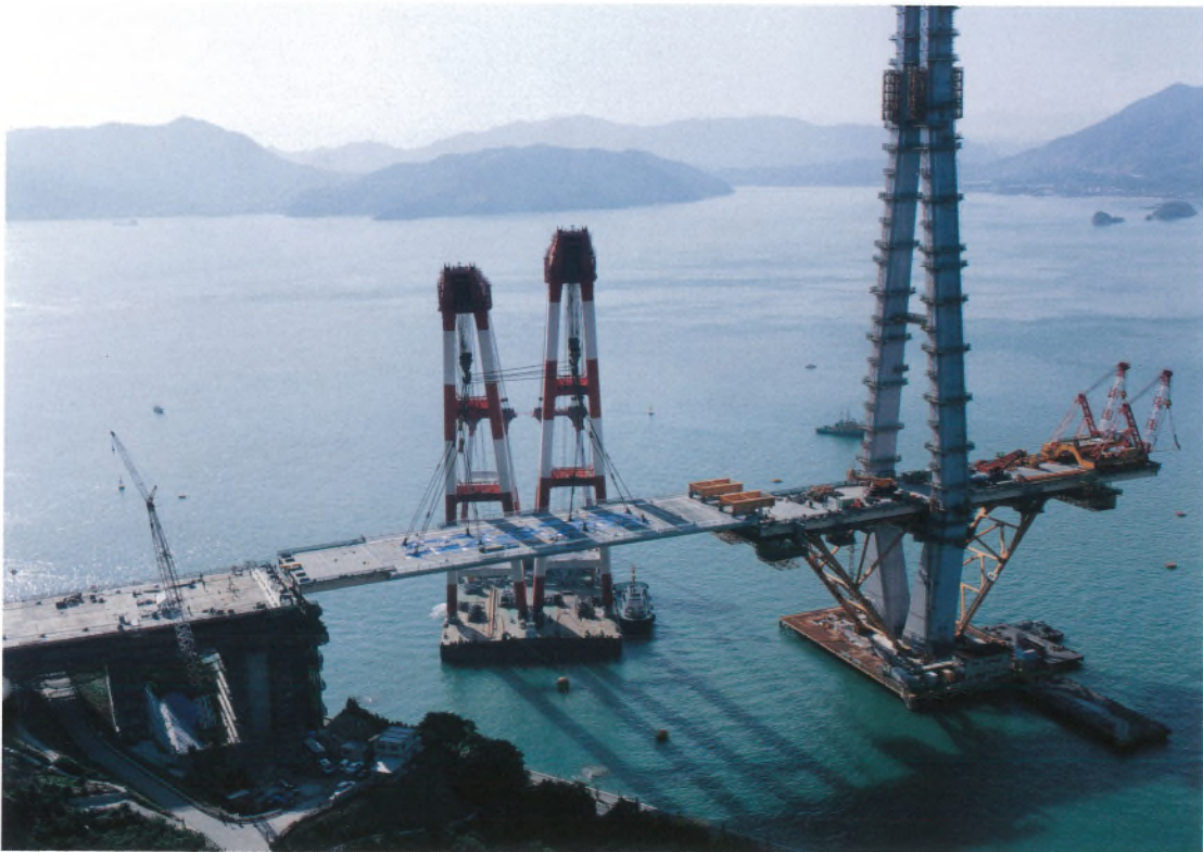
側径間主桁 大ブロック架設 (生口島側) Large block erection of side span deck (Ikuchijima side)
