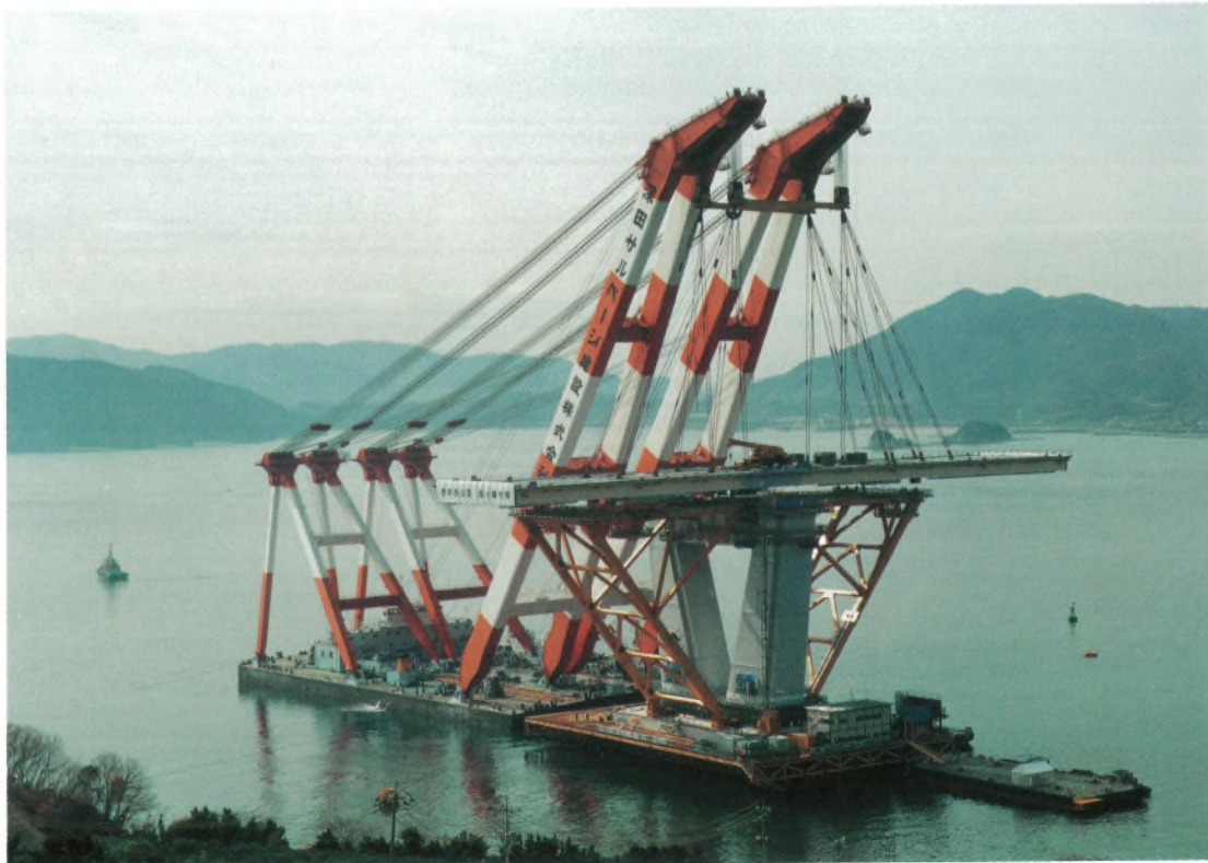
2P 塔付主桁大ブロック架設 Large block erection of deck at 2P pylon
