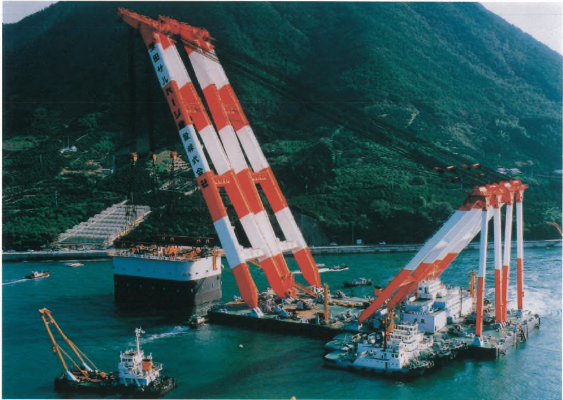
2P 主塔基礎ケーソン設置 Caisson installation at 2P pylon
