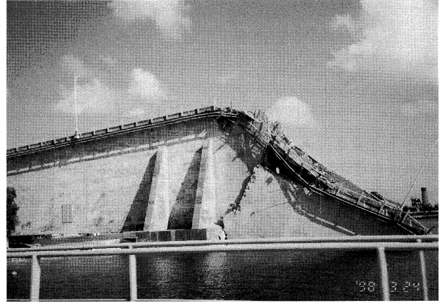
写真-4 Babeldaob 島側橋脚部 直線状に破断
