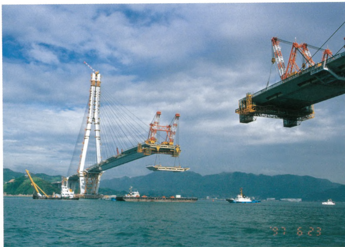
中央径間 主桁 張出架設 (直下吊工法) Incremental launching of deck on center span (lifting)
