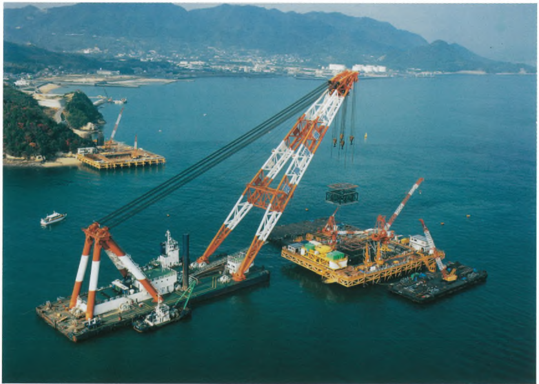
3P 塔アンカーフレーム設置 3P pylon anchor frame installation
