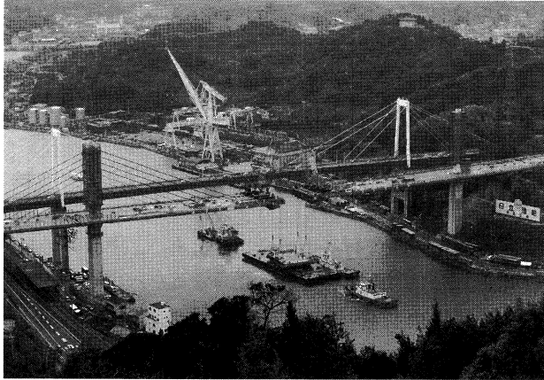
写真-3 閉合ブロック架設状況 Photo.3 Launching of closing deck
