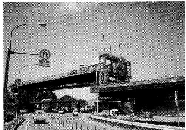
写真-2 向島側送出し架設状況
