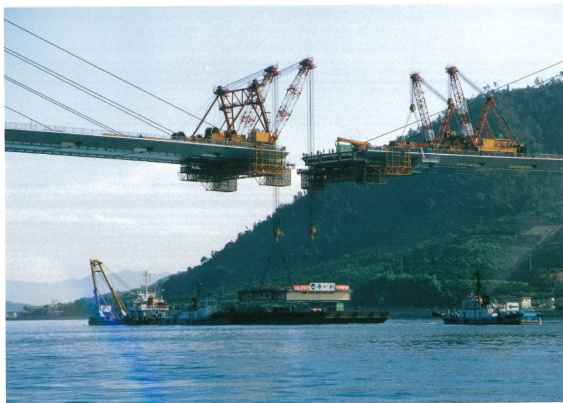
中央径間 閉合ブロック架設 Deck erection for closing member of center span
