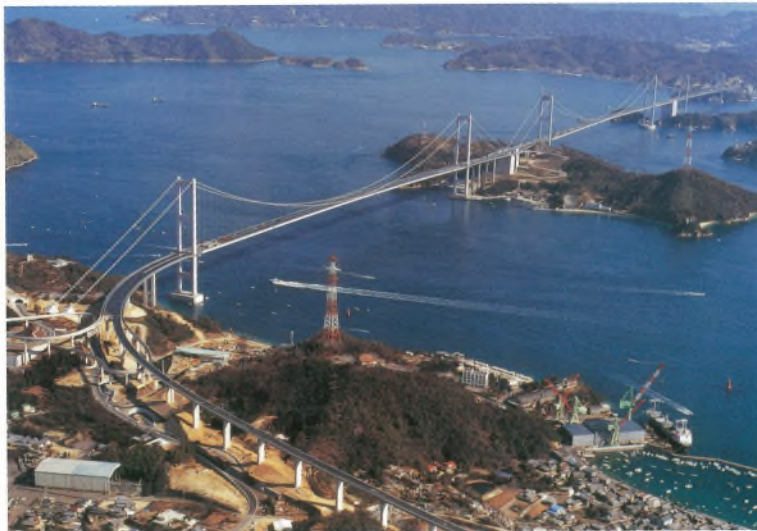
来島海峡大橋工事現況 (空撮) (平成11年2月14日) Current view of Kurushima Kaikyo Bridge work (aerial photography) (February 14, 1999)
