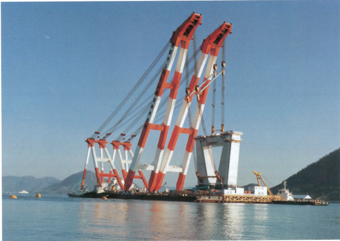
主塔架設 (基部大ブロック架設) Pylon erection (large block erection at base member)
