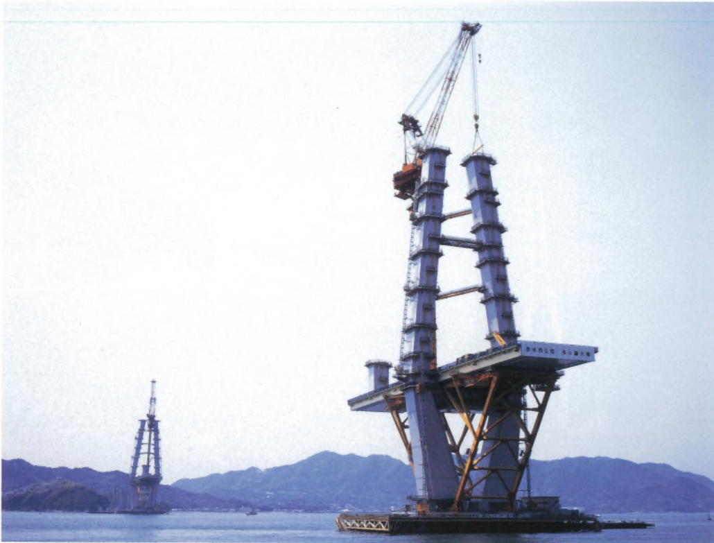
2P 主塔架設 2P pylon erection
