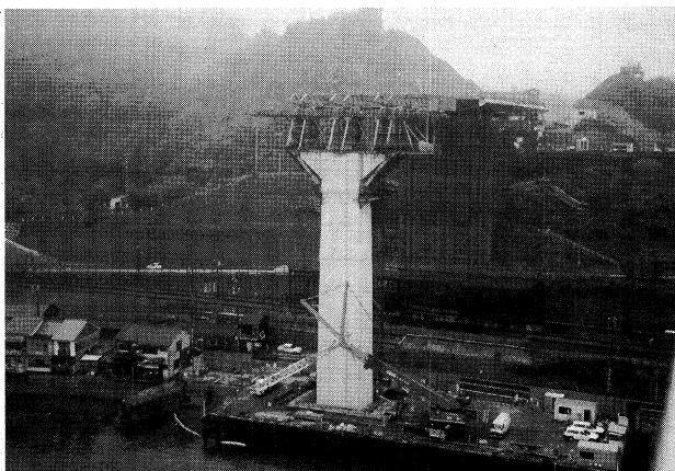
写真-1 尾道側送出し架設状況
