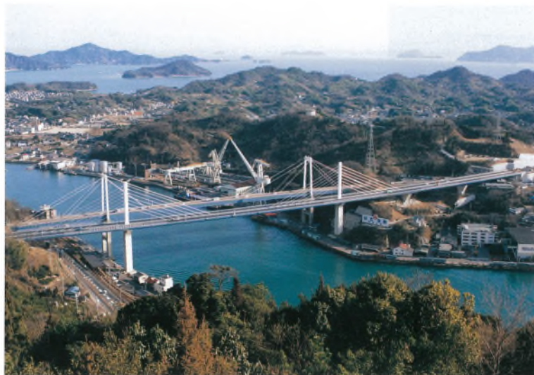
新尾道大橋工事現況 (平成11年 2月末) Current view of Shin-Onomichi Bridge work (End of February, 1999)
