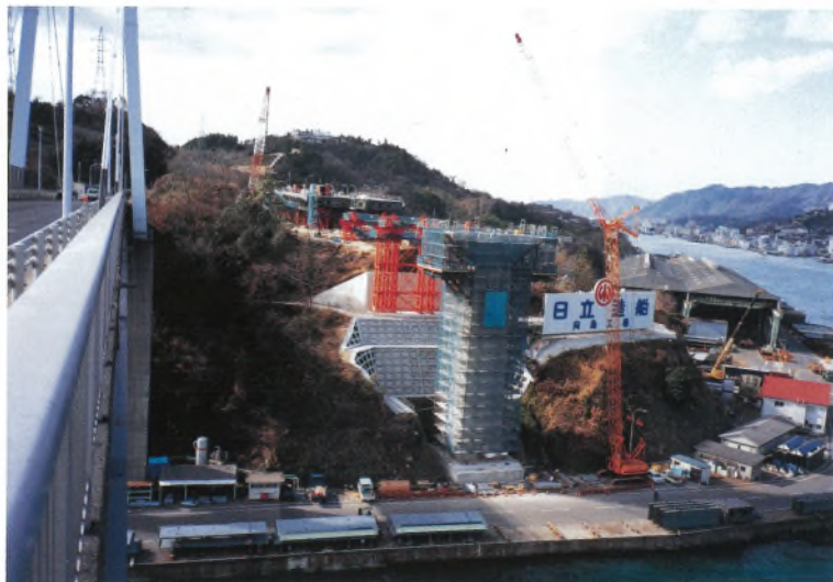
下部工施工状況 (向島側) Current view of substructure work (Mukaishima side)
