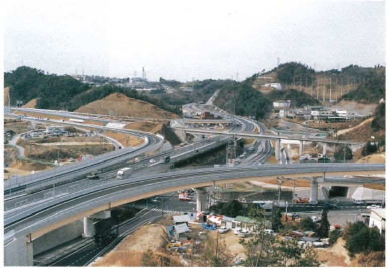
西瀬戸尾道IC工事現況 (平成11年 3月11日) Current view of Nishisetu Onomichi IC work (March 11, 1999)
