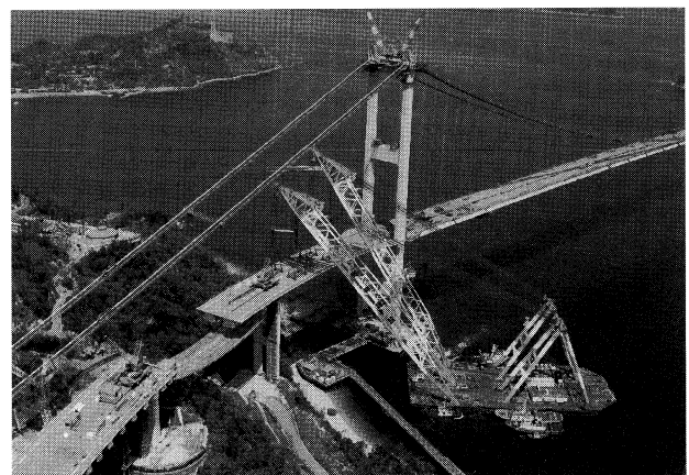
写真-5 大ブロック架設状況 Photo.5 Large block erection
