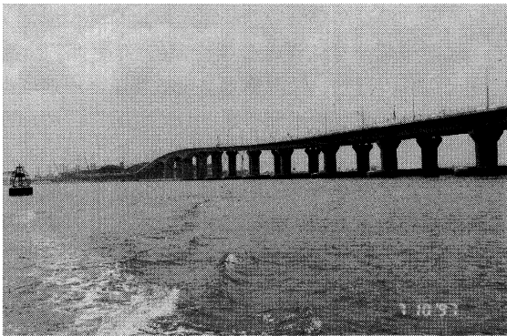
写真一三 マレーシア・シンガポール第二連絡橋
