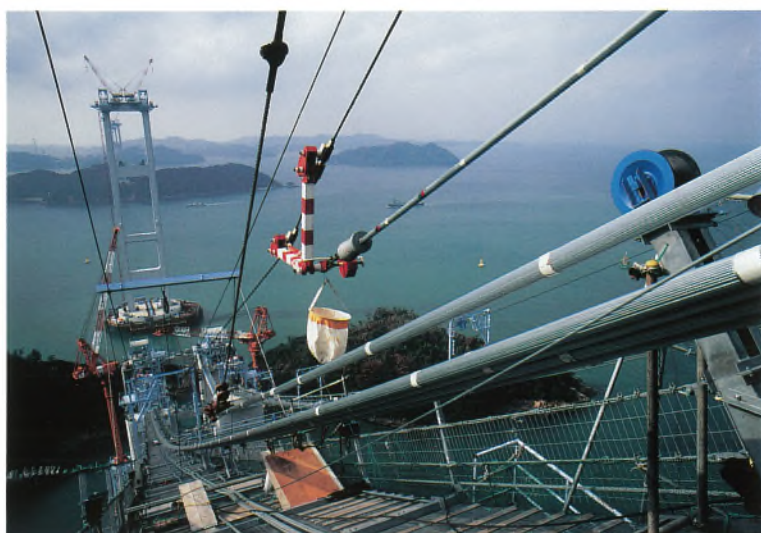
ケーブル・ストランド架設状況 (平成8年12月) (来島海峡第一大橋)
