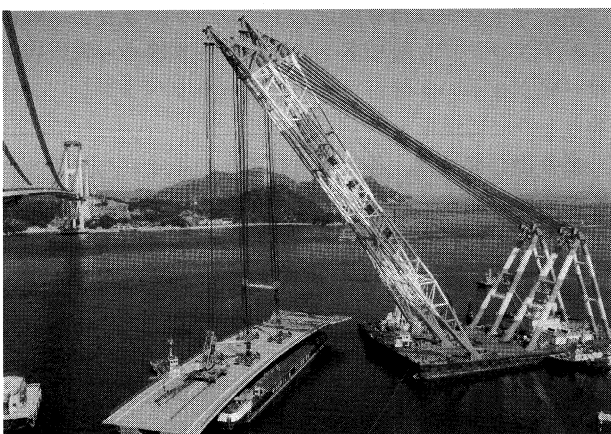
写真-4 水切り状況 Photo.4 Unloading
