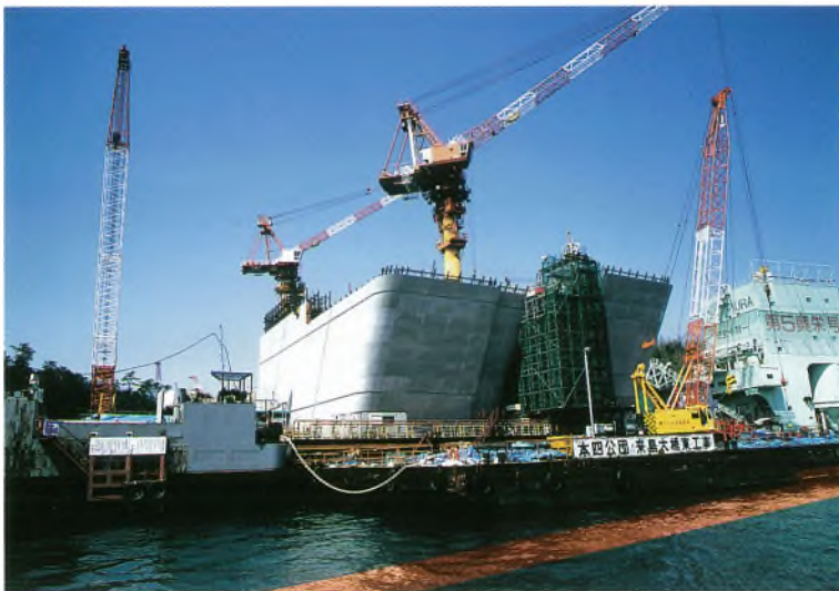
コンクリート打設状況（4A） Concrete placing (4A)
