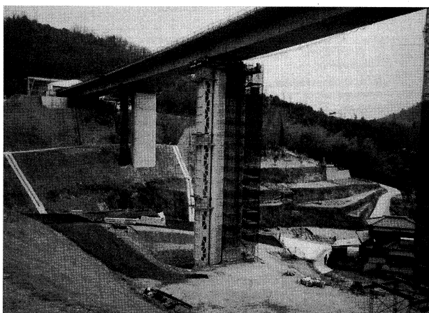
写真-2 SP1及びSP2の仮支柱
