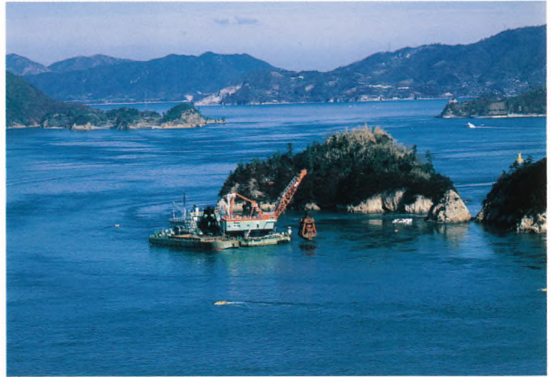
海底掘削状況 (3P主塔基礎) (平成3年12月) Seabed excavation (3 P tower foundation) (December, 1991)
