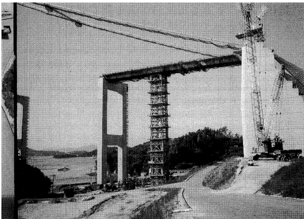
写真-1 工事桁の架設状況 (7A~P4)
