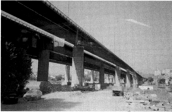
写真-6 ゴールデンホーン橋拡幅工事
