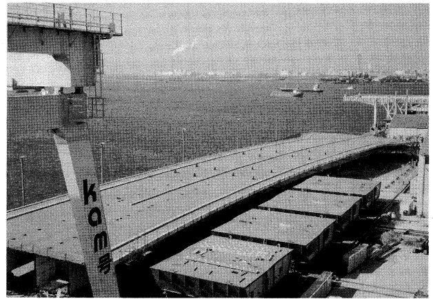
写真-3 施工状況 Photo.3 Work scene
