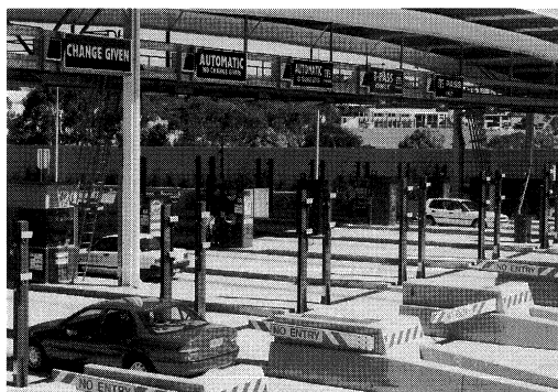
写真-2 M2高速道路の本線料金所
