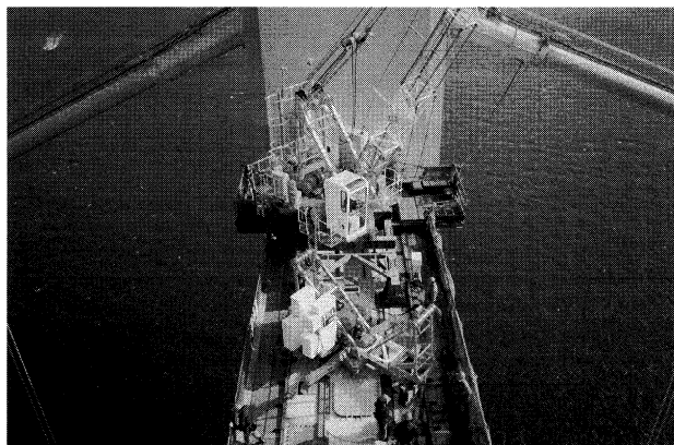
写真-17 撤去用小型クレーンJC-5の組立
