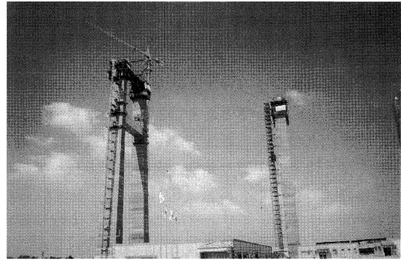
写真-3 施工中のシナイ半島側主塔
