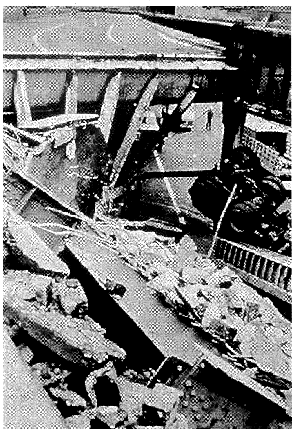
写真-5 オハイオ州シルバー橋の落橋 Photo.5 Collapse of Silver Bridge in Ohio
