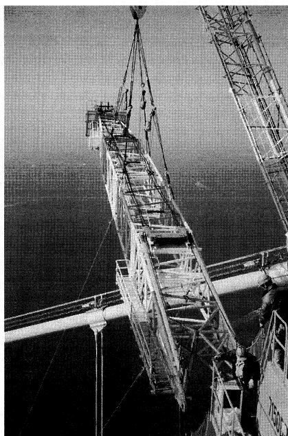
写真-15 既設クレーン1台目撤去
