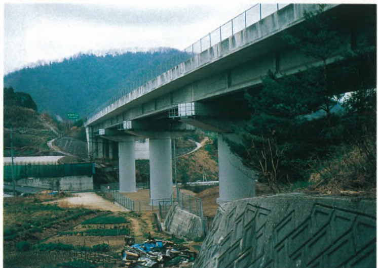
施工後（平成9年3月） After the work (March, 1997)
