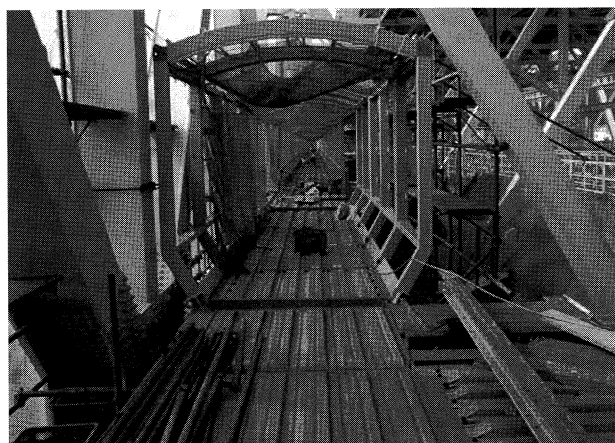
連絡通路の架設状況
