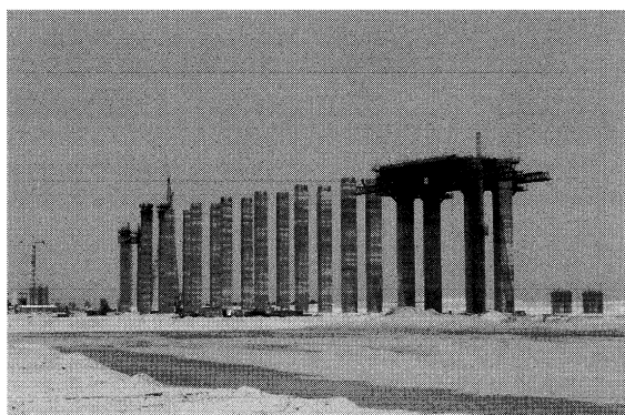
写真-2 シナイ半島側で施工中の高架橋 Photo.2 Viaduct under construction on Sinai Peninsula side
