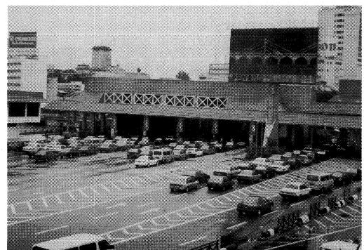
写真-3 マレーシア・シンガポール第1連絡道路の料金所
