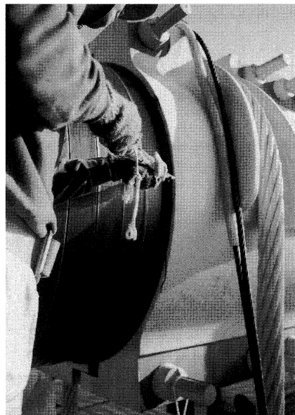
写真-4 ケーブルバンド部コーキング気密材充填状況
