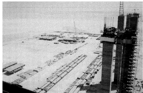
写真-4 主塔上より上部桁組み立てヤードを望む
