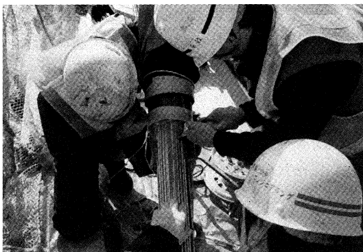
写真一5 損傷したPE管の撤去状況 Photo.5 Removal of damaged PE tube
