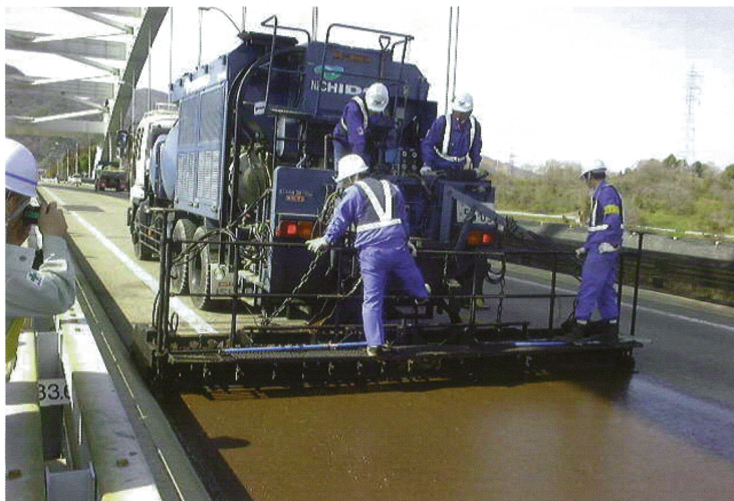
大三島橋でのマイクロサーフェシング施工状況 Micro-surfacing work on Ohmishima Bridge
