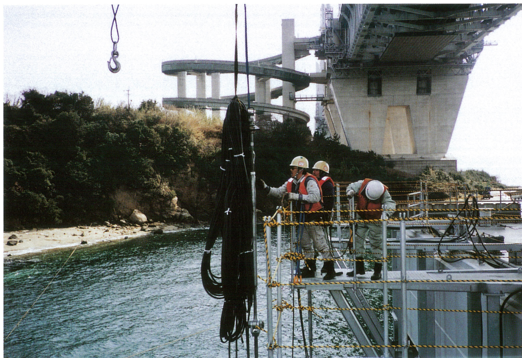
櫃石島橋 3P Hitsuishijima Bridge 3P
