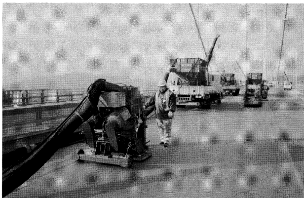
写真-3 ケレン作業状況
