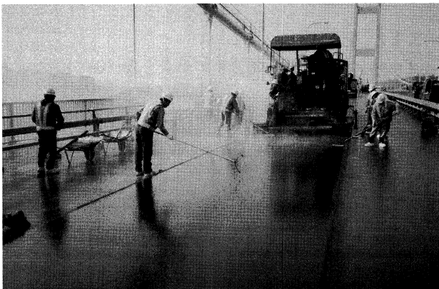
写真-4 ゲースアスファルト混合物補設状況
