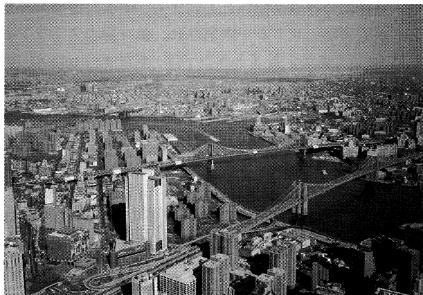
写真-2 手前よりブルックリン橋、マンハッタン橋及びウィリアムスバーグ橋
