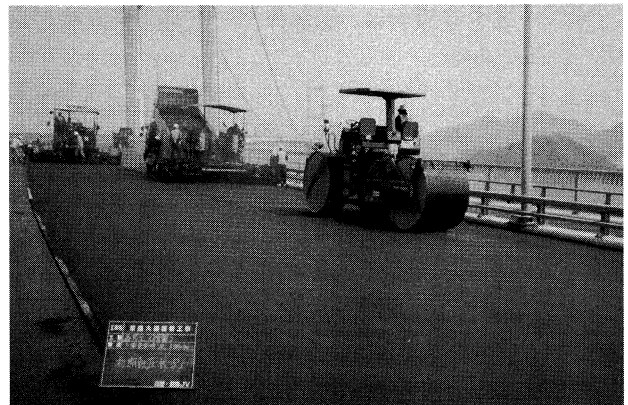
写真-5 改質アスファルト混合物舗設状況
