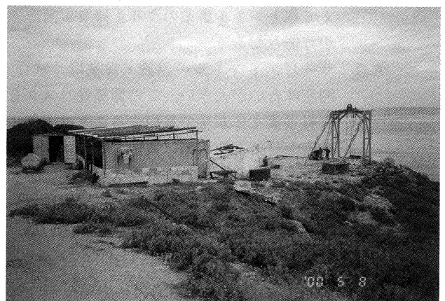
写真-4 マラバータ縦坑 (φ2.5 m、深さ：海面下 300 m)
