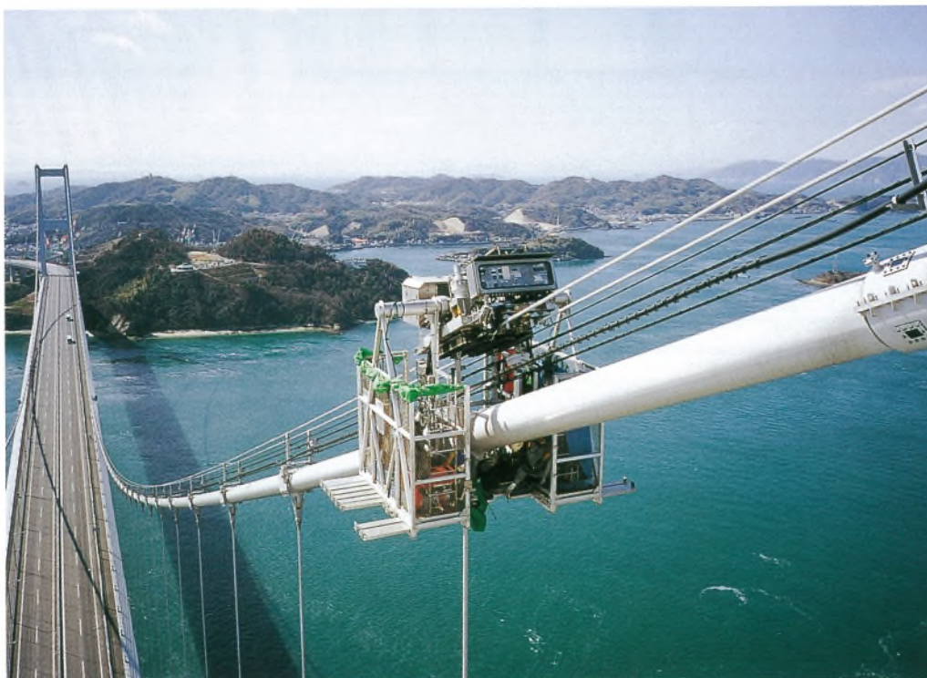
来島海峡第三大橋ケーブルバンドボルトの増締め作業 Retightening work on cable band bolts of Third Kurushima Kaikyo Bridge
