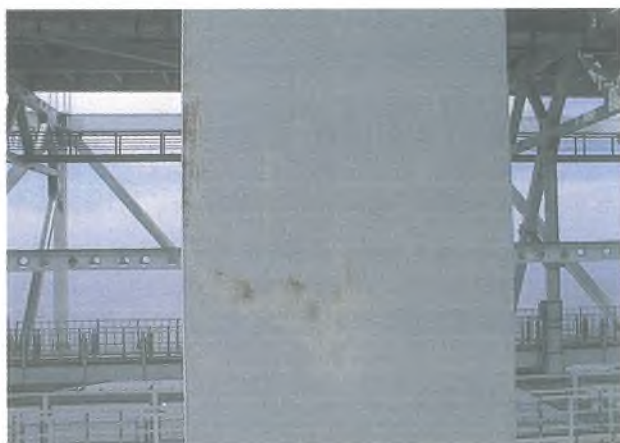
写真-2 一般部の下塗り露出状況写真
