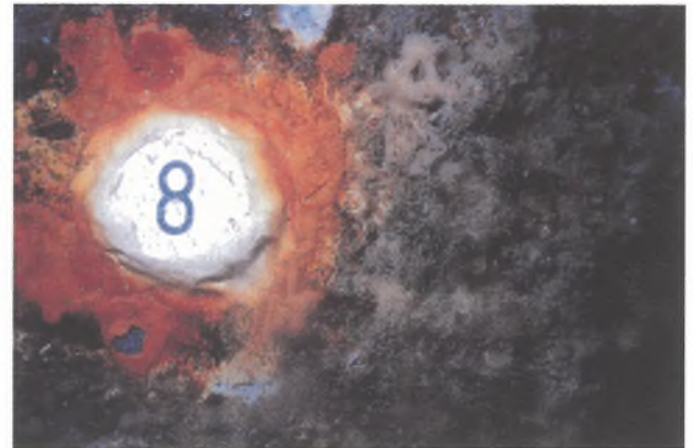
写真-5 通電前状況
