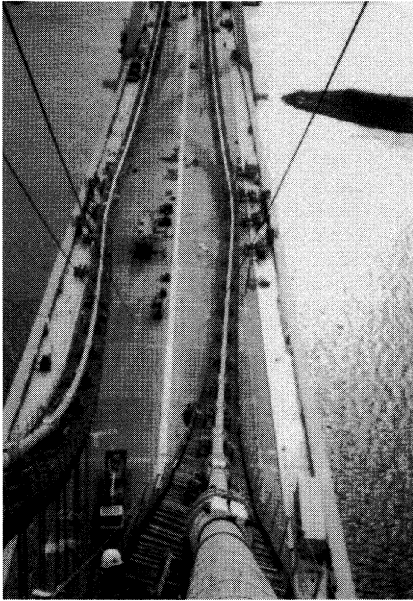
ケーブル架設状況
