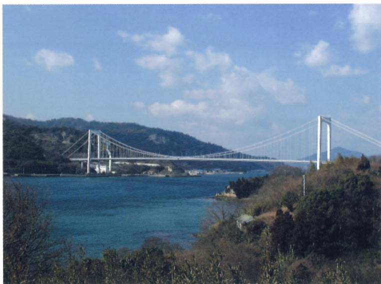
大島大橋全景（伯方島側より） Overview of Ohshima Bridge (viewed from Hakatajima side)
