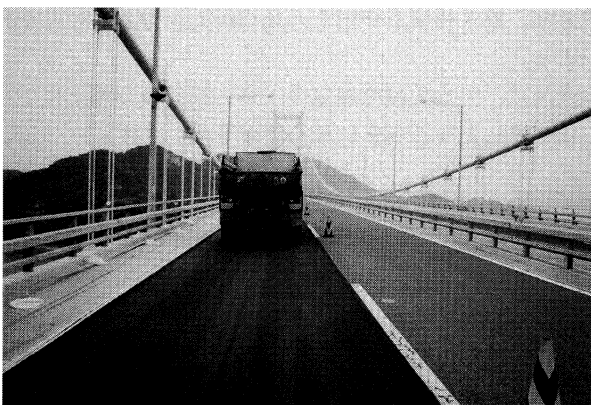
写真-5 ダンプトラックによるテスト走行状況
