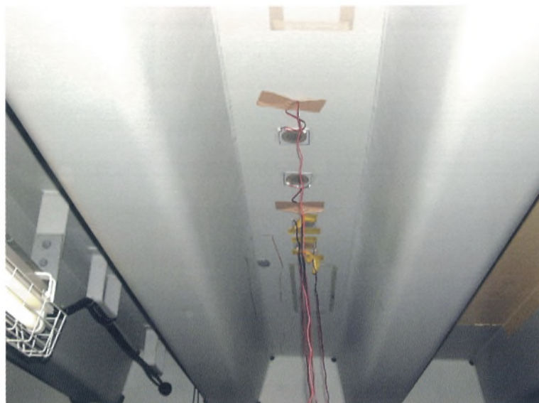
鋼床版裏面への ACM センサー設置状況 Installation of ACM sensors on the surface of steel floor
