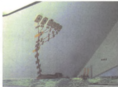
写真-4 箱桁外側面の状況
