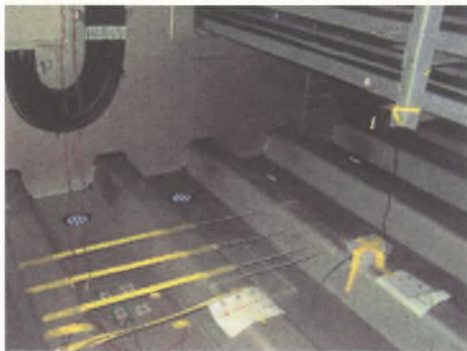
写真-3 箱桁内開口部区画の状況
