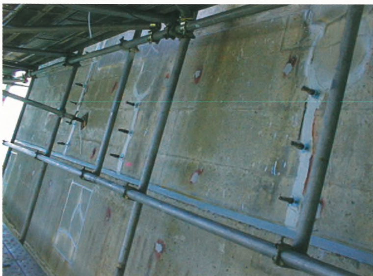
下地処理 (クラックの補修) Surface finishing (repair of crack)
