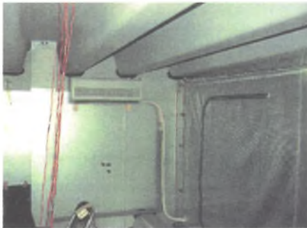
写真-2 除湿区画内の状況
