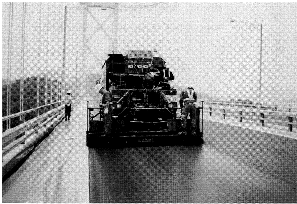
写真-3 混合物の製造・敷均し状況
