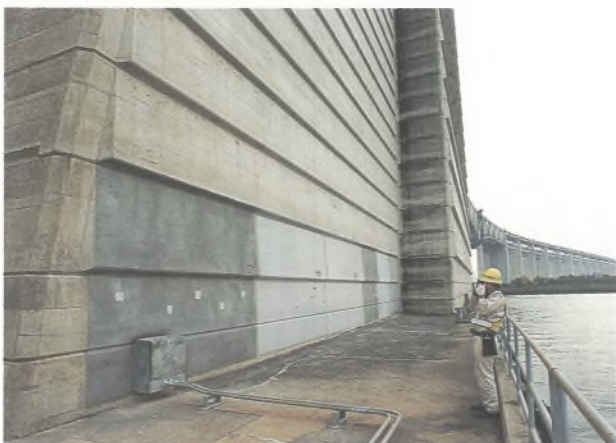
写真-3 南備讃瀬戸大橋 7 A 側面塗装状況
