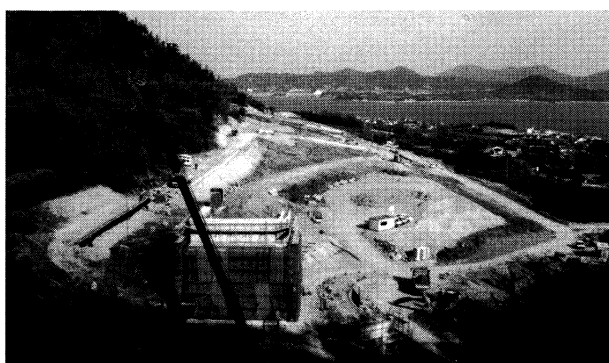
写真-2 波戸岡川橋付近の施工状況
