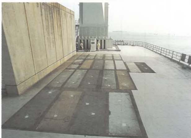
写真-2 櫃石島橋 2 P 基礎天端塗装状況
