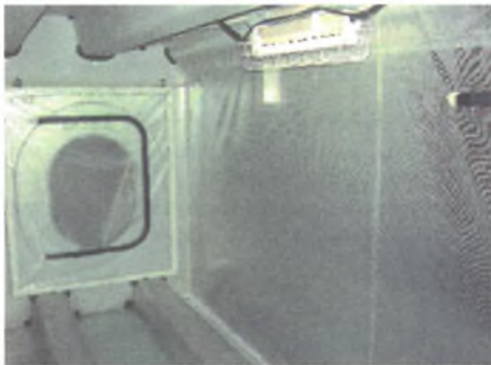
写真-1 除湿区画の間仕切り状況
