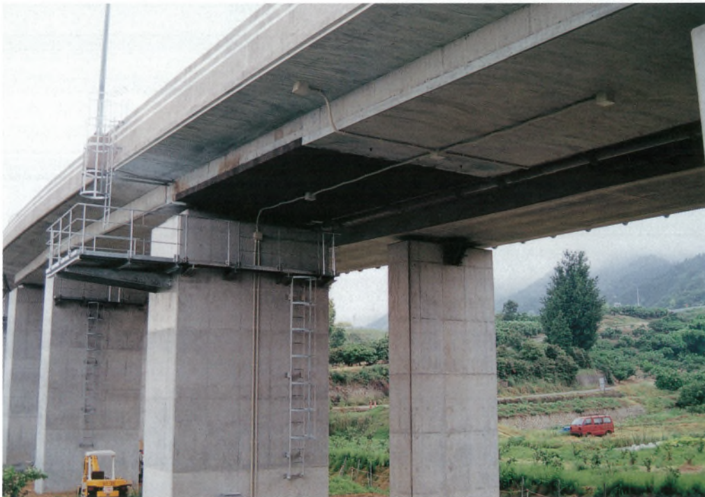
第一大三島ランプ橋施工後全景
