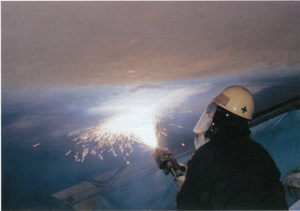
チタン溶射状況
