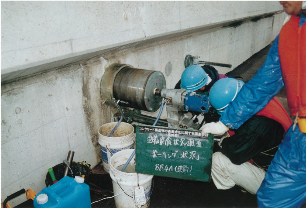
南北備讃瀬戸大橋 4 A 東面のボーリング状況
