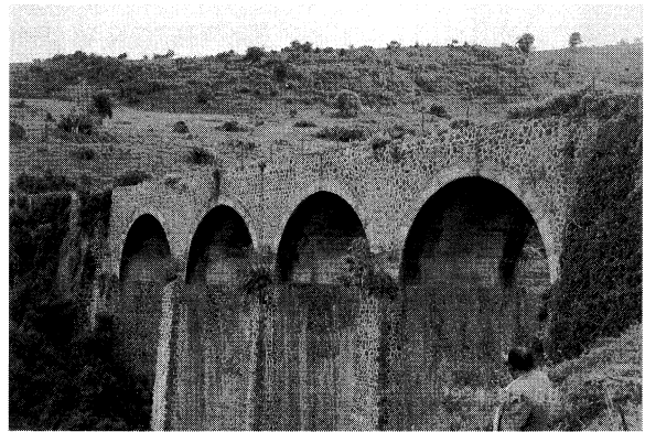
写真-1 石アーチ橋
