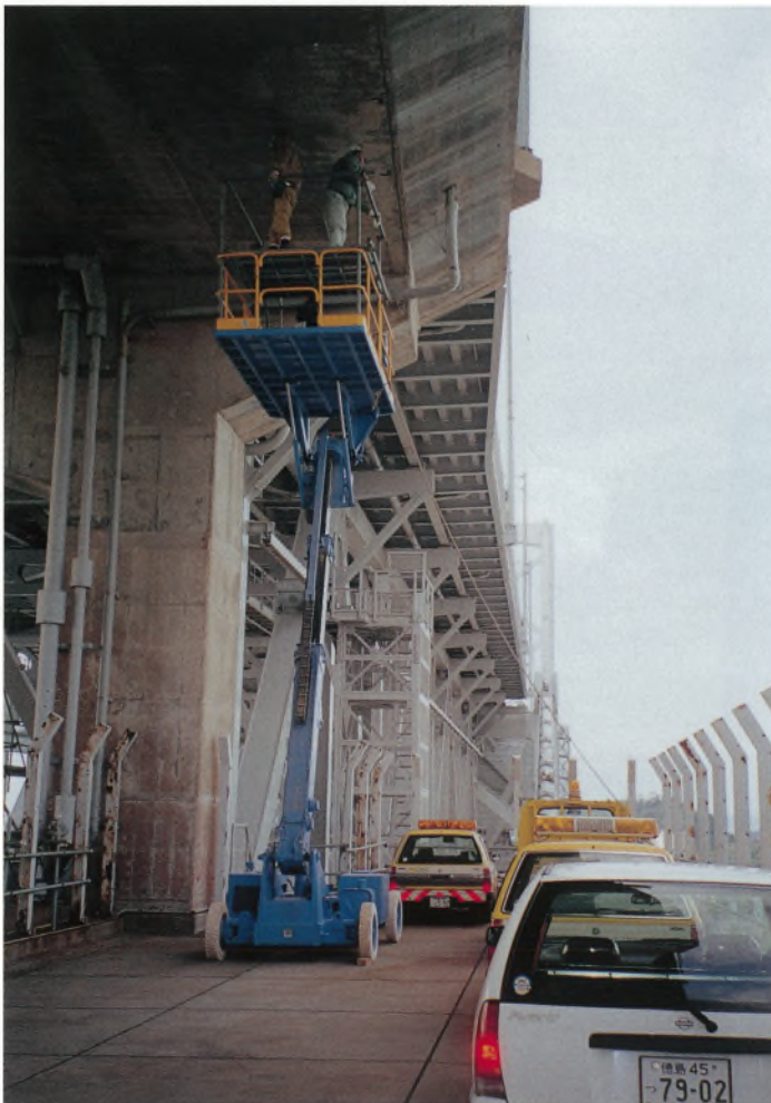
大鳴門橋 1 A リフト車を使った 道路桁スラブ底面の調査
