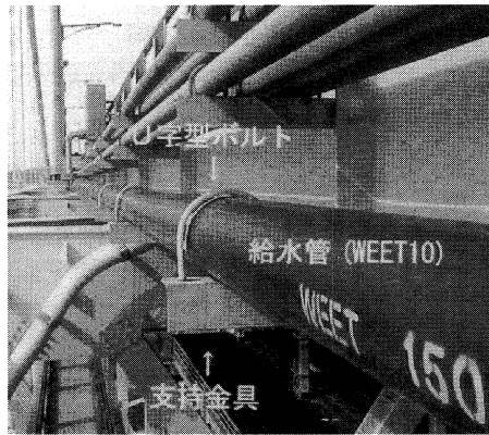
写真-1 給水管添架状況
