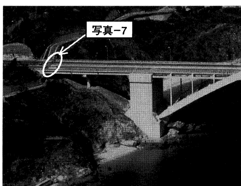
写真-8 上沓セットボルト破断位置 Photo.8 Location of sheared set bolt of upper bearing
