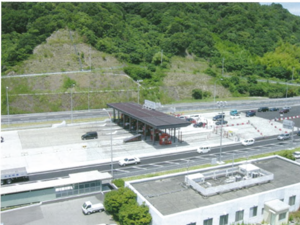
写真—2 連結後の鳴門 IC 本線料金所
