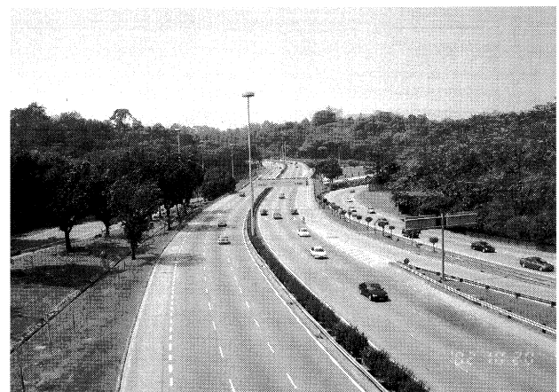
写真-2 JKRが建設し、現在はクアラルンプール市が管理している道路。通行は無料
