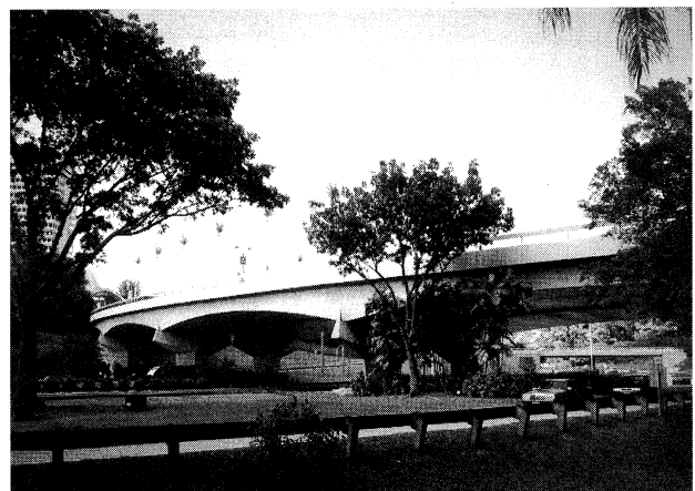
写真-6 パーリアメント橋。RC 4 径間ゲルバー桁構造
