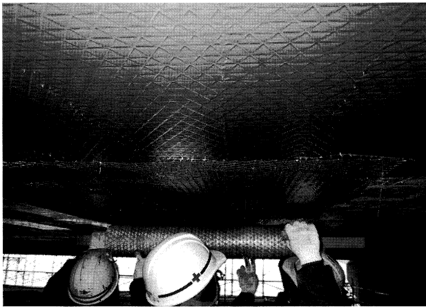
写真-6 繊維シート貼り作業状況
