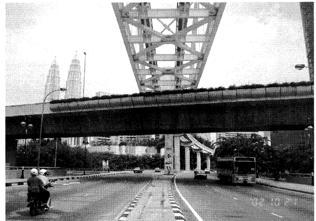
写真-1 クアラルンプール市内。モノレールの鋼アーチ橋とハイウェイのコンクリート桁の立体交差。コンクリート桁にはフラワーポットが設置。左奥に高さ452mのツインタワーが見える。
