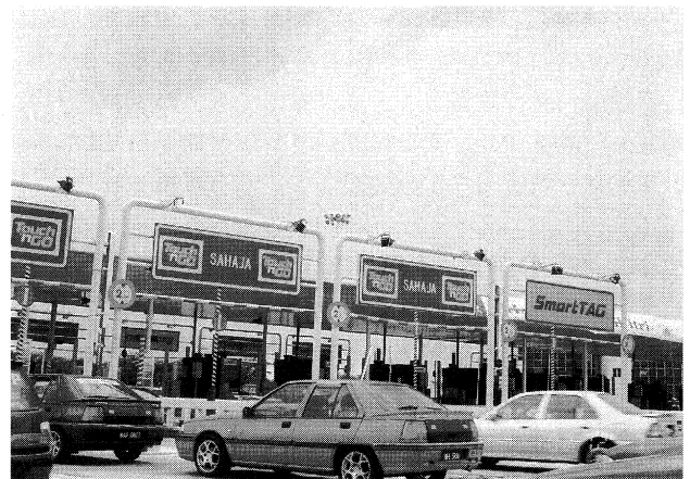
写真-3 南北高速道路の料金所。左の3ゲートがタッチング・ゴー、最右ゲートがスマート・タグ
