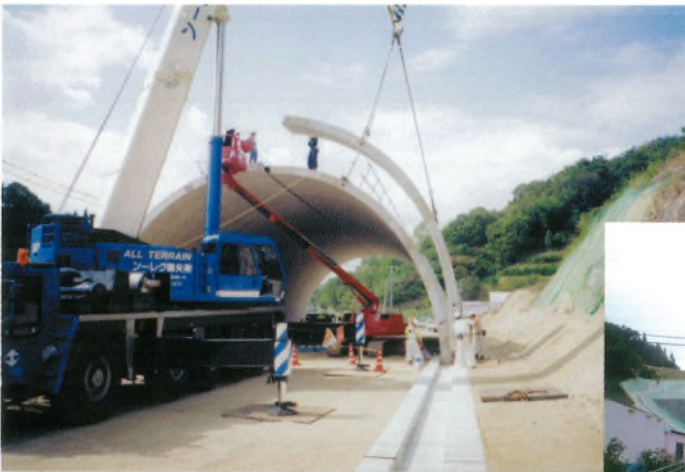
写真-2.1 テクスパン工法でのアーチ部材架設状況（大島道路）
