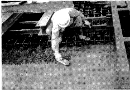
写真-1 中央分離帯部施工状況
