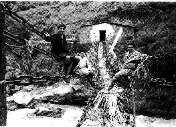
写真-3 ドクスム・チェーン橋(支間長 60 m)(写真提供 DOR) Photo.3 Duksum chain Bridge (Span 60 m) (Offered by DOR)
