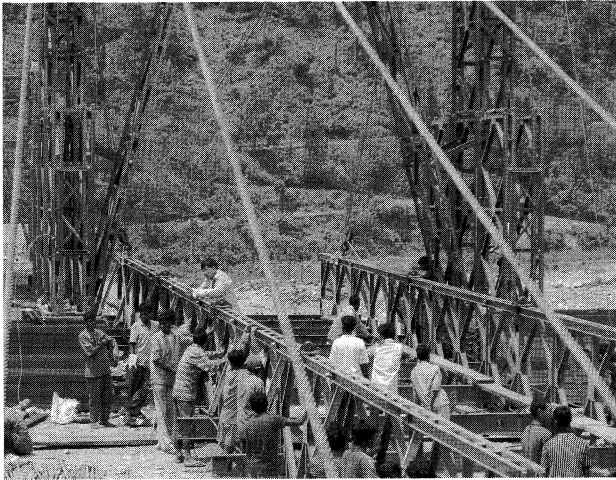
写真-6 ベイリー吊橋 補剛桁組み立て
