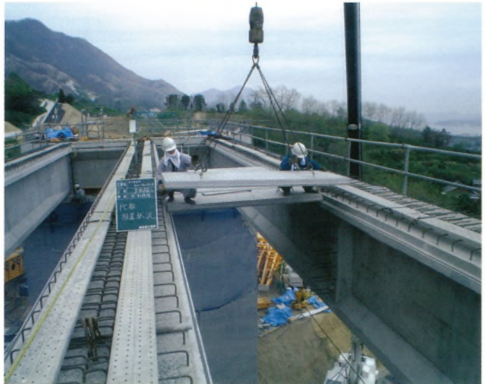
写真-1 PCコンボ橋のPC床版の架設状況（生口島道路）
