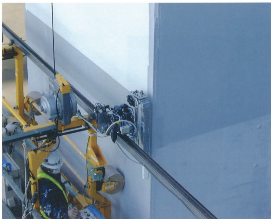
写真一2 主塔塗替塗装装置（上塗作業：因島大橋 2 P 東塔柱）
