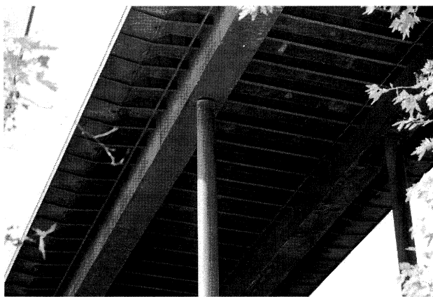
写真-3 第一ボスポラス橋側径間部の橋脚
