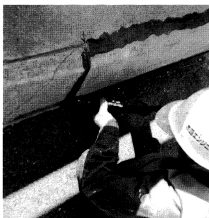
写真-3 石油防水工施工状況
