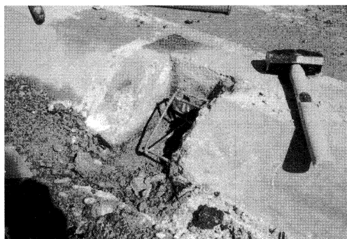
写真-2 漏水調査（縁石除去状況）
