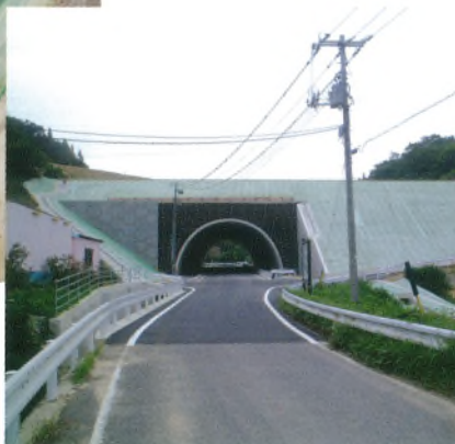
写真-2.2 盛土施工状況
