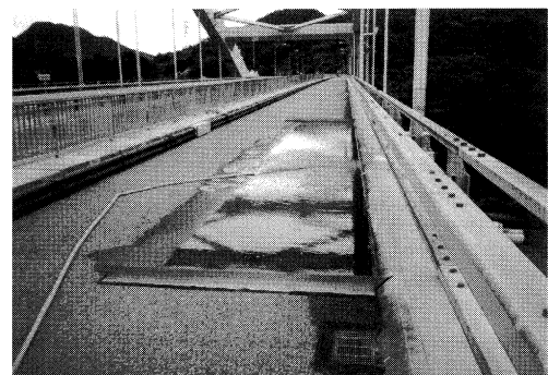
写真-7 表面滞水による止水機能確認
