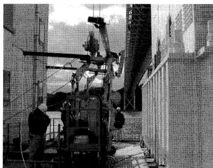
写真-3 塗装装置と磁石車輪ゴンドラ
