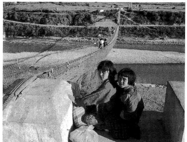
写真-4 ポチュ橋 (写真提供 DOR) 支間長 280 m はブータン最長である Photo.4 Pho Chhu Bridge (Offered by DOR) The span of 280 m is the longest in Bhutan
