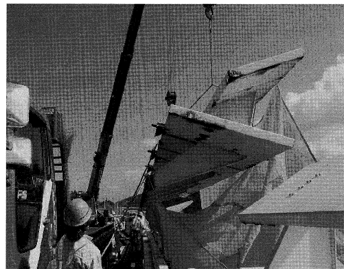
写真-5 撤去作業状況 photo.5 Removal work
