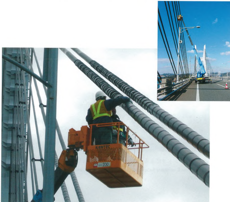
写真—4 斜張橋並列ケーブル制振対策状況（櫃石島橋）
