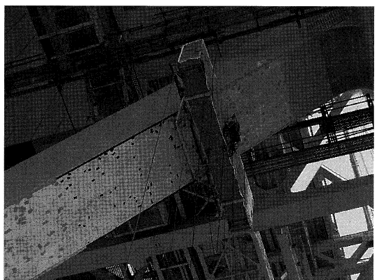
写真-6 主塔斜材下面試験
