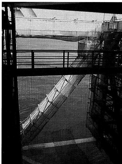
写真-4 主横改良足場
