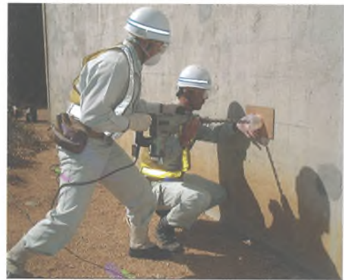
写真-3 コンクリート粉採取
