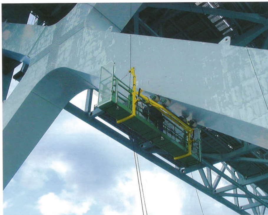
写真一1 磁石車輪ゴンドラによる主塔塗替え作業（大鳴門橋3P斜材下面）
