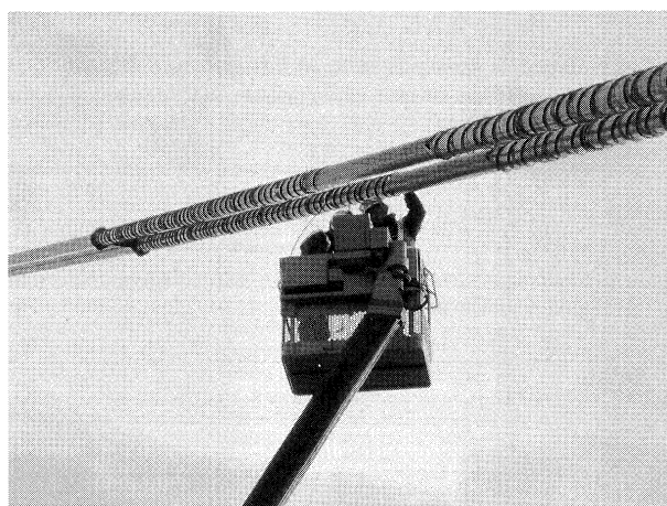
写真-1 制振装置設置状況
