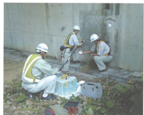
写真-4 自然電位測定
