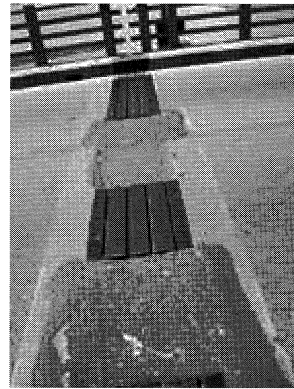
写真-1 一時的に補修された伸縮継手 (メグナ・グムティ橋)
