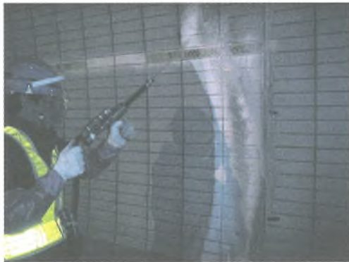
写真-4 高圧洗浄実験の状況
