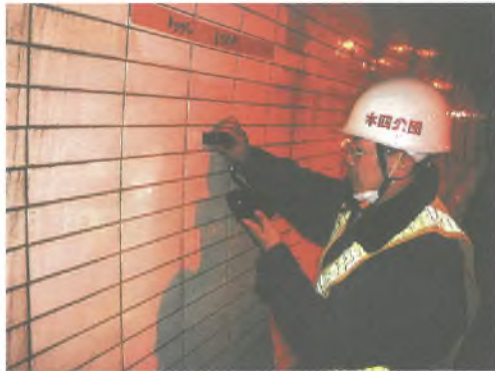
写真-5 光沢度の測定状況
