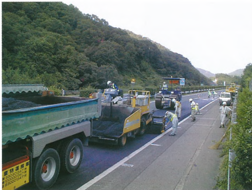
写真一3 瀬戸中央自動車道（早島管内）舗装改良工事
