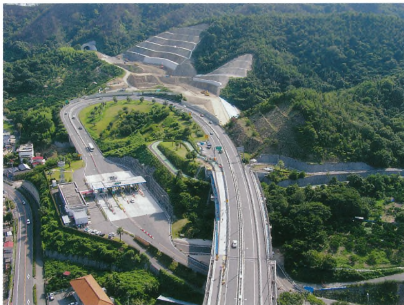
写真一4 生口橋西高架橋（生口島内）拡幅工事
