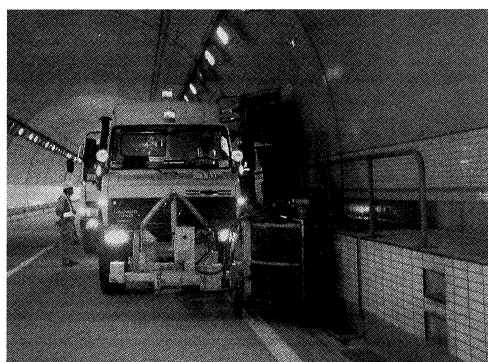
写真-1 万能車による壁面清掃状況
