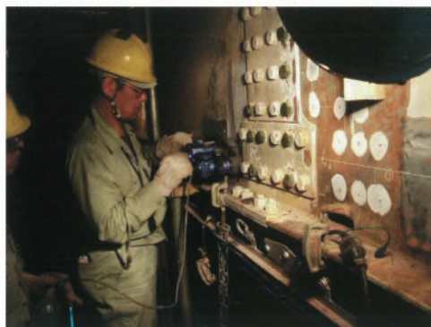
写真-3 ボルト孔穿孔状況 (桁内) Photo.3 Bolt holing (Inside the girder)
