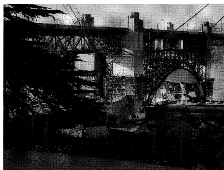
写真-2 ゴールデンゲイト橋SF側取付橋の耐震補強
