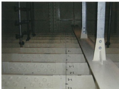
写真-2 施工前の状況 (墨位置が図面でない溶接線)
