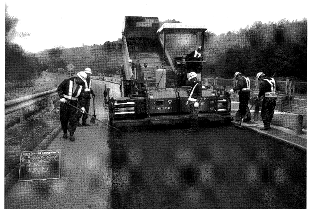
写真-9 アスファルトフィニッシャ敷き均し状況写真 Photo.9 Paving flatly by asphalt finisher
