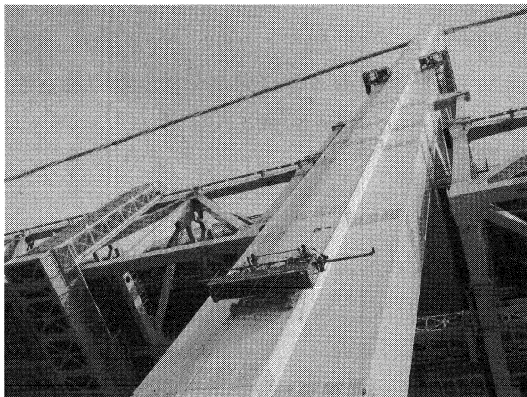
写真-1 塗替塗装状況（瀬戸内側）
