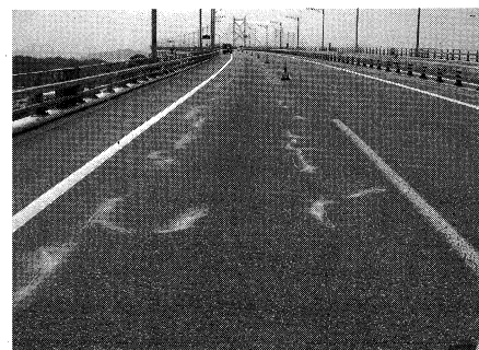
写真-6 補修材注入後乾燥砂を散布
