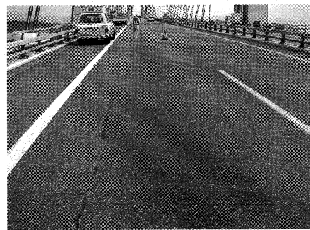
写真-4 補修材注入後全景（櫃石島橋下り走行車線）
