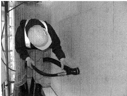
写真-1 表面処理の施工状況
