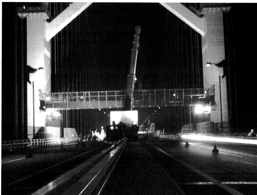
写真-3 架設状況
