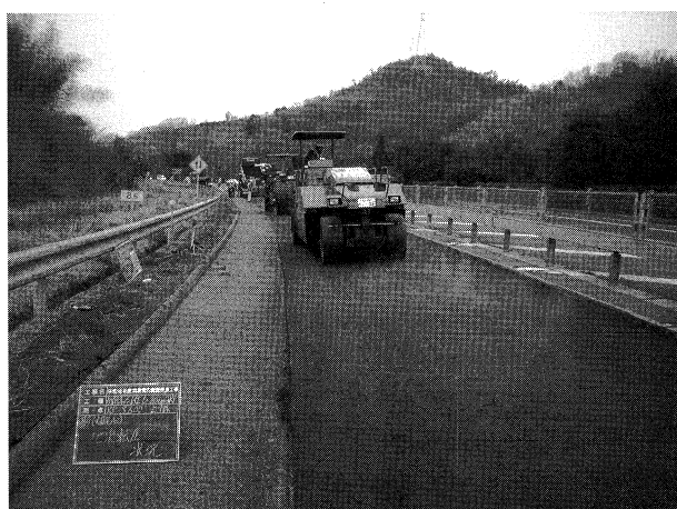
写真-11 タイヤローラ締め固め状況写真
