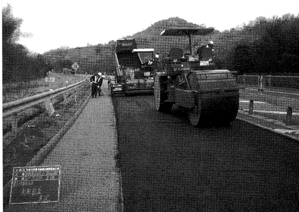
写真-10 マカダムローラ締め固め状況写真
