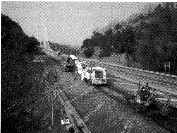
写真-8 切削状況写真 Photo.8 Cutting pavement
