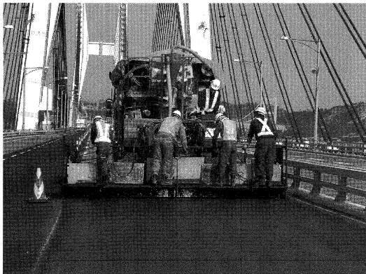
写真-7 薄層舗装施工状況
