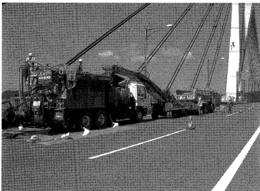
写真-8 骨材供給状況
