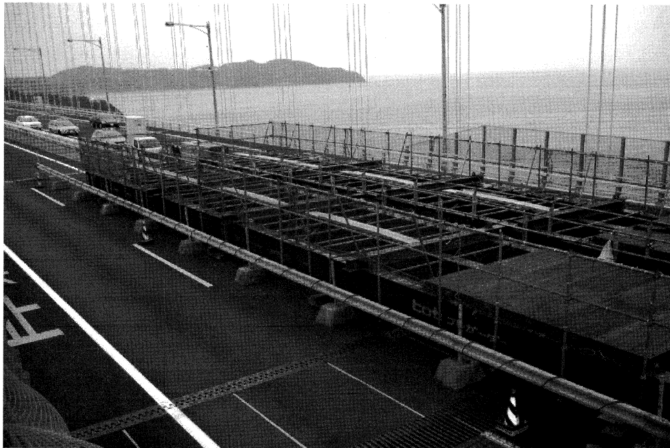
写真-2 地組立状況
