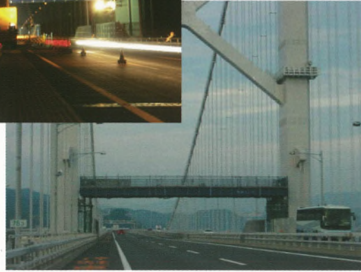
写真一2 路面防護工（完成） Photo.2 Completed Road Protection
