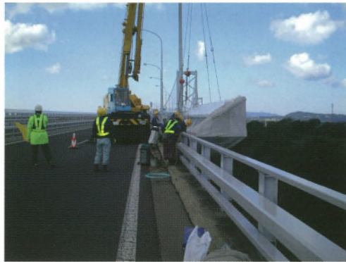
写真一3 ダブルフラップ撤去状況 Photo.3 Removing Double Flaps
