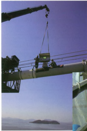
写真—5 送気カバー増設（北備讃瀬戸大橋） Photo.5 Building more Injection Cover (Kita Bisan-Seto Bridge)
