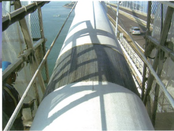
写真—6 アンラッピング状況（南備讃瀬戸大橋） Photo.6 Unwrapped Cable (Minami Bisan-Seto Bridge)
