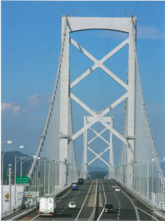
写真—1 主塔塗替塗装完了
