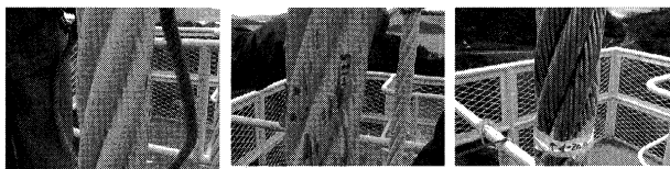
写真-3 素地調整後 (50 MPa) 写真-4 素地調整後 (125 MPa) 写真-5 素地調整後 (200 MPa)
