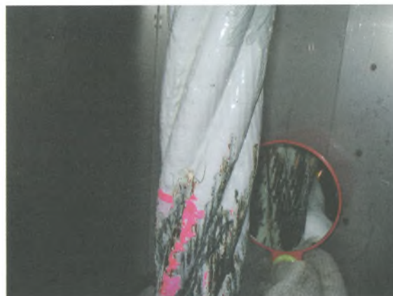
写真-2 充填材圧入位置ロープ裏面の塗膜除去状況
