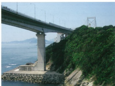
写真—6 門崎高架橋遮風壁設置完了状況
