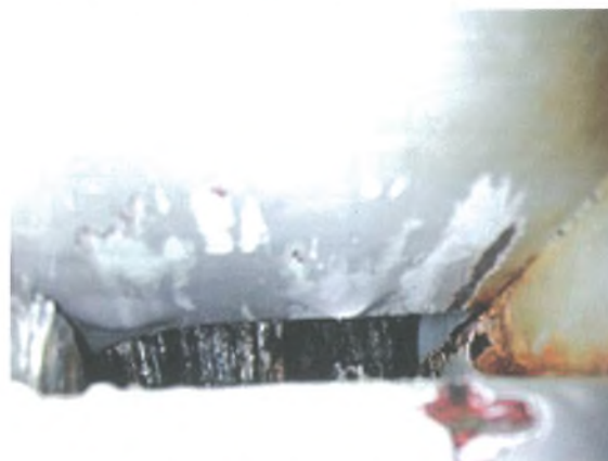
写真-3 支圧板部充填確認位置の塗膜除去状況
