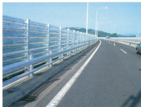
写真—7 門崎高架橋遮風壁設置完了状況（近景）
