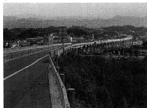
写真-1 阿方高架橋 (尾道側より撮影)
