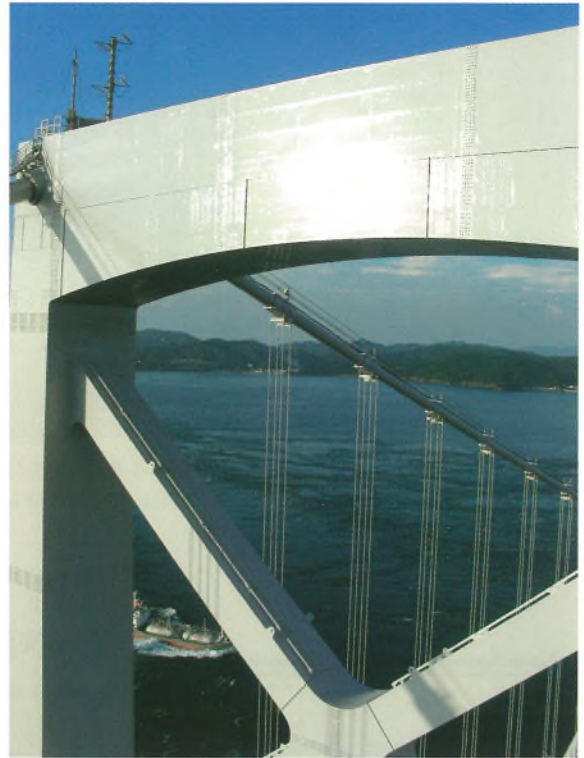
写真—2 主塔塗替塗装完了 (近景)
