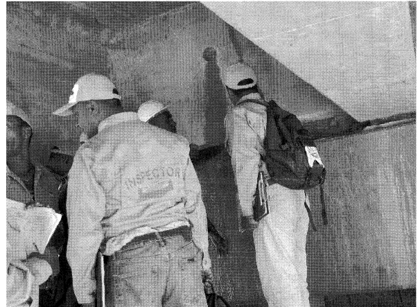
写真-4 橋梁点検
