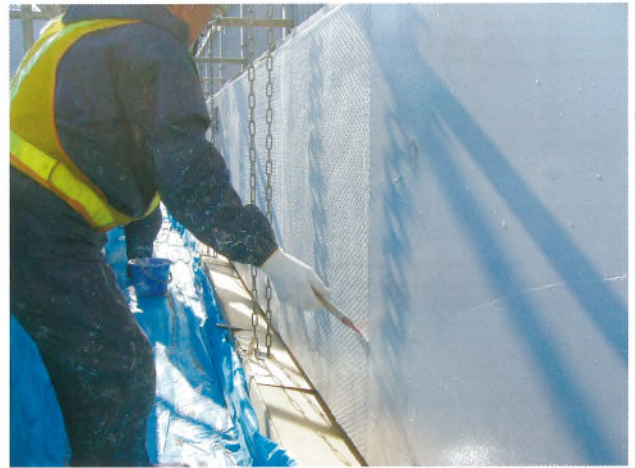
写真-8 コンクリート剥落防止工施工状況 Photo 8 Working of countermeasure against peel off
