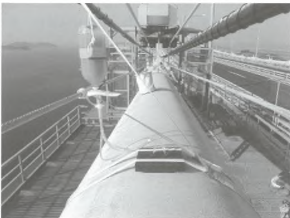
写真-8 外部浸入水調査 Photo 8 Water Seepage Test
