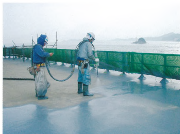
写真-2 頂版部ライニング施工状況 Photo 2 Working of resin-paint coating
