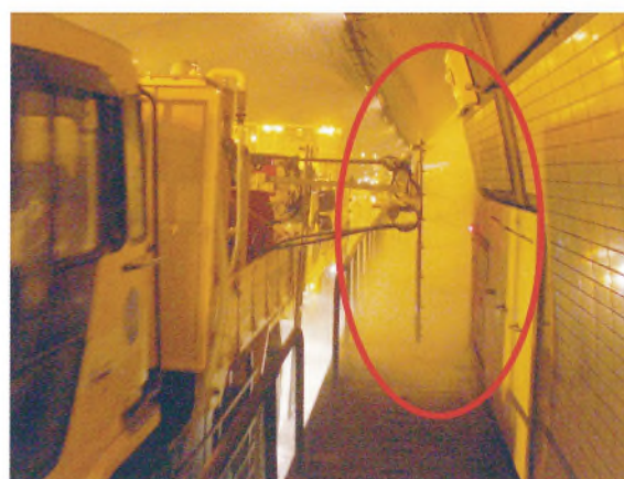
写真-4 ウォータージェットによる清掃状況 Photo 4 Cleaning by water-jet
