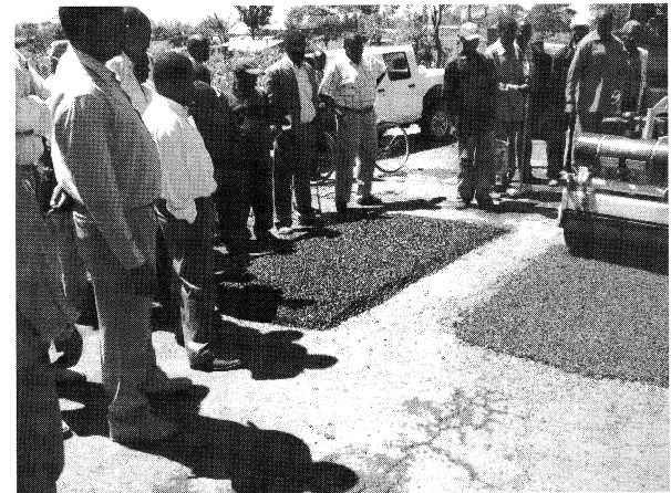
写真-4 アスファルト転圧の指導
