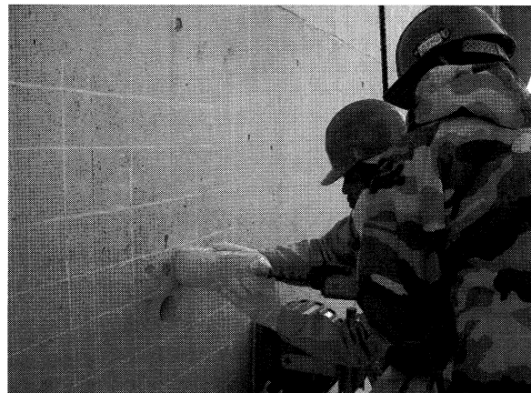
写真-6 ドリル粉の採取作業
