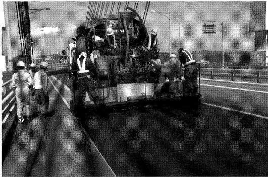
写真-1 MS工法施工状況
