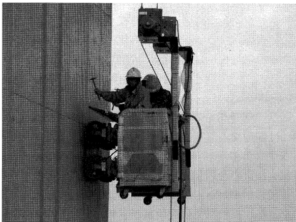
写真-5 ハンマーによるたたき点検
