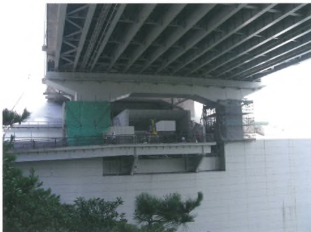
写真-5 5A 施工状況（「渦の道」入口付近） Photo.5 Working Situation (near the Entrance of Promenade)
