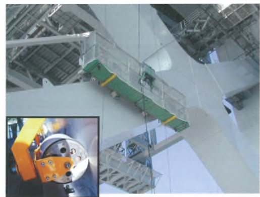
巻頭写真-21 磁石車輪ゴンドラによる主塔の全面塗 替塗装 Opening photo.21 Repainting of a main tower by using mag- netic wheel gondola ※ P 7、43、73 参照 (See page 7, 43, 73.)
