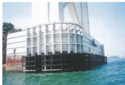
巻頭写真-26 船舶緩衝工の更新 (ゴム製から鋼製に変更)
