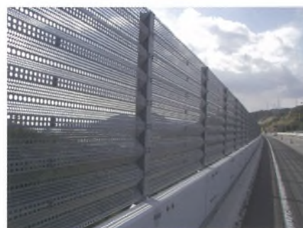
巻頭写真-28 横風対策 (遮風壁設置)
