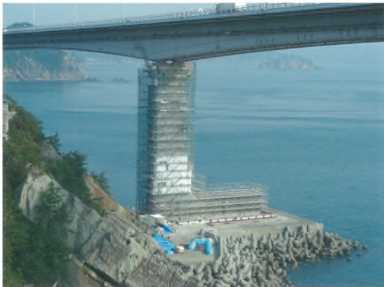
巻頭写真-40 P6橋脚試験施工現場全景 Opening photo.40 View of trial works at P6 ※ P 7、47 参照 (See page 7, 47.)
