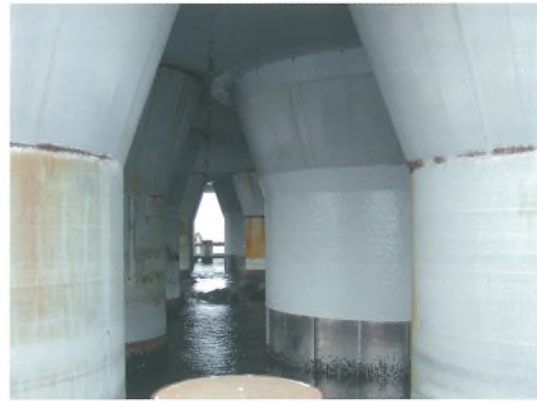
巻頭写真-32 橋脚基礎の耐震補強 (多柱基礎のチ タンライニング) Opening photo.32 Seismic upgrading for multi column piers by titan lining ※ P 7、35、62 参照 (See page 7, 35, 62.)
