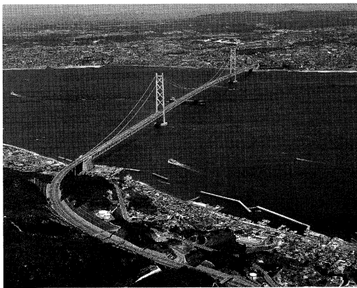
写真-1 明石海峡大橋（淡路島から望む）
