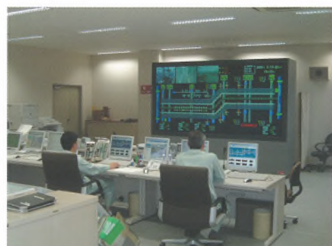
巻頭写真-37 交通管制システムの更新 (IP方式、汎用品構成)
