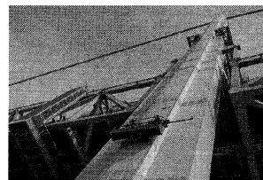
写真-2 磁石車輪ゴンドラ
