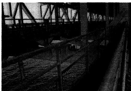
写真-12 管理路の腐食
