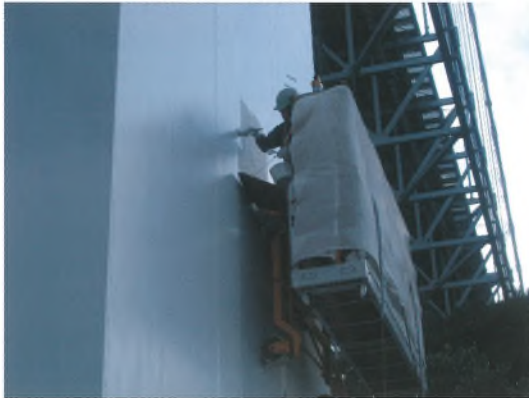
巻頭写真-47 磁石車輪ゴンドラによる3P主塔塗替塗装 Opening photo.47 Repainting work by using magnetic wheel gondola at 3P tower ※ P 43 参照 (See page 43.)
