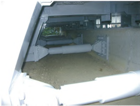
巻頭写真-38 5P制振装置設置完了 Opening photo.38 Installation of the damper at 5P ※ P 62 参照 (See page 62.)
