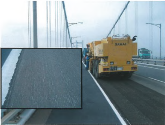
巻頭写真-45 切削オーバーレイ工 Opening photo.45 Cutting and overlay ※ P 9、68 参照 (See page 9, 68.)
