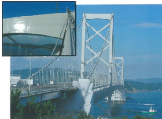
巻頭写真-10 大鳴門橋の全面塗替塗装完了 (2006)
