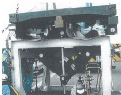
巻頭写真-27 リンク式伸縮装置改良 (橋の一体化、防振ゴム支持等)
