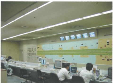
巻頭写真-37 交通管制システムの更新 (IP方式、汎用品構成)
