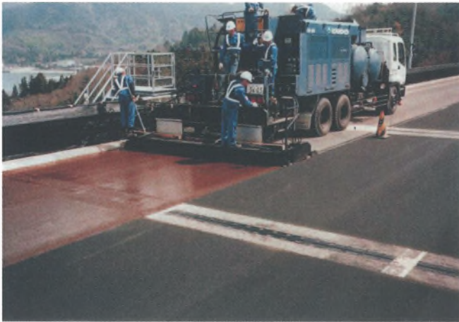
巻頭写真-35 鋼床版舗装補修 (薄層舗装工法) (1: 敷き均し状況、2: 硬化前、3: 数時間後硬化)
