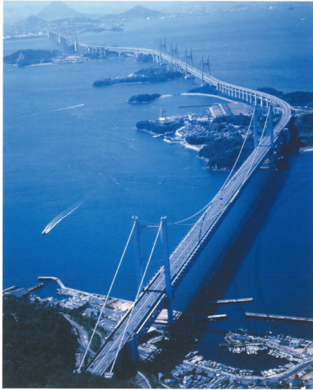
巻頭写真-3 岡山県側から望む瀬戸大橋 Opening photo.3 View of Seto-Ohashi Bridges (from Okayama Pref.)
