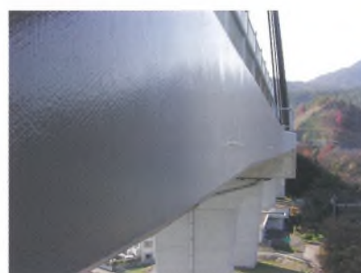
巻頭写真-25 コンクリート桁の剥落防止
