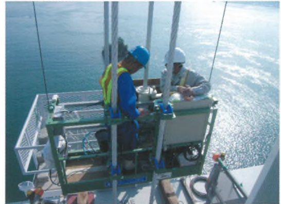
巻頭写真-48 ハンガーロープ浸漬塗装 Opening photo.48 Penetration painting for suspender ropes ※ P 35、43 参照 (See page 35, 43.)
