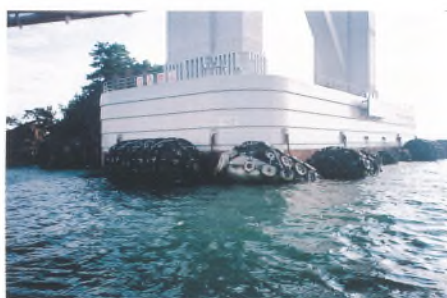
巻頭写真-26 船舶緩衝工の更新 (ゴム製から鋼製に変更)
