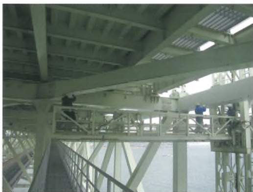
巻頭写真-20 桁外面作業車による補剛桁の部分補 修塗装 Opening photo.20 Repair painting work for stiffening girder by using maintenance vehicle ※ P 5、35、43 参照 (See page 5, 35, 43.)
