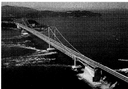
写真-1 塩害環境下にある大鳴門橋
