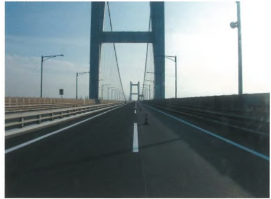
巻頭写真-46 表層舗設施工完了 Opening photo.46 Finish of casting upper layer pavement ※ P 9、68 参照 (See page 9, 68.)
