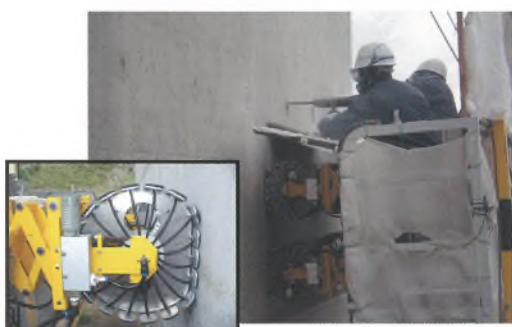
巻頭写真-24 真空吸着車輪ゴンドラによる高橋脚のコンクリート調査
