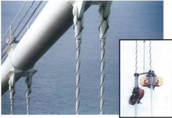
巻頭写真-17 ハンガーロープ制振対策の改良 Opening photo.17 Improvement of vibration control device for suspender ropes (installation of helical wires) ※ P 5、31 参照 (See page 5, 31.)
