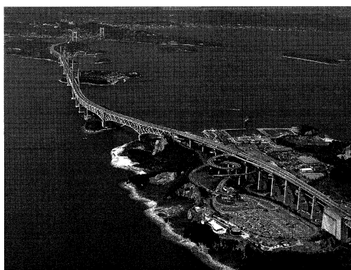
写真-1 瀬戸大橋（与島から岡山側を望む）
