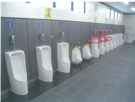
写真-42 男性トイレのリニューアル Opening photp.42 Renewal of men's toilet
