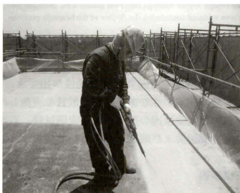
写真-7 表面被覆工の施工状況 Photo 7 Surface coating work
