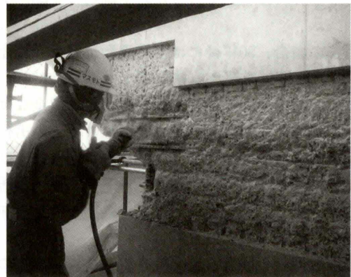
写真-5 はつり工の施工状況 Photo 5 Concrete chipping work
