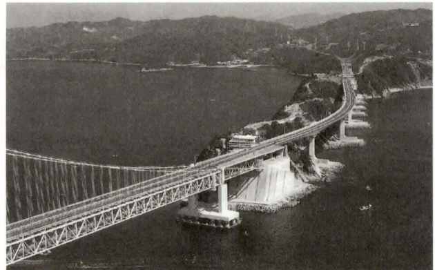
写真-1 門崎高架橋 Photo 1 Tozaki Viaduct
