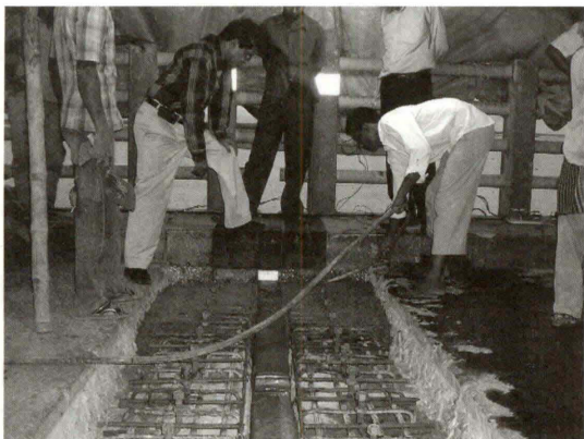
写真-7 コンクリートの打設
