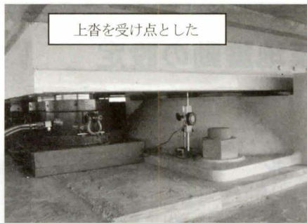
写真-6 ジャッキセット状況 Photo 6 Jack set up
