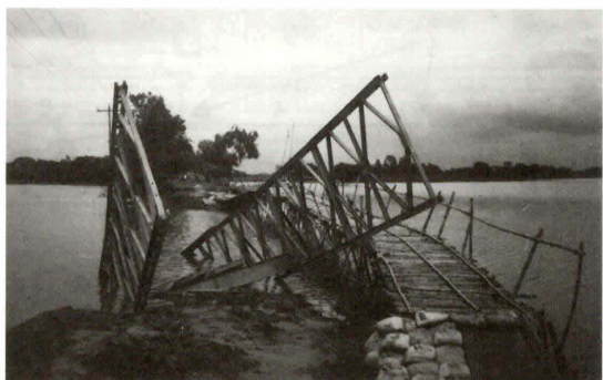
写真-4、5 橋台を設けずに設置したベイリー橋と2007年洪水による落橋
