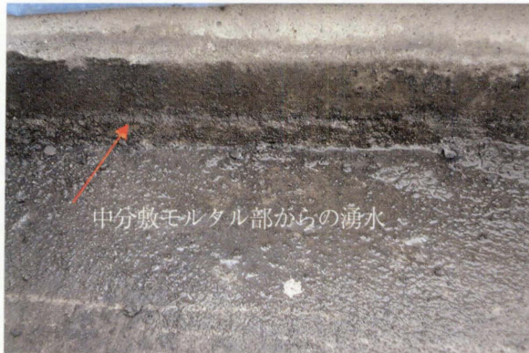
写真-10 中分縁石敷モルタル部 Photo 10 Mortar under median curb
