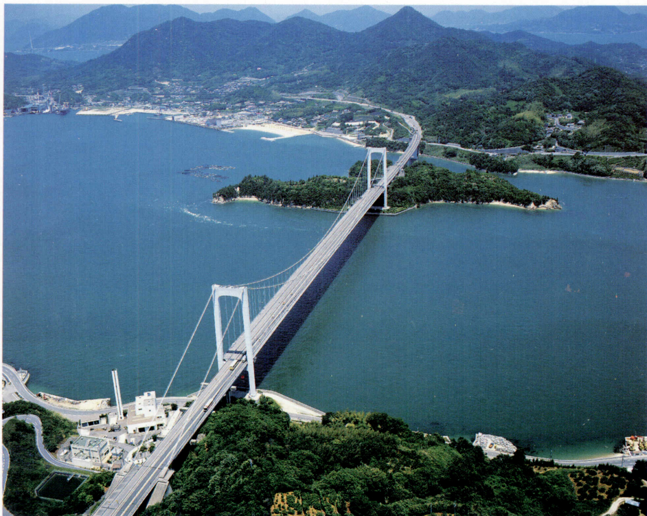
巻頭写真-6 伯方・大島大橋 Opening Photo 6 Hakata-Ohshima Bridge
