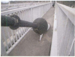
写真-4 水切板設置 Photo 4 Creasing plate
