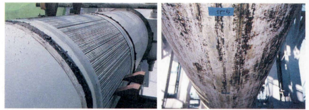
(a)第一大橋(2007年) (b)北備讃瀬戸大橋 4) (1996年) 写真-1 ケーブル開放調査状況(供用約8年) (送気乾燥システムの有無による比較)
