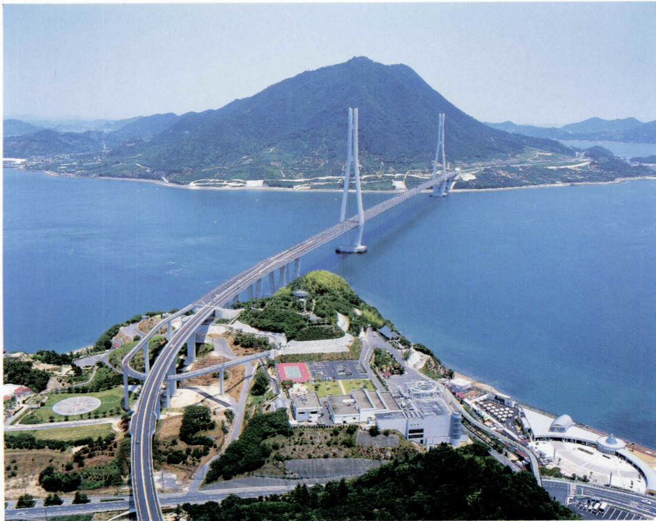
巻頭写真-4 多々羅大橋 Opening Photo 4 Tatara Bridge
