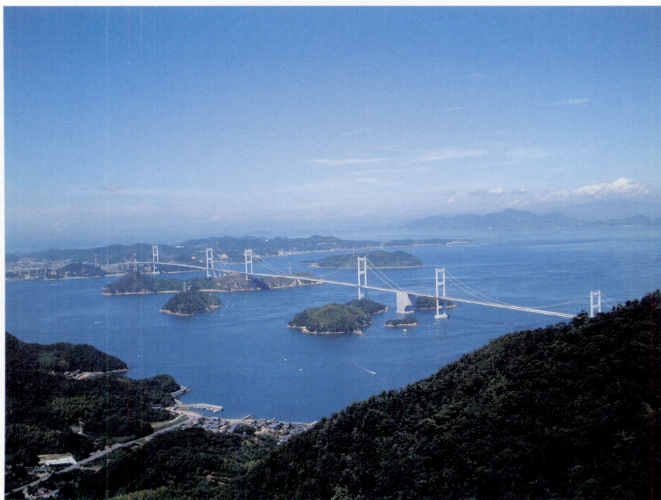
巻頭写真-7 来島海峡大橋
