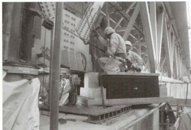
写真-4 因島大橋東高架橋の耐震補強工事
