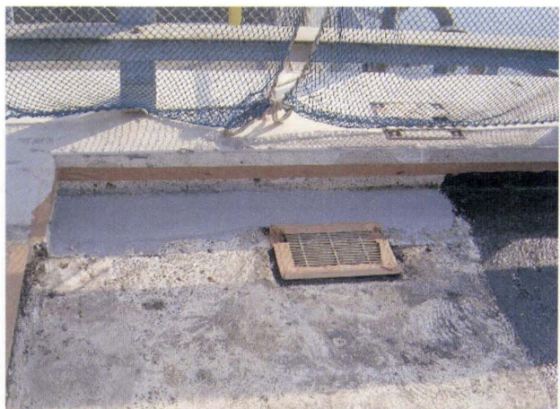
写真-3 樹脂モルタルによる補修状況
