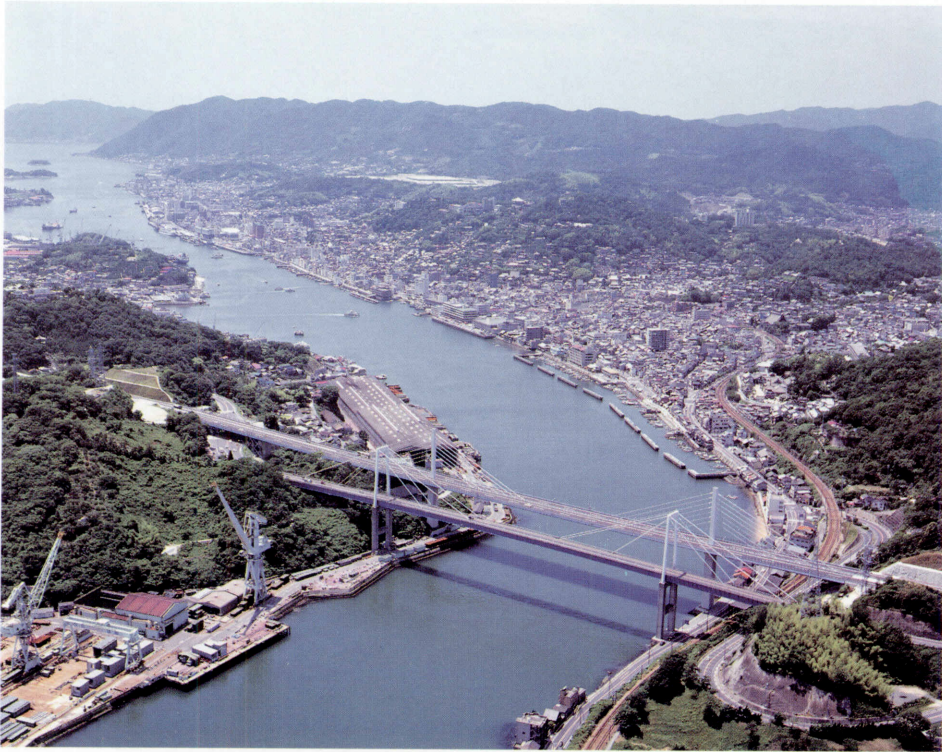
巻頭写真-1 新尾道大橋 (写真奥側) Opening Photo 1 Shin-Onomichi Bridge
