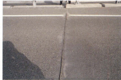
写真-8 接合部の路面状況 Photo 8 Surface at connections
