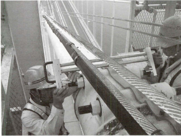
写真-1 ボルト軸力調査状況 (大島大橋) Photo 1 Investigation situation of axial force
