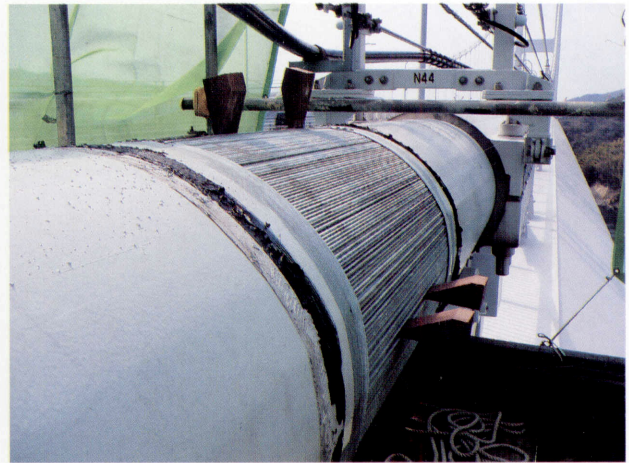
巻頭写真-16 来島海峡大橋ケーブル開放調査
