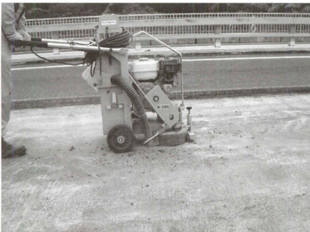
写真-1 ハンドガイド式床版研磨機 Photo 1 Hand guide type deck grinder
