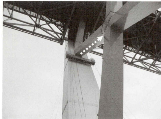
写真-4 斜材下面の塗替作業
