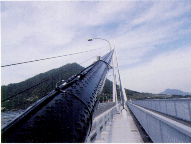
巻頭写真-13 多々羅大橋ケーブル振動計測
