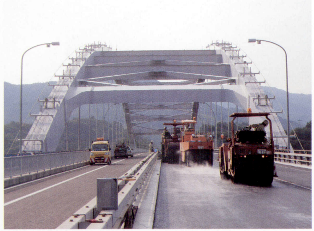
巻頭写真-14 大三島橋舗装施工状況
