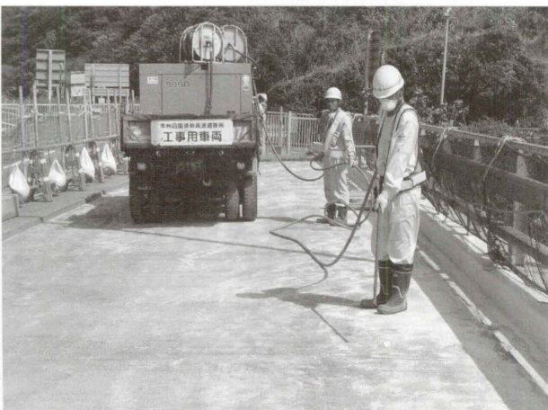
写真-2 圧縮空気による床版清掃状況 Photo 2 Cleaning of deck by using compressive air
