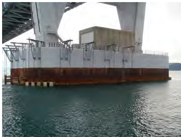
写真-5 電着設備 (櫃石島橋 2P)
