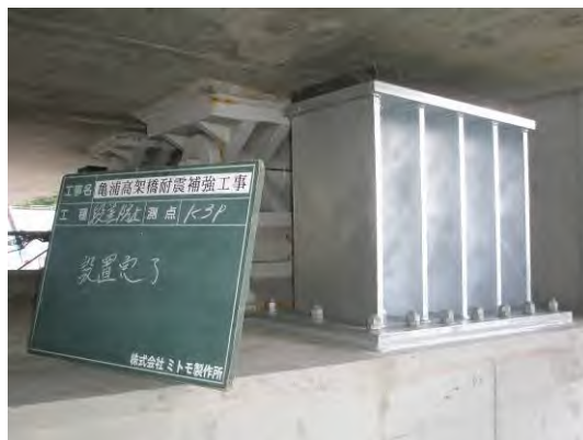
写真-4 段差防止構造設置状況 (3P)
