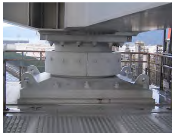
写真-1 番の州高架橋のピボット支承（BVa2P）
