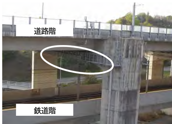
写真-1 試験施工（櫃石島高架橋） Photo 1 Trial construction (hitsuishijima viaduct)
