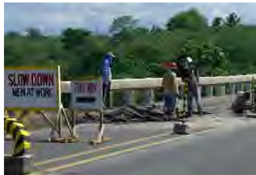
写真-4 橋面舗装剥ぎ取り作業 Photo 4 Remove Asphalt overlay
