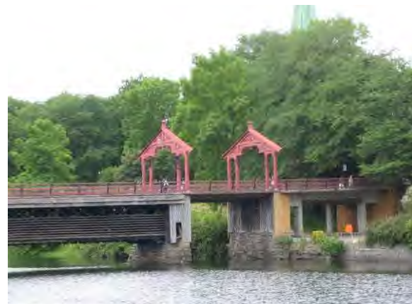
写真-4 トロンハイム市内の河川に架かる跳ね橋（橋梁の端部に昇開部があり船舶の通行可能）
