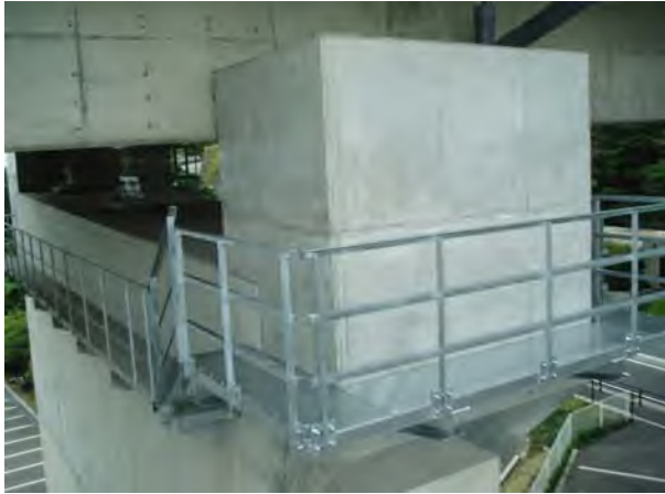
写真-6 変位制限構造 設置状況 (3P)
