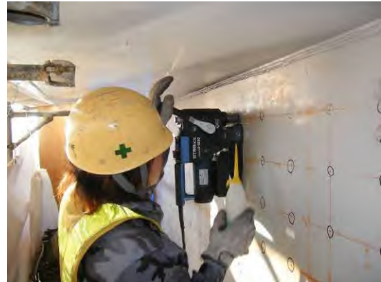
写真-6 孔明け作業状況
