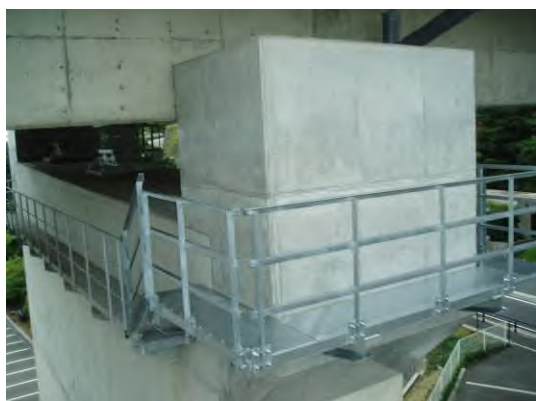
写真-3 変位制限構造設置状況 (3P)
