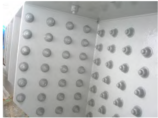
写真-9 ボルトキャップ施工状況 Photo.8 Execution of the bolt-cap
