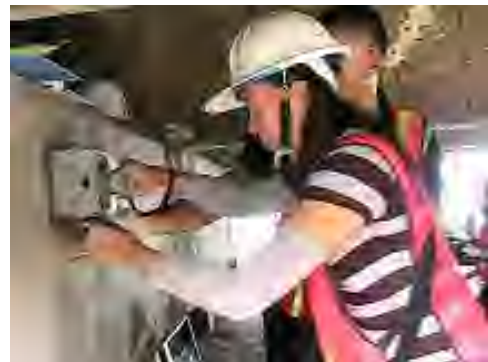
写真-9 鉄筋探査計を使用しでの訓練 Photo 9 Field Training of Reinforcing bar Detector
