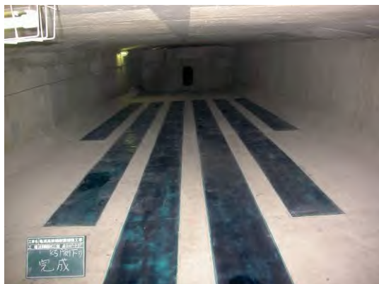
写真-1 炭素繊維シート貼付状況 (4P-5P 間桁内)
