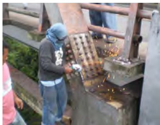
写真-5 ケレン作業 Photo 5 Remove Rust
