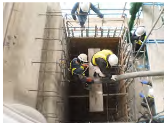
写真-3 コンクリート打設状況
