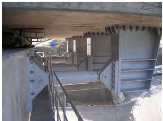
写真-5 制振装置設置状況(1A)
