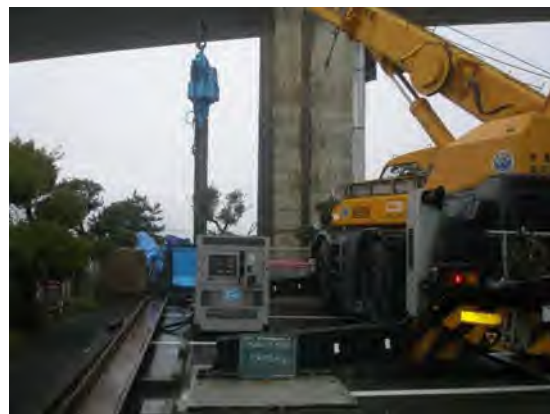
写真-2 鋼矢板打設状況
