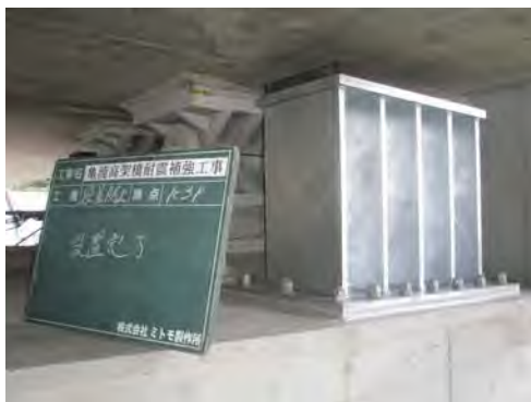
写真-7 段差防止構造 設置状況 (3P)
