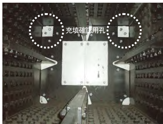
写真-5 主構下弦材内部の密閉状況
