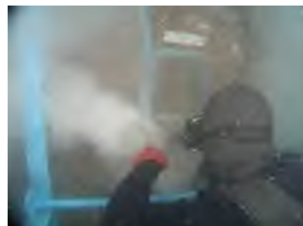
写真-2 北備讃瀬戸大橋 (BB3P) 試験片採取状況
