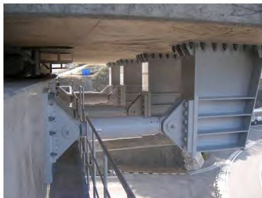
写真-2 制振装置設置状況(1A)
