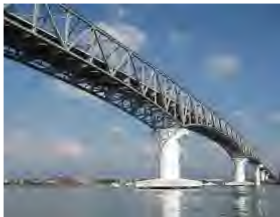
写真-1 マンダウエマクタン橋
