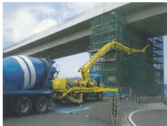
写真-3 コンクリート打設状況(3P)
