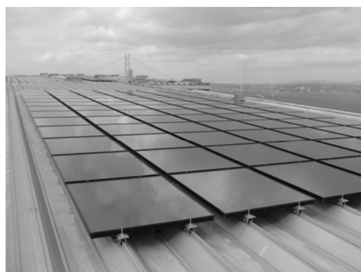
写真-2 太陽電池モジュール屋根取付状況 (淡路サービスエリア下り線)
