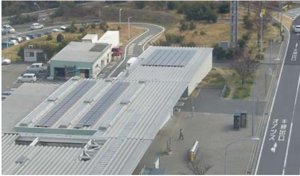
写真-1 太陽電池モジュール設置状況
