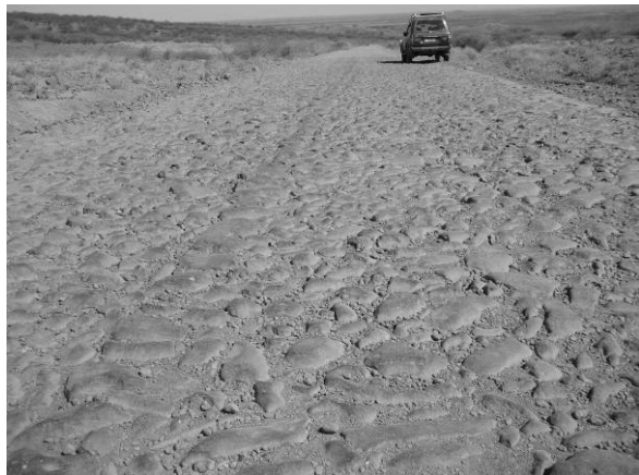
写真-2 石を敷き詰めた道路 Photo 2 Stone Paved Road
