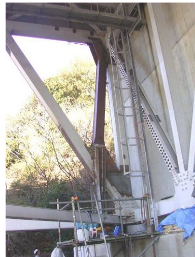
写真-4 端支点部ジャッキアップ補強状況 (1A)
