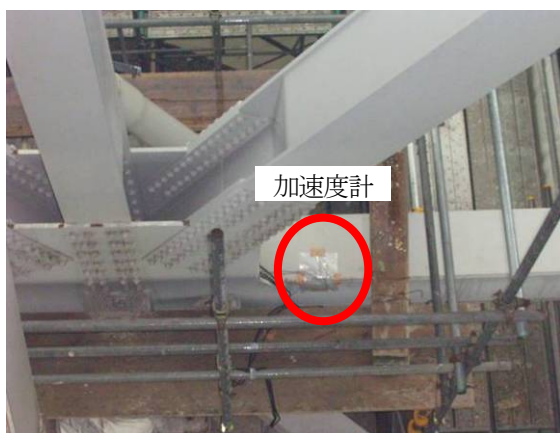
写真-5 加速度計設置状況 (3P)
