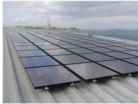
写真-2 太陽電池モジュール屋根取付状況
