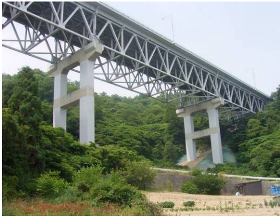
写真-3 橋脚補強工完了 (2P・3P)
