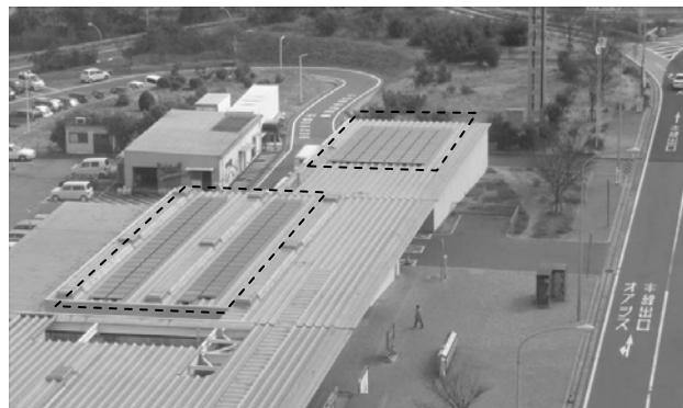
写真-1 太陽電池モジュール設置状況 (淡路サービスエリア下り線)
