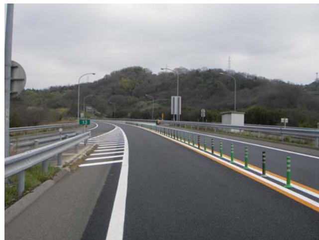
写真-8 因島北IC区間 完成状況
