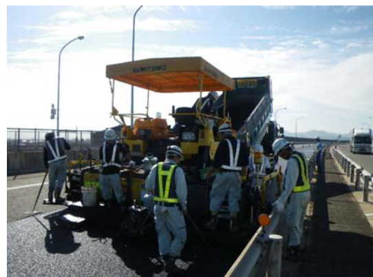
写真-5 表層工施工状況
