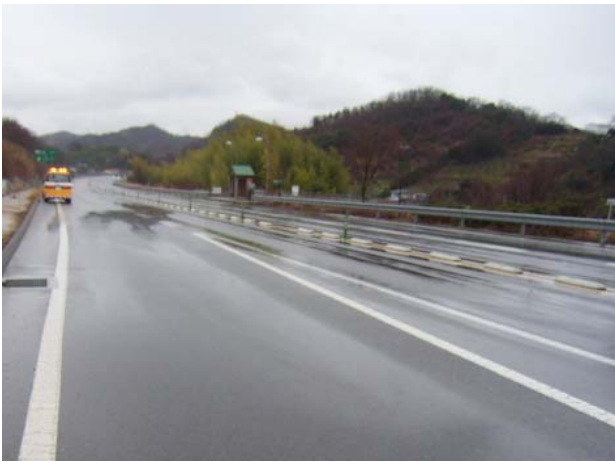
写真-1 向東BS区間補修前（滞水状況） Photo.1 Mukai-higashi Bus Stop (puddles)
