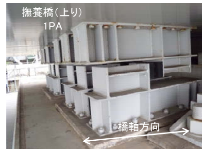
図-10 既設落橋防止構造(撫養橋 1PB)
