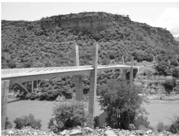
写真-5 アバイ・ヘダセ橋 Photo 5 Abay Hedase Bridge
