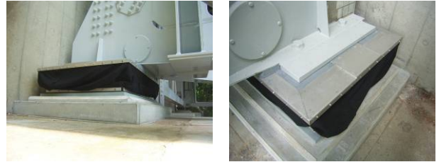
写真-9 支承カバー設置状況 (1A)
