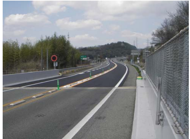
写真-7 向東BS区間 完成状況
