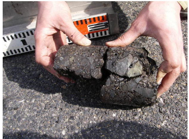
写真-5 コア状況 Photo.5 Core sample
