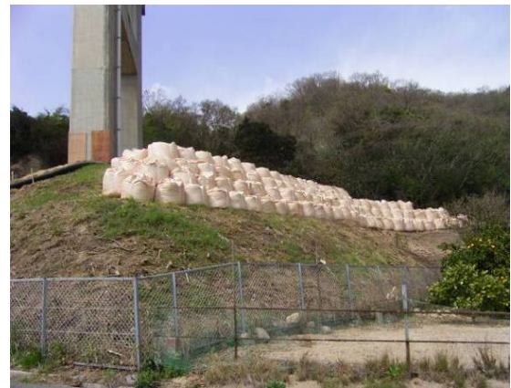
写真-1 大型土嚢設置状況 (3P)
