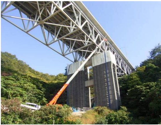
写真-7 60tクレーンによる支承吊上げ状況 (2P)
