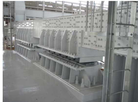
写真-3 主横トラス下弦材部変位制限構造設置状況
