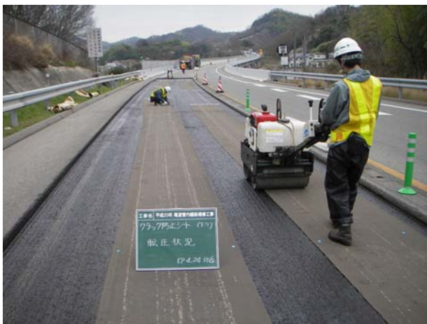
写真-6 クラックシート施工状況
