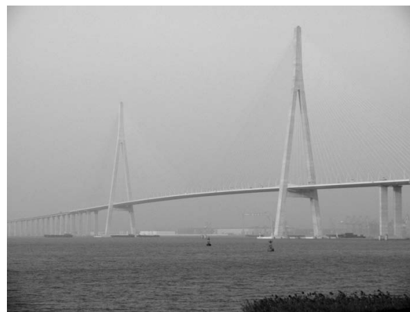
写真-4 蘇通長江公路大橋 (2008年完成)
