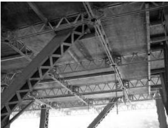
写真-8 クイックデッキと呼ばれる仮設足場
