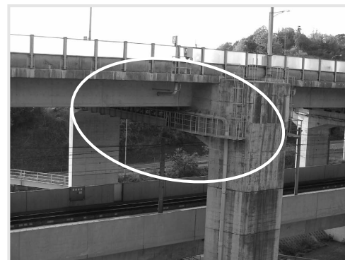
写真-3 試験施工③：櫃石島高架橋
