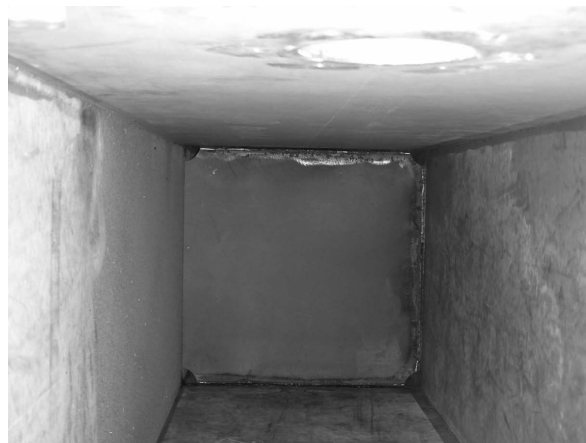
写真-3 密閉断面内の状況
