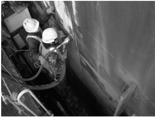
写真-8 ブラスト状況 Photo.8 Situation of blasting
