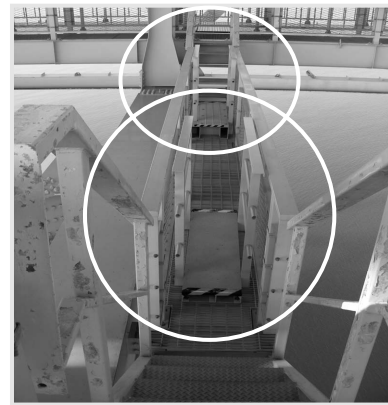
写真-1 試験施工①：大鳴門橋
