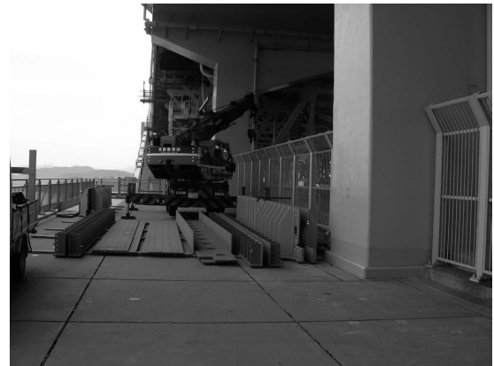
写真-1 1Aアンカレイジ上屋天端での補強部材搬入状況
