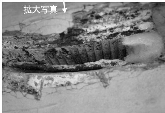
写真-4 主ケーブル Photo 4 Main Cable
