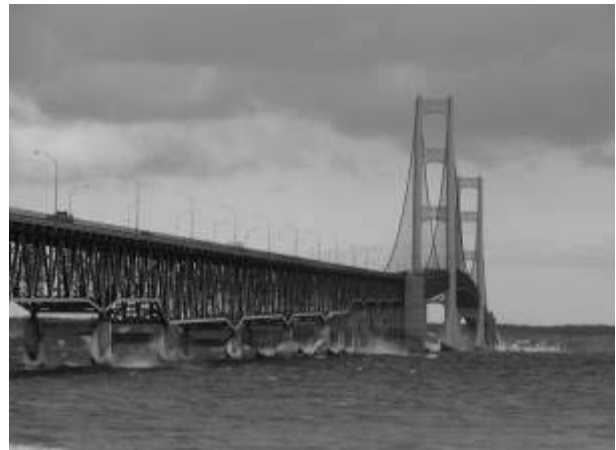
写真-19 マキノ橋 Photo-19 Mackinac Straits Bridge
