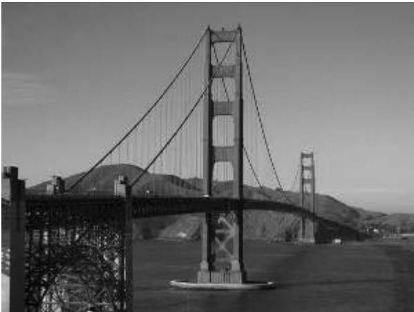
写真-1 ゴールデン・ゲート橋 Photo-1 Golden Gate Bridge
