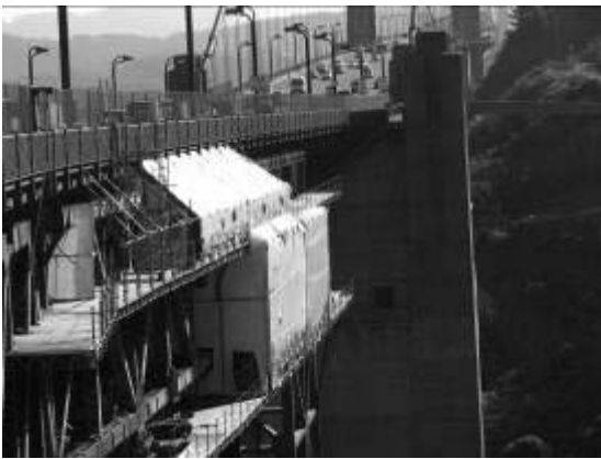
写真-7 北高架橋の塗替塗装作業状況
