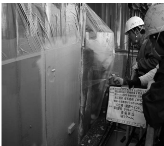
写真-9 スプレー塗装 Photo.9 Spray coating
