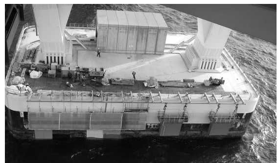
写真-5 施工状況の全景(北面)
