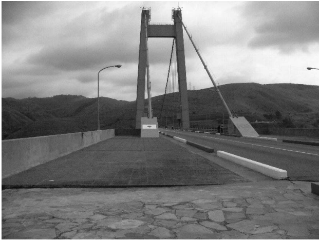
写真-2 マタディ橋 近景 Photo 2 Matadi Bridge
