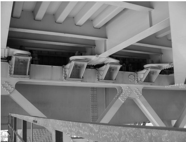
写真-5 道路桁変位制限構造設置状況 Photo 5 The displacement limiting device
