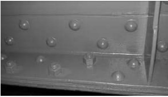
写真-6 リベットをボルトに交換した部材
