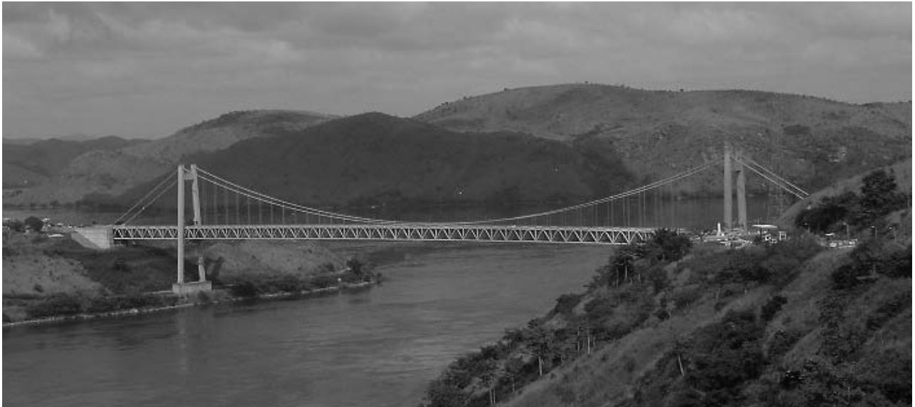
写真-1 マタディ橋 遠景 Photo 1 Matadi Bridge
