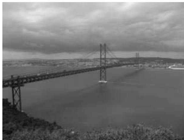
写真-4 4月25日橋 （Lisbon Congress Center の近傍に位置）
