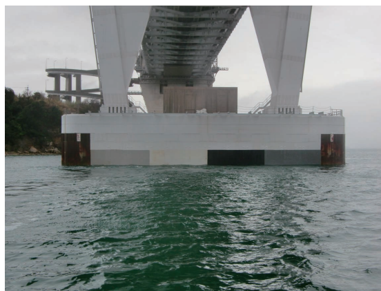
写真-2 試験施工完了後 After corrosion protection work
