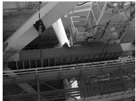
写真-2 1A下弦材の補強部材取付状況
